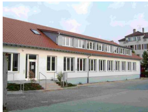
Abb. 2: Das Gebäude nach der Sanierung. Links der Anbau im Süden. Quelle: Ebök
