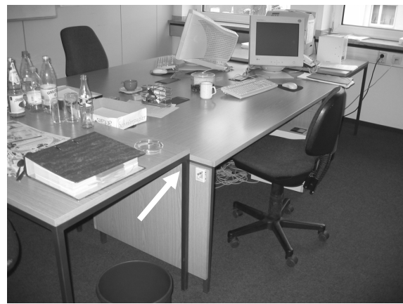
Abb. A8.1.1-2: Einbausituation der Logger, Bsp. Raum 213, Gebäude W
