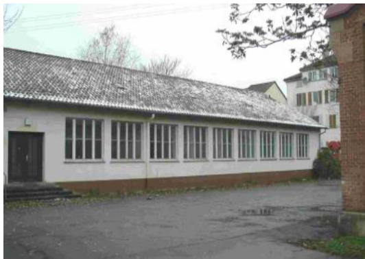
Abb. 1: Das Gebäude vor der Sanierung. Quelle: Ebök
