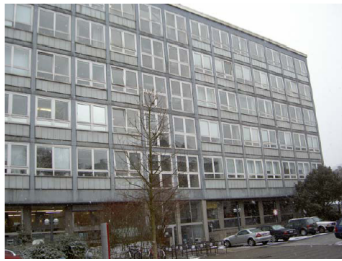
Abb. A5.1.2-1: Universität Wuppertal, Campus Haspel, Gebäude HC
