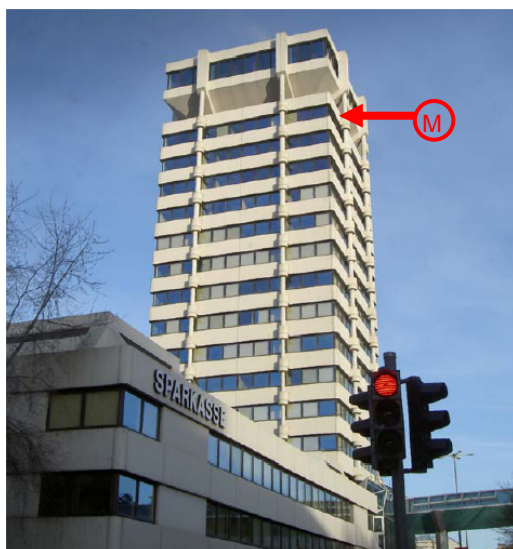
Abb. A5.1.2-17: Wuppertaler Stadtparkasse Verwaltungshochhaus
