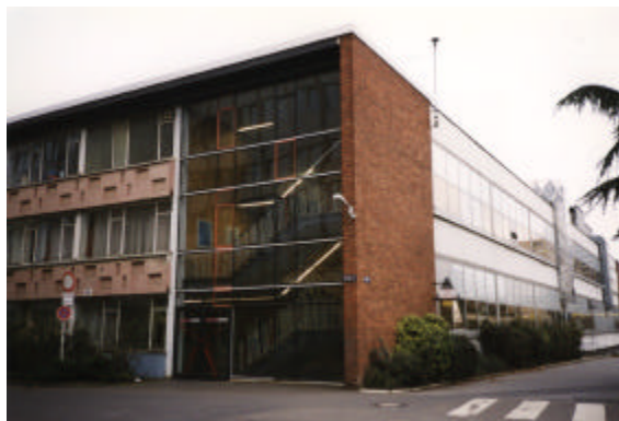
Abb. 4.6.4: Leybold, Kopfbau, Treppenhaus F: Aufn. d. Verf., 1999
