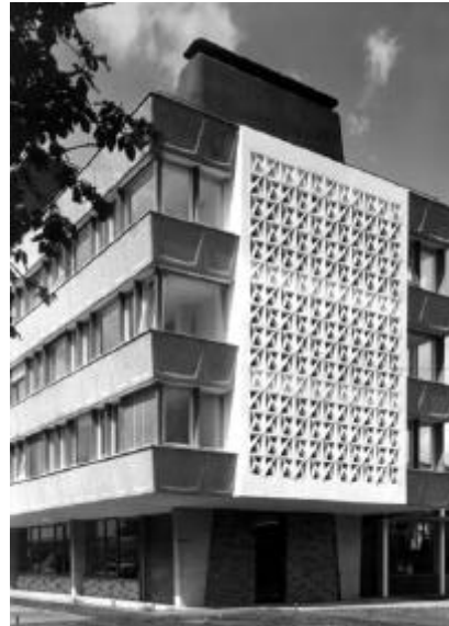
Abb. 4.1.6: Zementverband Düsseldorf, 1955/56 Fassade F: Julius Söhn Q: PNF
