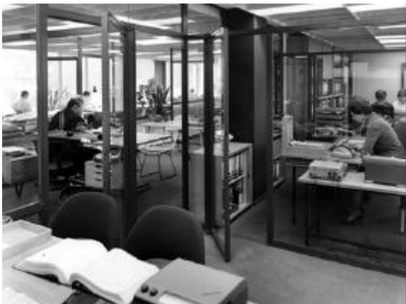
Abb. 6.4: Büro Weyerstraße, Innenansicht Q: PNF
