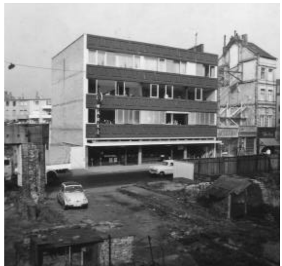
Abb. 6.1: Büro Weyerstraße im Bau, 1960 Q: PNF
