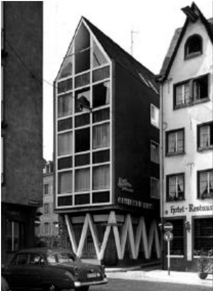
Abb. 4.3.3: Lintgasse, Außenansicht, 1958/59 Q: PNF
