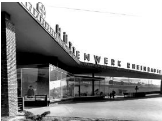
Abb. 4.6.21: Hüttenwerk Rheinhausen, Toranlage, 1957 Q: PNF
