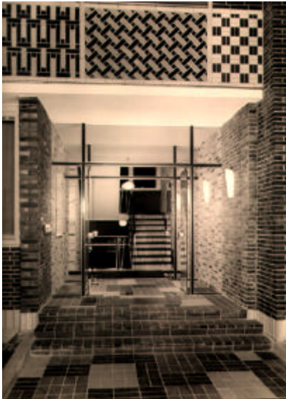
Abb. 4.1.5: Haus der Ziegelindustrie, Bonn, Eingang und Treppenhaus Q: PNF
