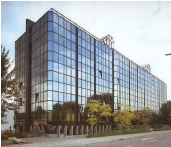
Abb. 4.7.4: Bürohaus Aachener Straße, 1983/84 Q: PNF
