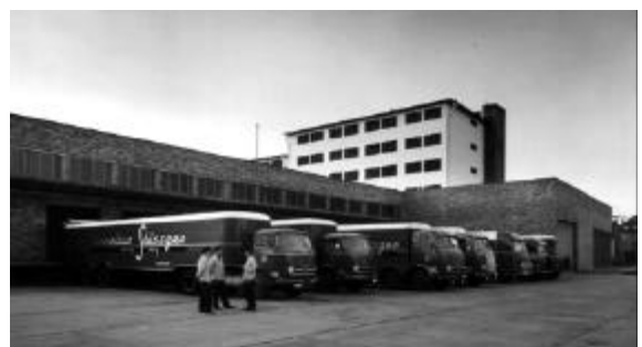
Abb. 4.4.2: Stüssgen Lagergebäude, 1959 Nord-West Ansicht Q: PNF
