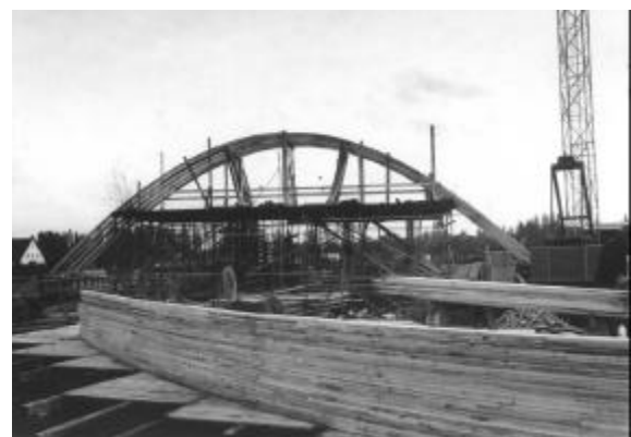
Abb. 4.2.12: Wohnhaus X1, im Bau, 1962 Q: PNF
