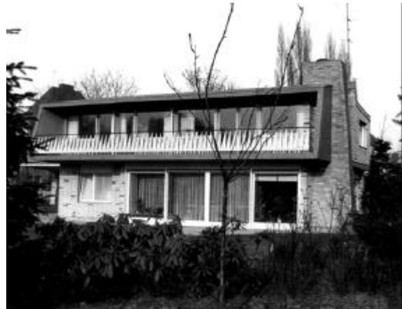
Abb. 4.2.30: Wohnhaus Machill, Gartenansicht, 1958 Q: PNF
