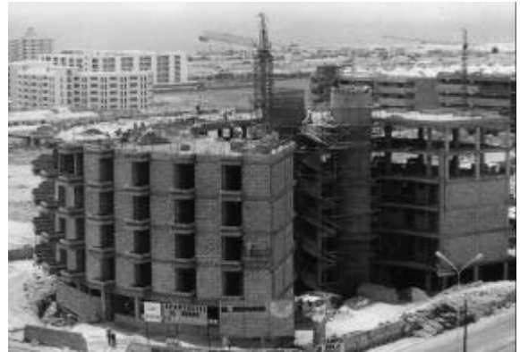
Abb. 4.11.2: "Il Rondo" im Bau, Gran Canaria F: PNF
