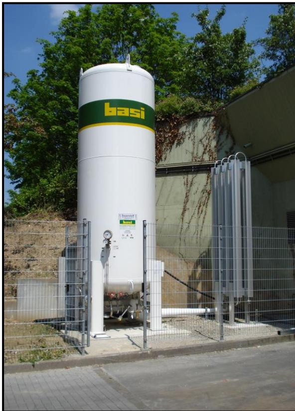
Abbildung 17: Tankversorgungsanlage mit Rippenrohrverdampfer für medizinischen Sauerstoff (LOX) im Städtischen Klinikum Rastatt. Quelle: „basi Schöberl“ Bildarchiv
