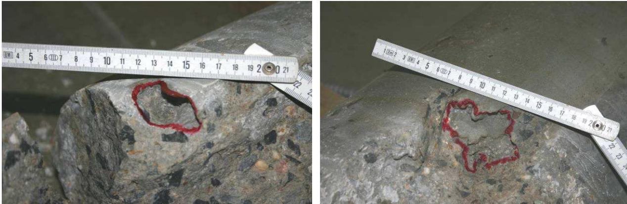
**Abb. 13** Stütze OK2: Lufteinschlüsse in der Betonfüllung
