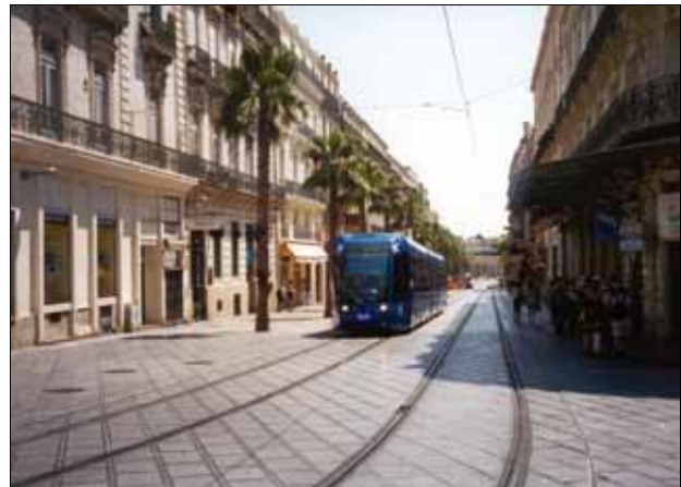
Abb. 63: Hochwertige Auspflasterung der Gleiszone in der Fußgängerzone von Montpellier
