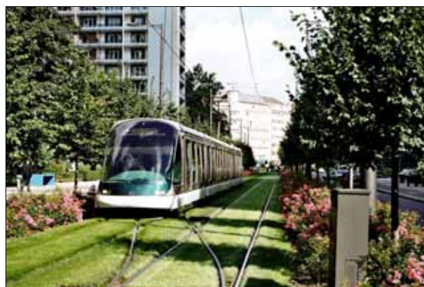
Abb. 189: Linie C, Einfahrt zur Station Esplanade
