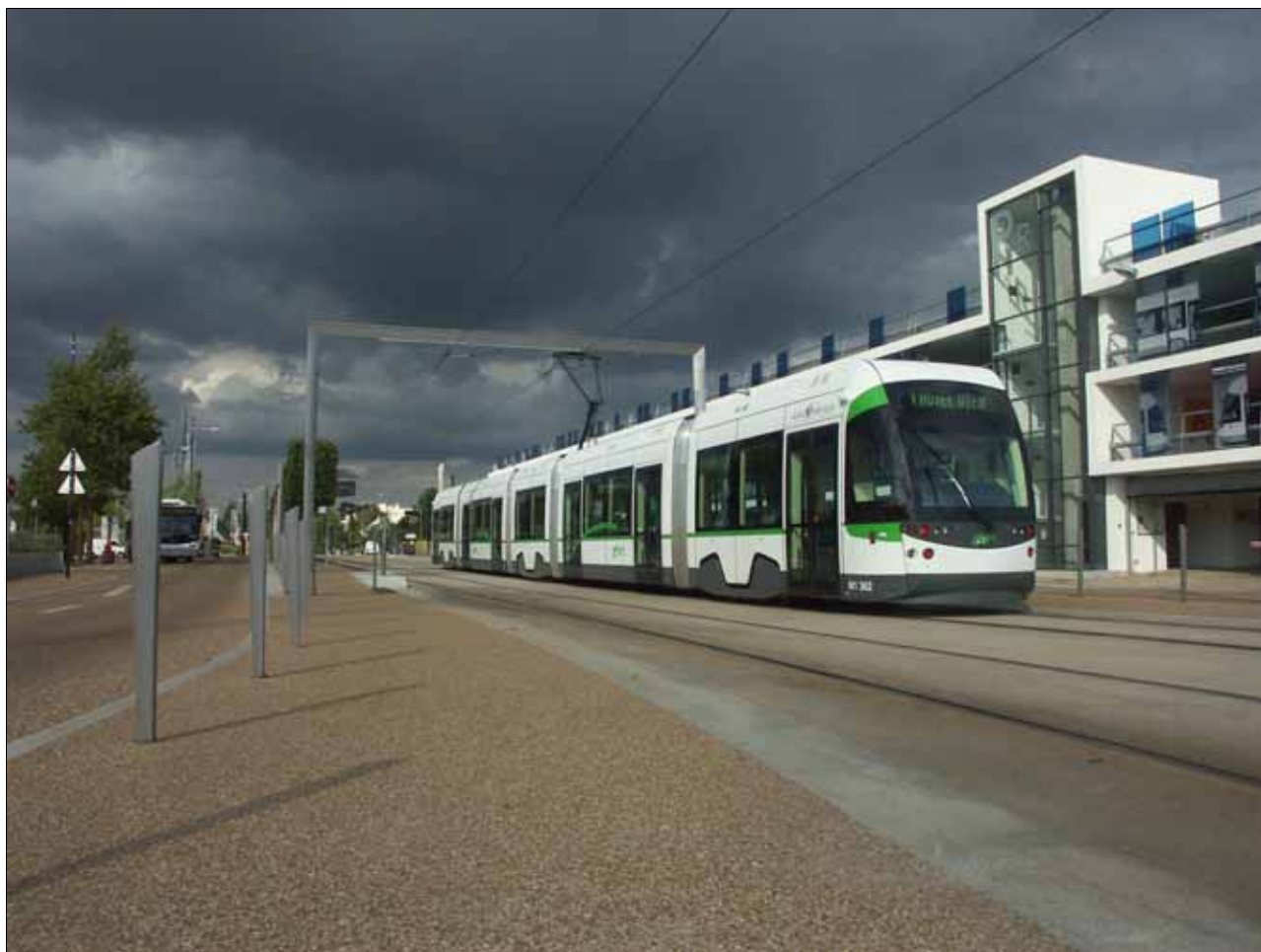
Abb. 150: Nach deutschem Recht unzulässig – Straßenbahn auf besonderem Bahnkörper mit nicht punktuell beschränkter Querbarkeit für Fußgänger, Beispiel Nantes; Kraftfahrzeugverkehr ist selbstverständlich auch bei diesem Beispiel im Zuge des Bahnkörpers ausgeschlossen
