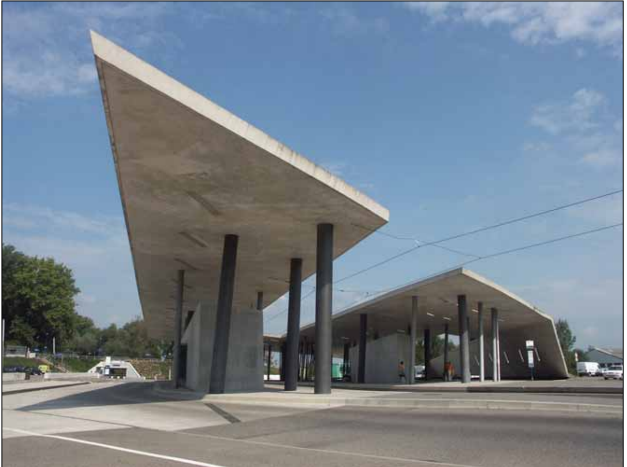
Abb. 168: Verknüpfungspunkt Hoenheim Gare in Straßburg, entworfen von der Stararchitektin Zaha Hadid
