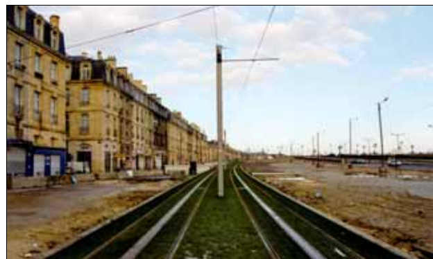
Abb. 112: Bordeaux, Einbindung einer Straßenbahntrasse ohne Oberleitung in eine Platzfläche
