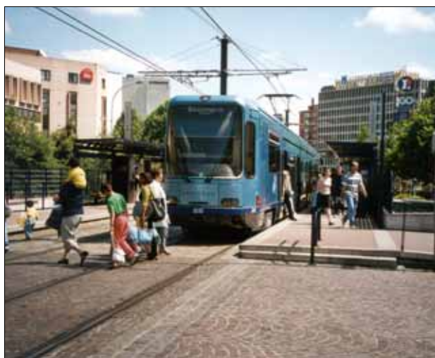
Abb. 95: Rouen – Am Einkaufszentrum Saint-Sever liegt statt der Straßenbahn die Straße im Tunnel. Es bestehen so niveaugleiche direkte Wege ohne kreuzenden Straßenverkehr vom Geschäftsbereich zur Haltestelle
