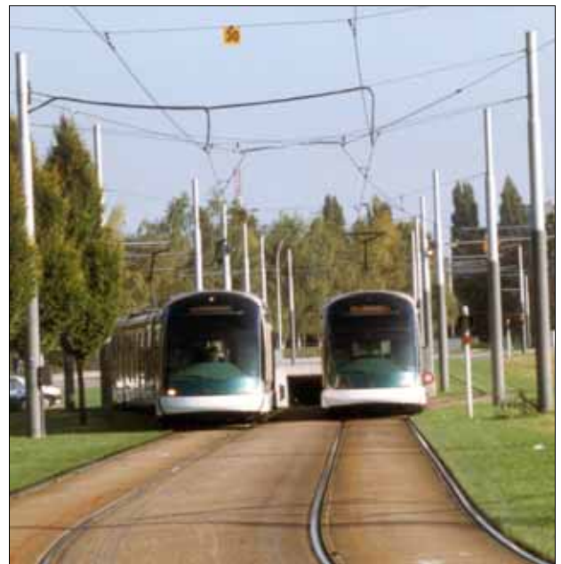
Abb. 119: Straßburg – hohe Baukosten durch weitreichende Gestaltungsmaßnahmen sowie stellenweise unterirdische Führung
