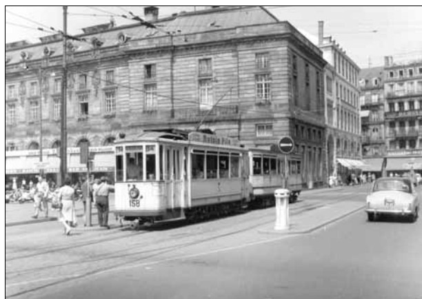
Abb. 9: Trotz des im nationalen Vergleich sehr guten Ausbauszustandes konnten sich auch die Straßenbahnbetriebe des Elsass nach dem zweiten Weltkrieg nicht behaupten. In Straßburg war die 1960 vollzogene Stilllegung der Straßenbahn jedoch letztendlich nur eine Episode, hier feierte 34 Jahre später die Straßenbahn moderner Prägung ihren endgültigen Durchbruch. Das Bild zeigt die Linie 14 am 10. Juli 1959 auf der Place Kléber.
