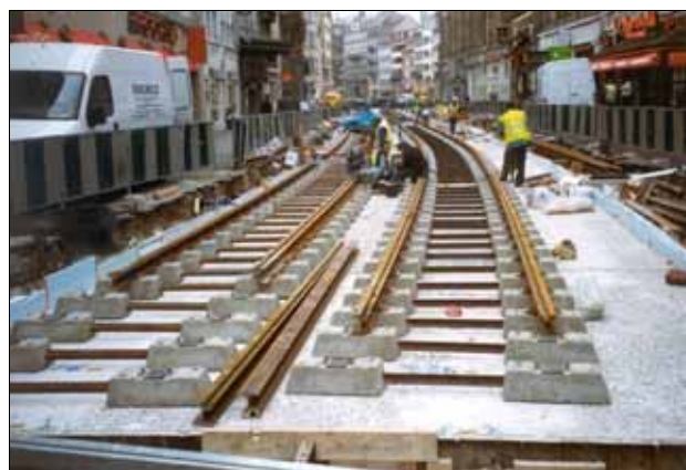
Abb. 24: Die reine Bauzeit neuer Straßenbahnstrecken dauert selten länger als anderthalb Jahre – auf der 1999 im Bau befindlichen zweiten Straßburger Stammstrecke fahren heute die Linien B/C
