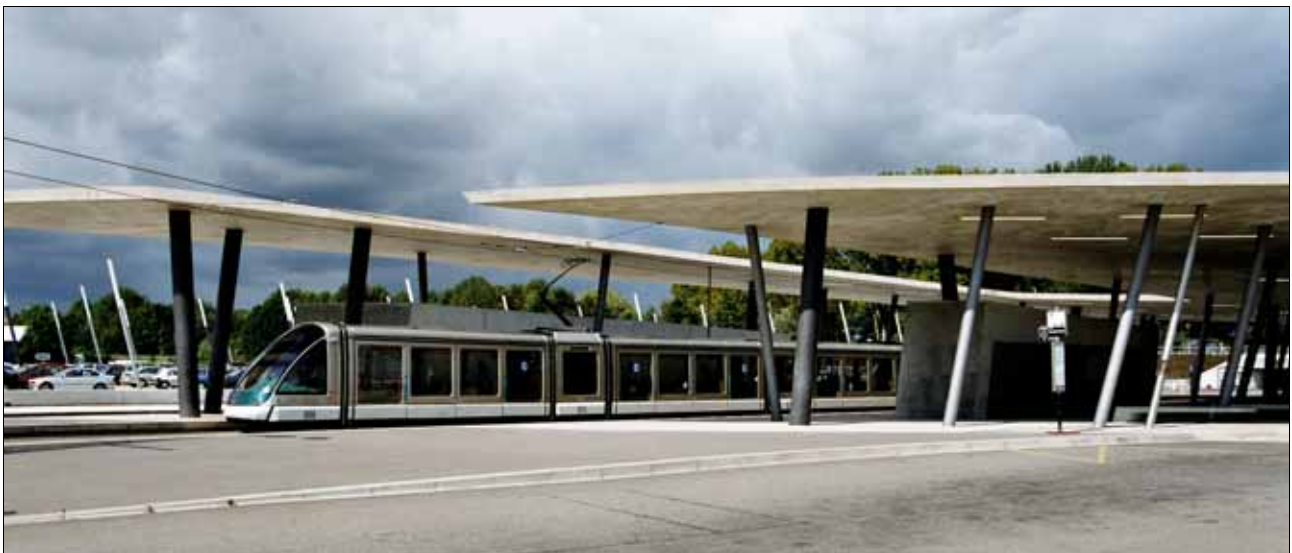
Abb. 91: Straßburg – Verknüpfungshaltestelle Hoenheim Gare
