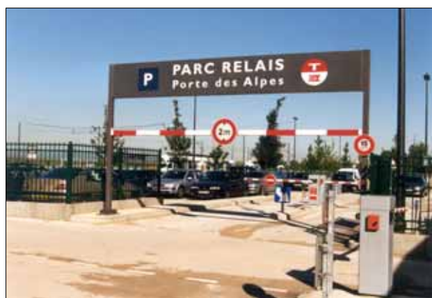
Abb. 125: P&R-Anlage Porte des Alpes in Lyon
