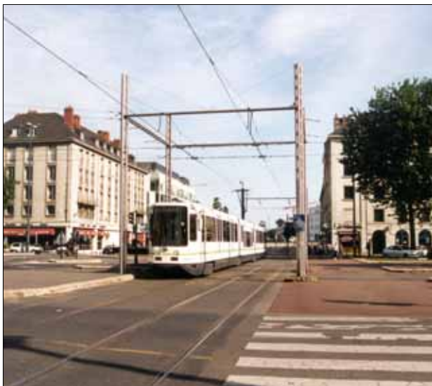
Abb. 110: Nantes – filigrane Oberleitungskonstruktion am Kreuzungspunkt Commerce
