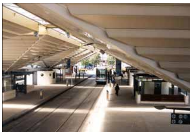
Abb. 122, 123, 124: Knoten Grand'Place in Grenoble mit bahnsteiggleichem Umstieg, eigenwilliger Gestaltung und direktem Zugang zum angrenzenden Einkaufszentrum
