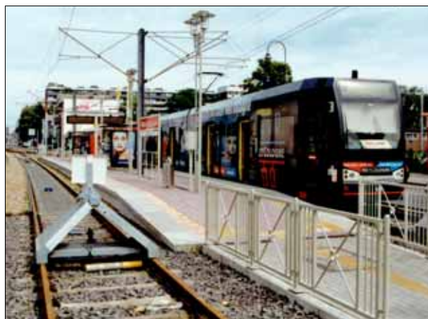
Abb. 82: keine Oberbaugestaltung, Übergang Anrampung und Oberbau nicht bündig
