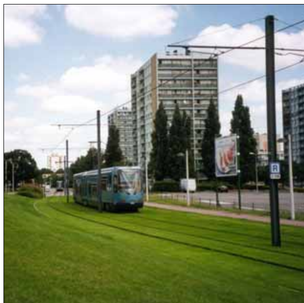
Abb. 42: Rouen – Im Vorort Saint-Etienne-du-Rouvray diente die Einführung der Straßenbahn u.a. der Aufwertung eines Problemviertels. Die Trasse wurde optisch ansprechend gestaltet und mit Rasengleis versehen.
