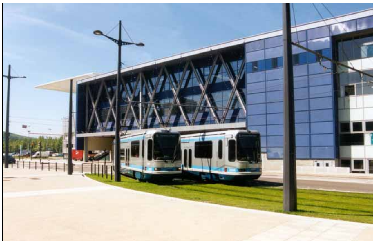
Abb. 179: Grenoble, Zugbegegnung vor der überbauten Station Alpeexpo
