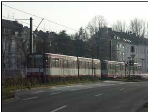
Abb. 158: Hochkettenfahrleitung schaffen ein eher eisenbahnartiges Erscheinungsbild, durch die stetige Abfolge von weniger wuchtigen Stahlmasten in Mittellage kann dieser Effekt aber reduziert werden, Beispiel Düsseldorf
