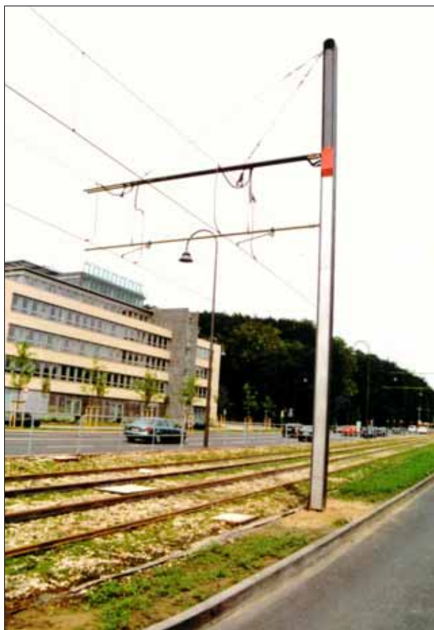
Abb. 77: kein gestalterischer Anspruch bei Oberbau und Oberleitung
