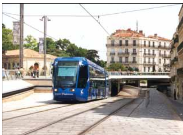
Abb. 57, 58: Montpellier – durch Ausnutzung von Geländesprüngen und besondere Materialwahl hervorragende Einbindung eines vermeintlich städtebaulich nicht integrierbaren Rampenbauwerks in die zentrale Altstadt
