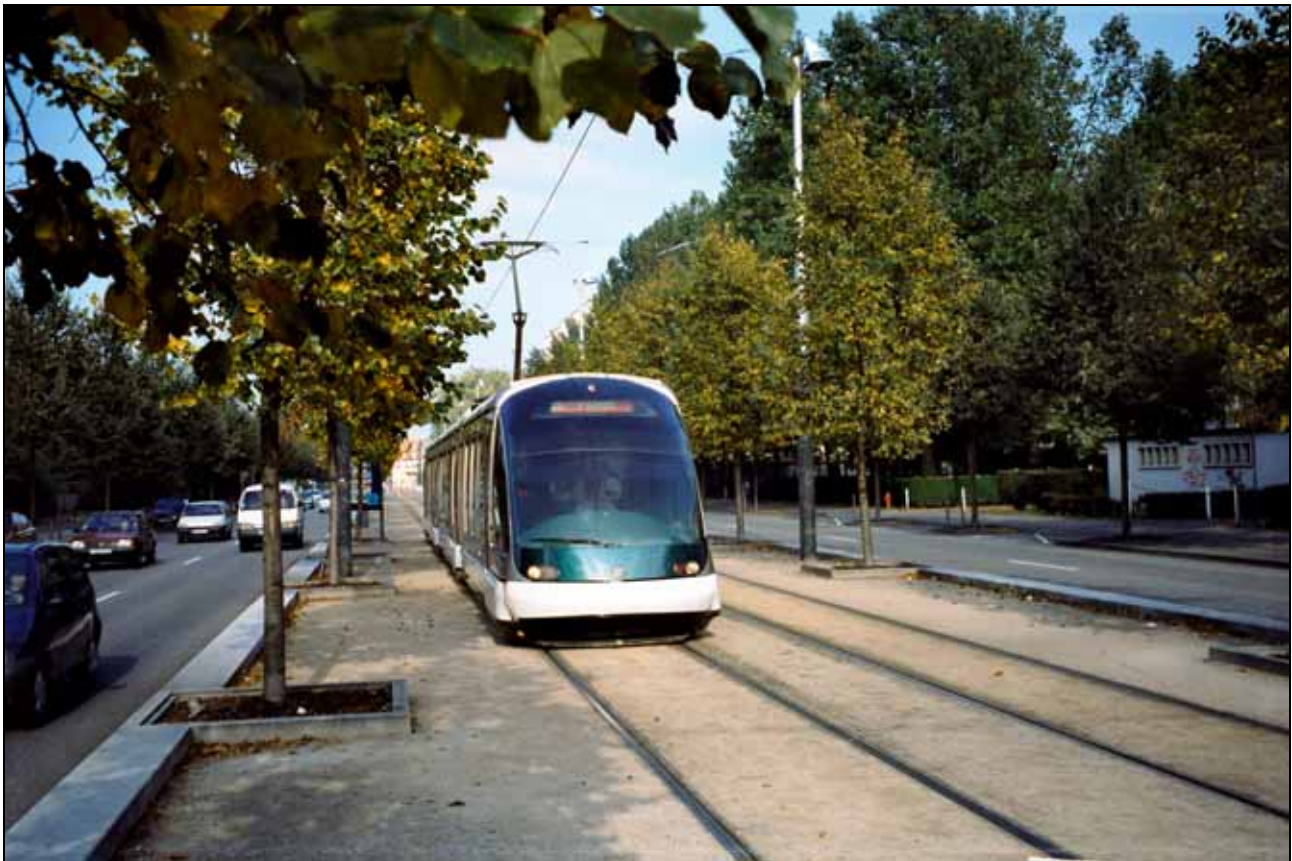
Abb. 67: Straßburg – In Meinau verläuft die Linie A in Mittellage einer breiten Ausfallstraße. Der Bahnkörper ist so breit, dass Bahnsteige und Abbiegespuren ohne Änderung des Straßenquerschnittes neben den Gleisen Platz finden, so dass es keinerlei optisch störende Versprünge im Straßenquerschnitt gibt. Abseits von Knoten wird der gewonnene Raum dazu genutzt, die Trasse mit Bäumen zu flankieren.
