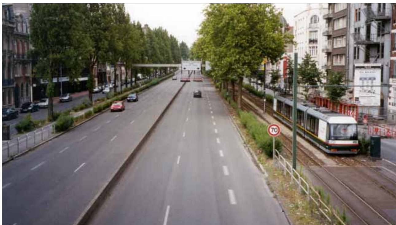
Abb. 12: Lille – Erhalt dank großzügiger Trassierung auf eigenem Bahnkörper
