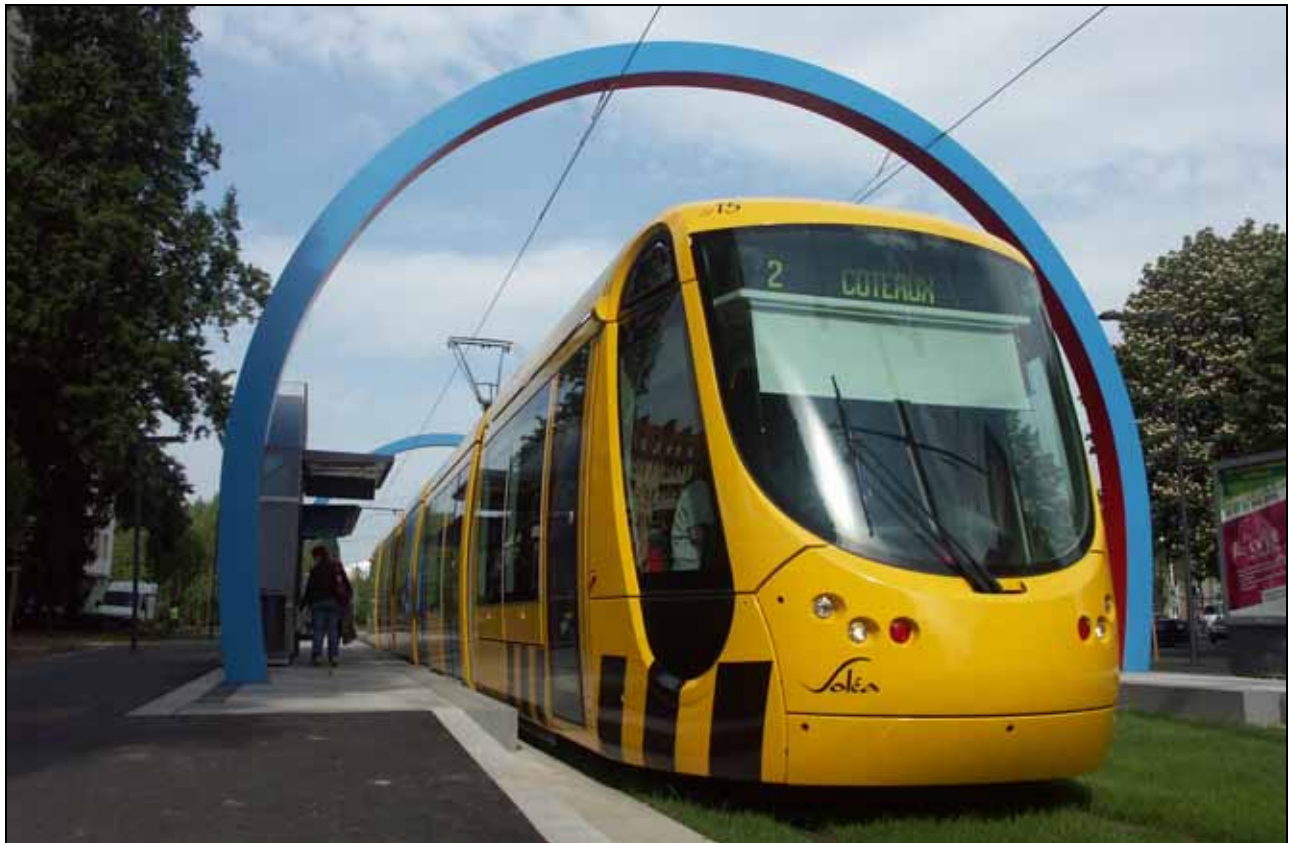
Abb. 170: Schaffung von Individualität, Beispiel Mülhausen – die Haltestellen der dortigen Linie 2 werden von charakteristischen Portalen überspannt, die gleichzeitig als Oberleitungsmast fungieren
