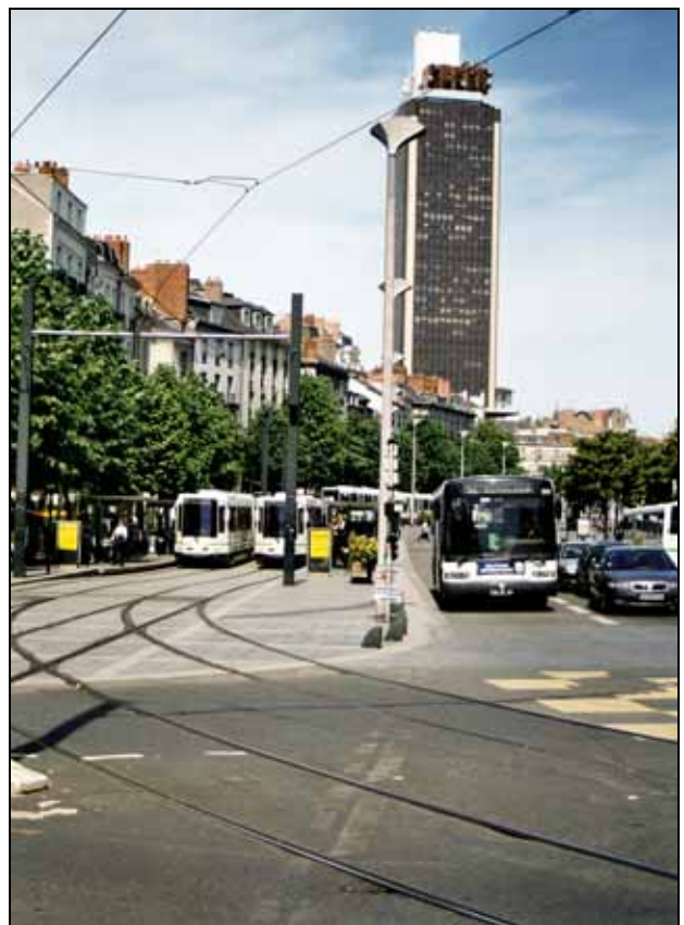
Abb. 154, 155: Die stadtverträgliche Einbindung von Straßenbahnstrecken erfordert die Option, enge Radien verwirklichen zu können, was in der deutschen EAÖ mit der Forderung nach Radien von über 100\text{ m} aber ausgeschlossen wird, Beispiel Nantes
