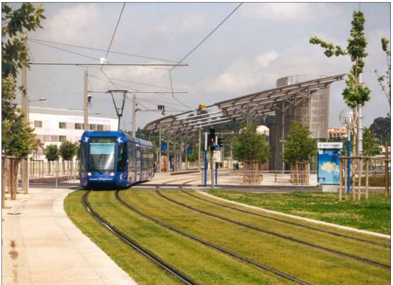
Abb. 126, 127: Umsteigestation Occitanie in Montpellier mit eleganter Dachkonstruktion
