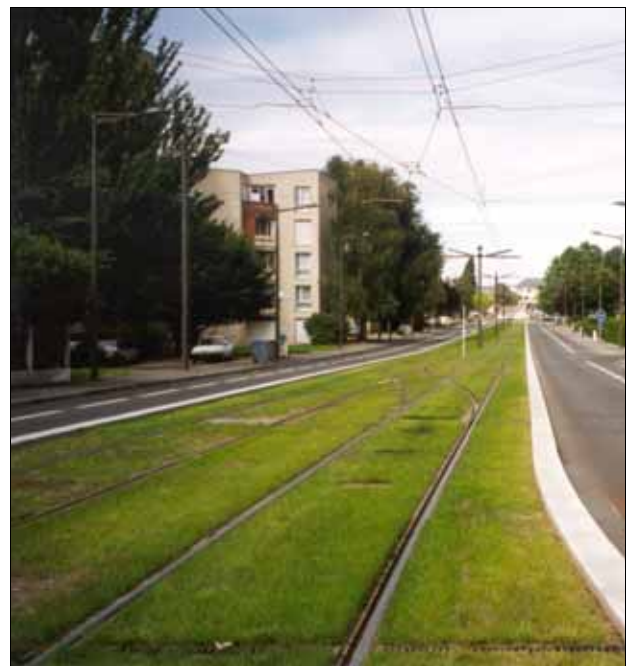
Abb. 72: Orléans – In Rasengleis voll integriertes Weichenkreuz
