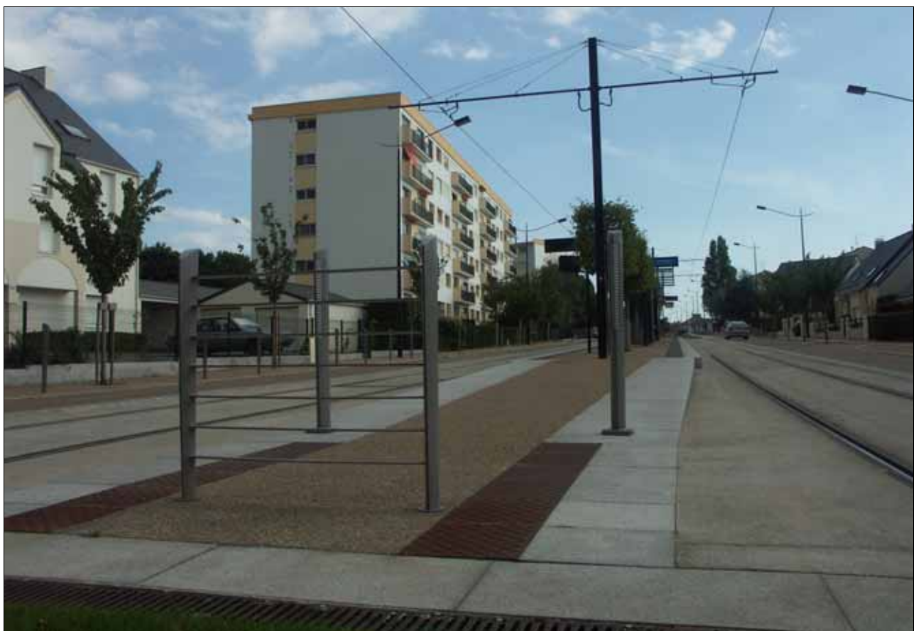
Abb. 159: Nach deutscher Planungspraxis unzulässig – Mittelbahnsteig ohne Schutzraum zwischen Straße und Gleis an den Überwegen, Beispiel Nantes; Gefahrenpotenziale sind bei dieser Lösung nicht erkennbar
