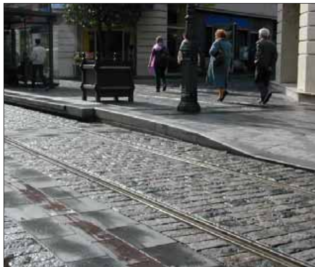
Abb. 102: Orléans, Detailansicht Bahnsteigkante mit Anrampung in der Fußgängerzone
