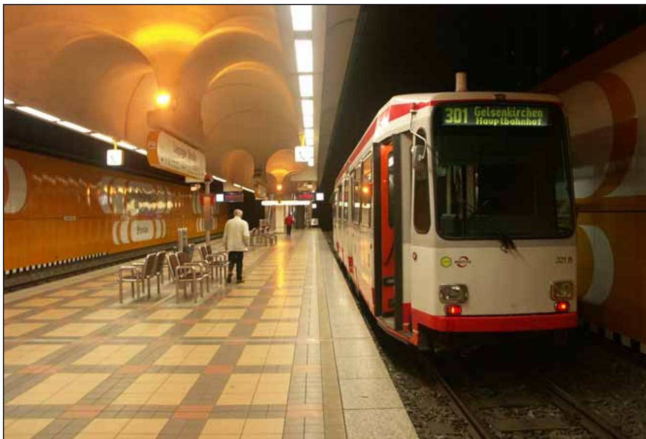
Abb. 145: Viele Stadtbahntunnel im Ruhrgebiet werden bis heute von der Straßenbahn genutzt, dieses eigentliche Provisorium wird langfristig Bestand haben, Beispiel Gelsenkirchen
