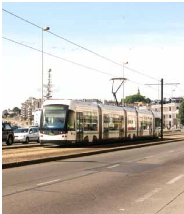
Abb. 117: Nantes – Aufgrund der unproblematischen Trassierung entlang breiter Straßen und Bahnstrecken war die Linie 1 recht kostengünstig. Sie weist aus dem selben Grund im Vergleich zu vielen anderen Systemen eine höhere Reisegeschwindigkeit auf.
