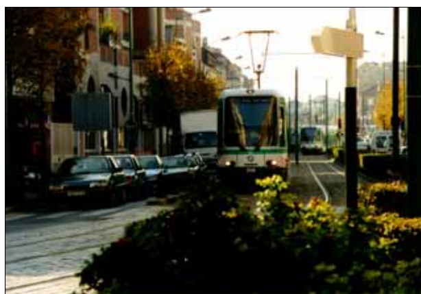
Abb. 185: Trotz stellenweise recht enger Platzverhältnisse wurde die Linie T1 konsequent vom Kraftfahrzeugverkehr separiert
