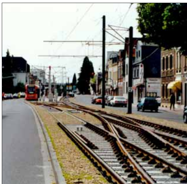
Abb. 78: rein technische Ausgestaltung des Oberbaus, Bruch in der Oberbaugestaltung, unstetige Mastfolge
