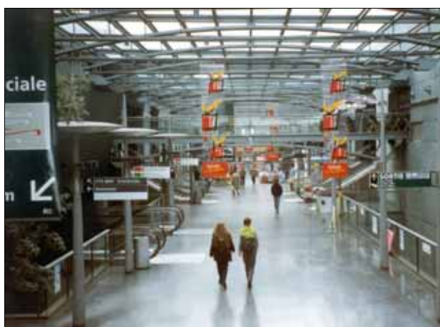
Abb. 96: Strasbourg – Zwischengeschoss der Straßenbahnstation unter dem Bahnhofsvorplatz
