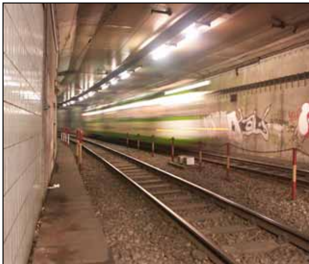
Abb. 142: Straßenbahntunnel in Mannheim
