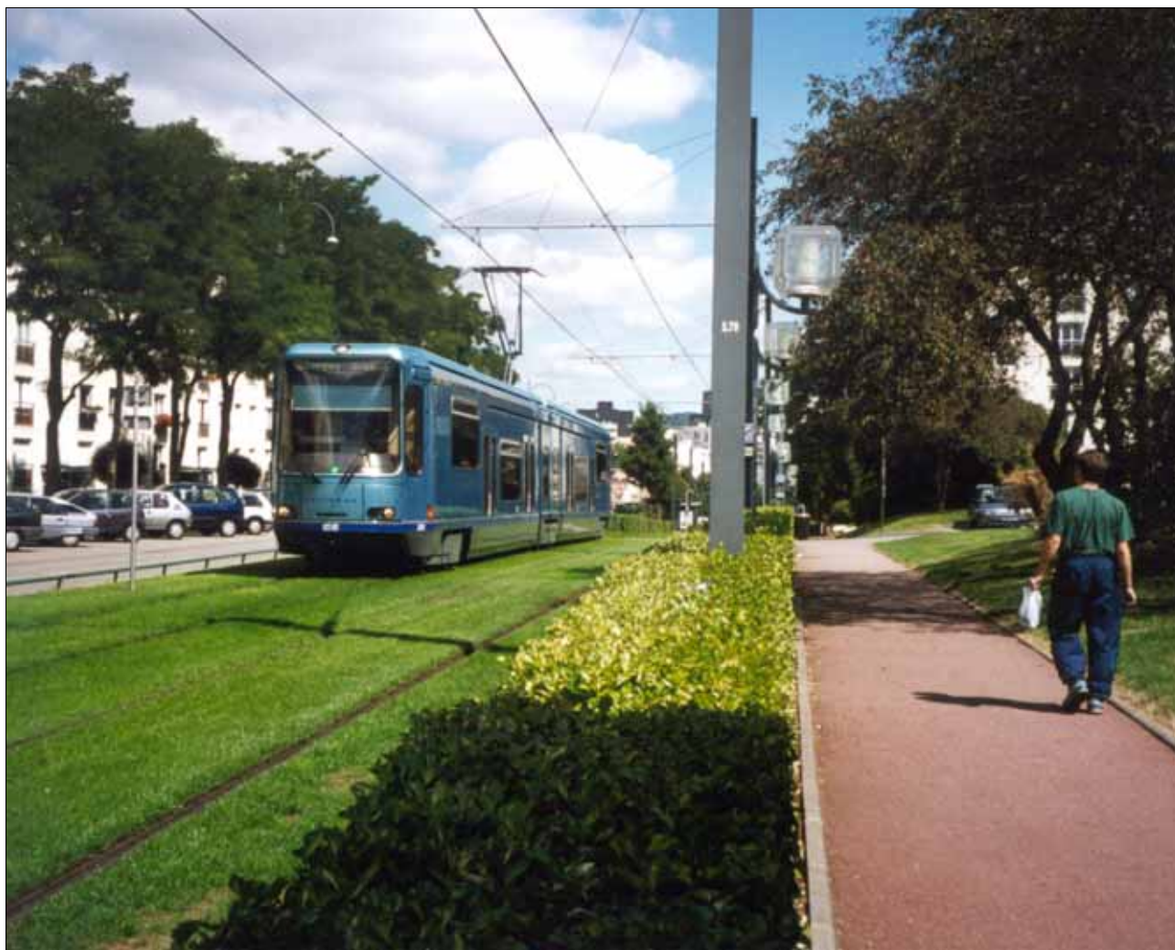
Abb. 190: Straßenbahn Rouen – neugestalteter und verkehrsberuhigter Straßenraum in Le-Petit-Quevilly
