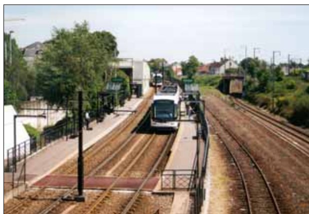
Abb. 174: Die erste neue Linie in Nantes – Stadtbahnstrecke auf Schottergleiskörper
