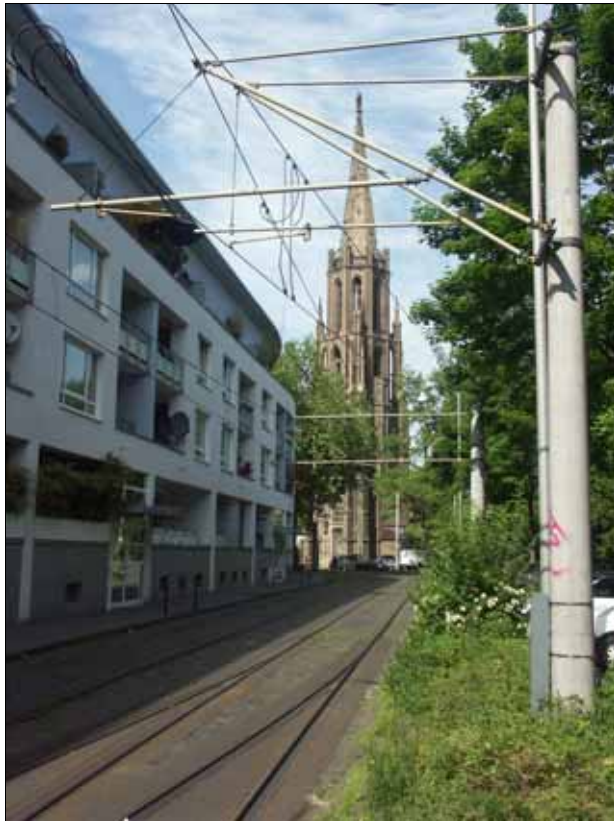
Abb. 157: Betonmasten für die Oberleitung beeinträchtigen sensible Umgebungen enorm, Beispiel Köln
