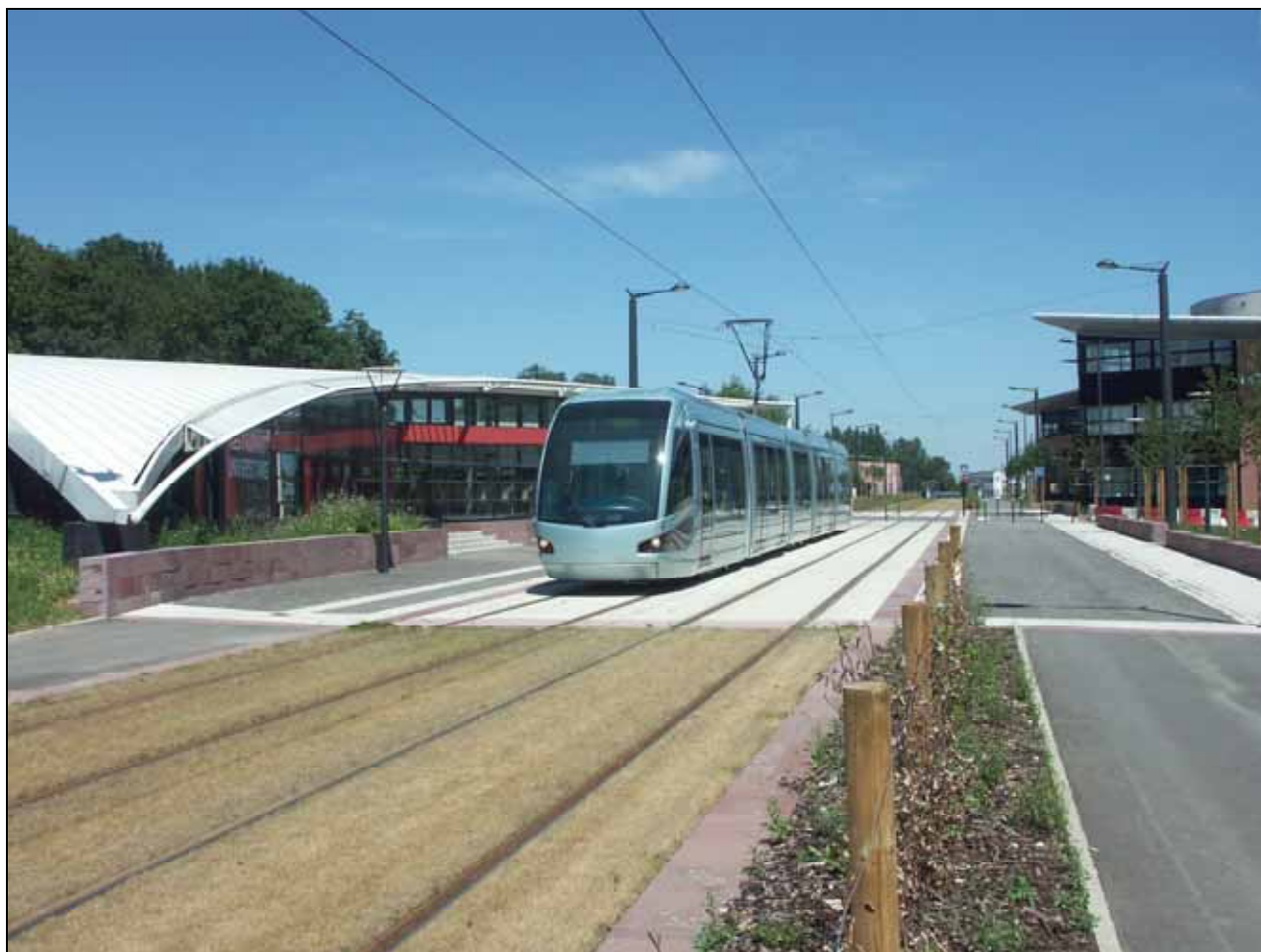
Abb. 172: Straßenbahnstrecke in Valenciennes mitten durch den Campusbereich; wie hier vor der Mensa gibt es an mehreren Stellen breite Querungsplätze für Fußgänger über den sonst durchgehend mit Rasengleis versehenen besonderen Bahnkörpern. Adäquate Fahrgeschwindigkeit der Straßenbahn und Belange der Fußgänger schließen sich nicht gegenseitig aus, hervorgehobene Pflasterung der Gleiszone und gute Einsehbarkeit lassen auch keine Sicherheitsbedenken aufkommen. Ein schneller und leistungsfähiger Straßen- bzw. Stadtbahnbetrieb muss nicht bedeuten, diesen möglichst intensiv von seiner unmittelbaren Umgebung zu isolieren!
