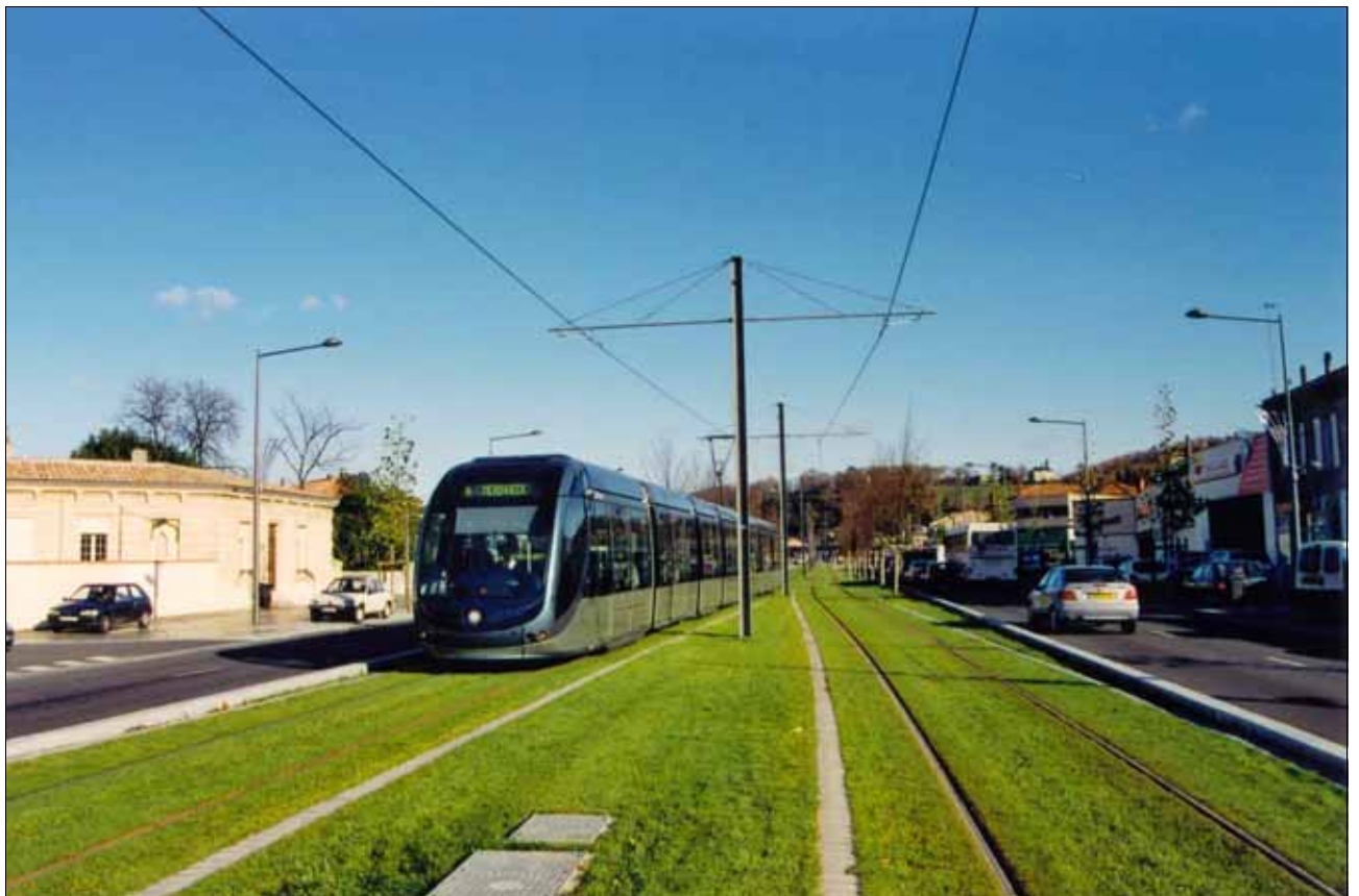
Abb. 115, 116: Streckenabschnitte in Bordeaux ohne und mit Oberleitung im Vergleich
