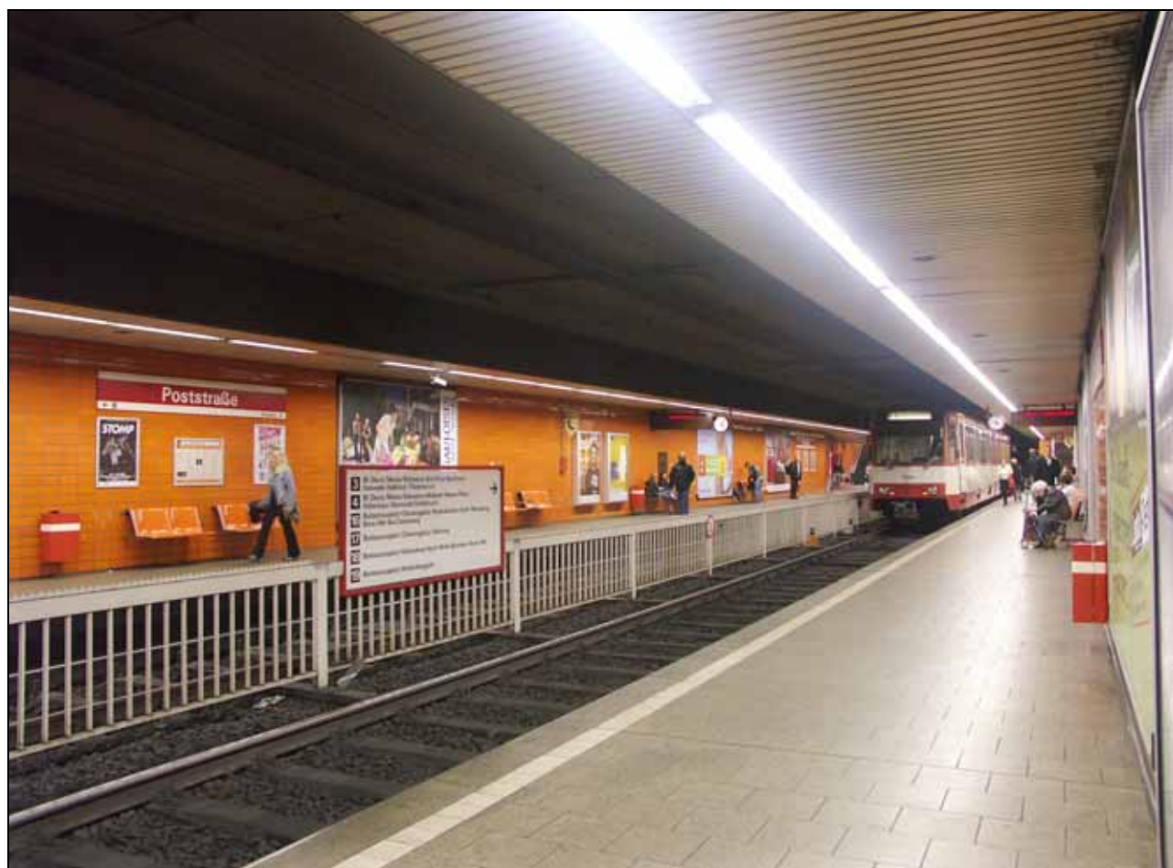
Abb. 141: Die ersten Tunnelanlagen in Köln wurden als Unterpflasterstraßenbahntunnel gebaut und erhielten daher u.a. niedrige Bahnsteige
