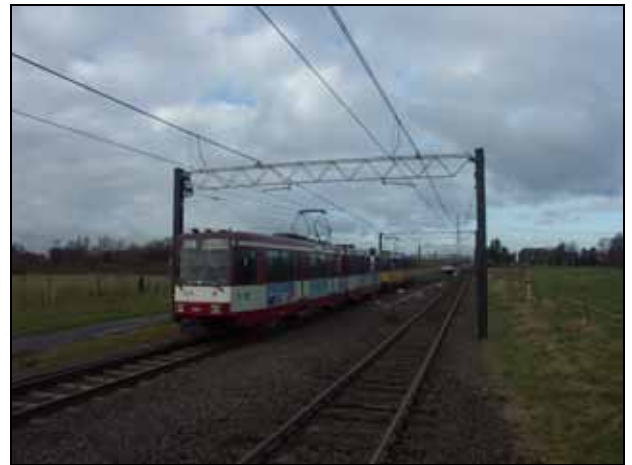
Abb. 140: Düsseldorf, Stadtbahnzug auf der umgebauten ehemaligen Überlandstraßenbahn nach Krefeld
