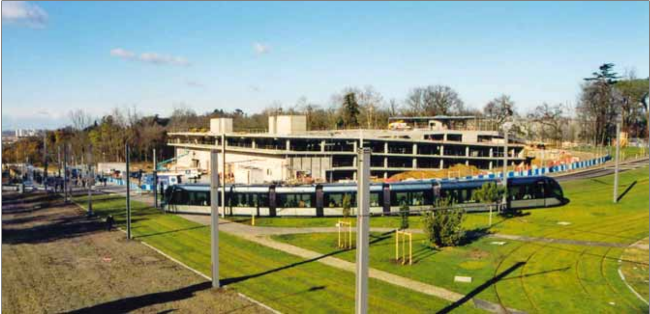
Abb. 90: Bordeaux, im Bau befindliche P&R-Großanlage Buttinière mit direktem Bahnsteigzugang
