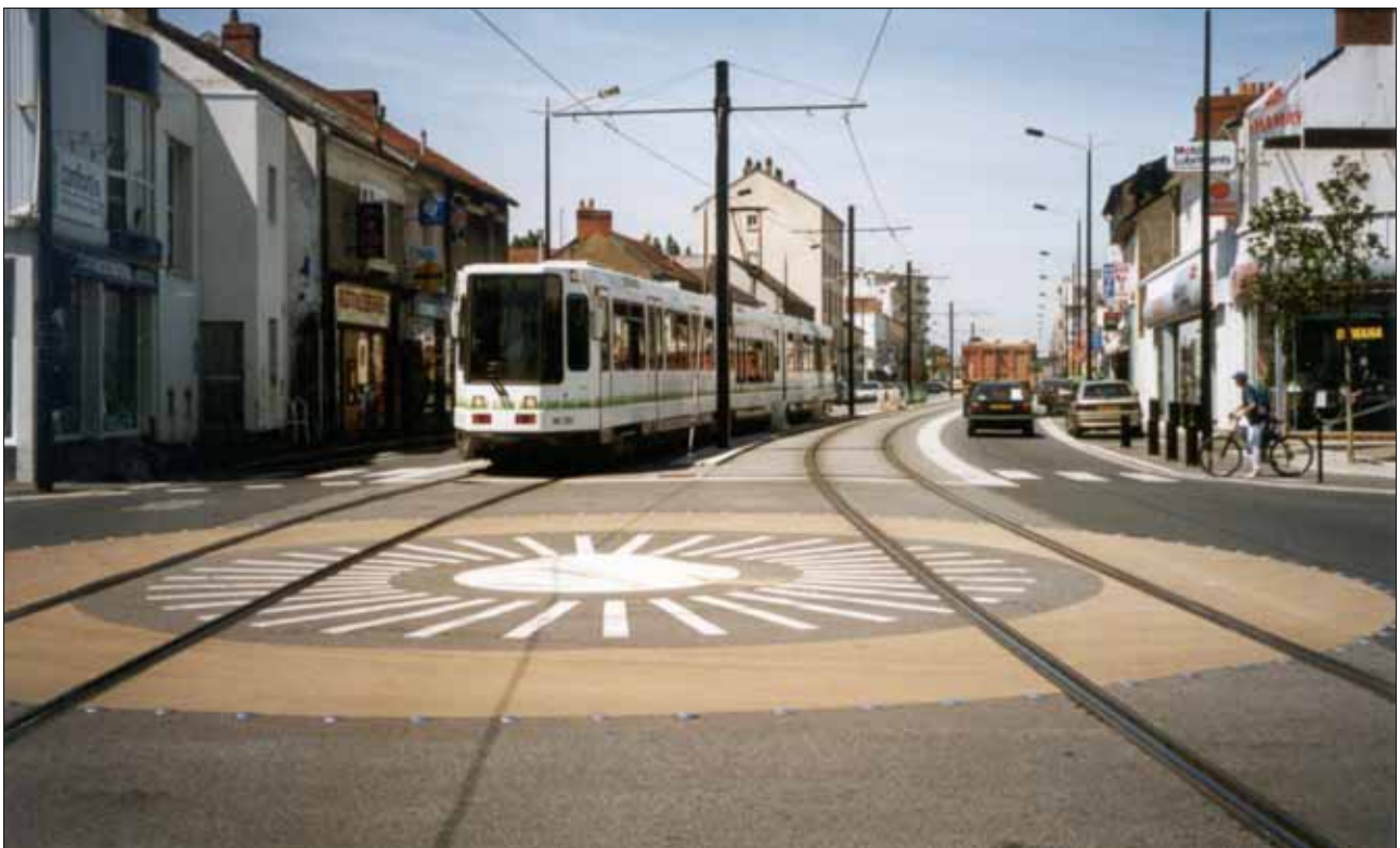
Abb. 68: Straßenbündige Trasse der Linie 3 in Nantes – durch abgestimmte Farben bei der Materialwahl der Straßenraumgestaltung ergibt sich ein sehr hochwertiges Erscheinungsbild
