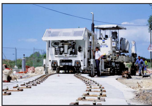
Bild E.6: Gleitschalungstechnik im Straßenbahnbau. Die Rippenplatten werden automatisiert in den frischen Beton eingerüttelt. (ALSTOM)
