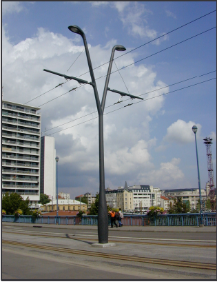
Bild 128b: Gut gestaltete doppel- polige Fahrdrachanlage für gum- mibereifte Fahrzeuge. Die Masten dienen sowohl der Befestigung der Oberleitung als auch dem Anbringen der Straßenbeleuchtung.
