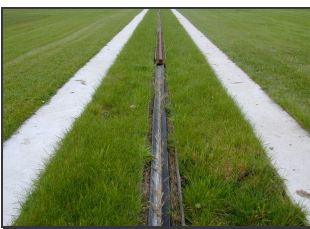
Bild 126b: Feste Fahrbahn mit Abrollstreifen für die Reifen einer gummbereiften Straßenbahn. Mittig liegt die Monoschiene.
