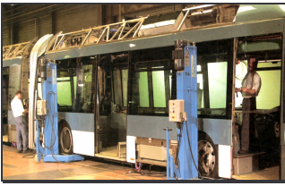
Bild A.28: Rostfreistählerne Bodenplatte, Seitenwände, Front, Dach sowie GfK-Heck werden zusammenschraubt. (IRISBUS)
