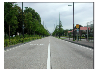
Bild 62: Beukelaan, zu erkennen sind auch hier die typischen Gestaltungselemente der ÖPNV-Trasse, die für einen hohen Wiedererkennungswert sorgen sollen.
