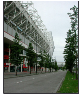
Bild 61: Eigentrasse in Seitenlage am Philipsstadion. Beachte die Straßenraumgestaltung mittels Lichtmasten, Grünstreifen sowie hochwachsenden Bäumen.
