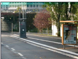
Bild 115: Dauerhaftes Provisorium: Hochwertige Informationsstele mit samt Fahrkartenautomat in einer rückgebauten Busbuch
