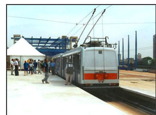
Bild B.13: São Paulo – Geführter Großraum-Trolleybus an einem Hochbahnsteig. Die Führungsrollen werden durch aufgedübelt Stahlprofile unter Vorspannung gehalten. (MARTIRE)
