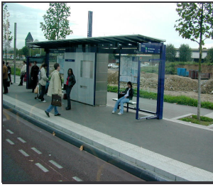
Bild 51: Hochwertige Gestaltung und Ausstattung der TEOR-Haltestellen. Beachte das abgeschrägte Bord mit Rücksprung. Abschluß der Wartefläche bildet ein Kantstein mit Noppen.
