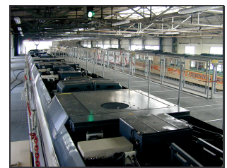
Bild 105b: Stromrichtergeräte und Umformer eines elektrischen Fahrzeugs erfordern Starkstrom-Techniker. Im Vordergrund: Fahrgastraum-Klimagerät.
