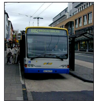
Bild E.3: In Solingen werden im Haltestellenbereich aufgrund drehmomentstarker Obus-Antriebe sowie hoher Achslasten überwiegend Betondecken eingebaut.
