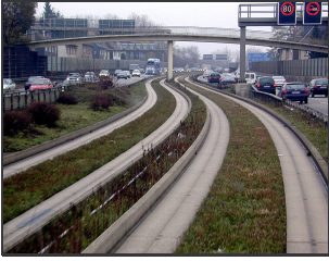
Bild 96: Spurbus Essen – der Schnellfahrweg mit fahrdynamischen Lage- und Höhenplanelementen sorgt für hohen Fahrkomfort.
