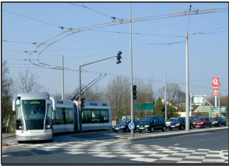
Bild A.22: GLT/TVR in Nancy – unterwegs als handgelenkter Obus unter einem doppelpoligen Fahrdrabt. Interessant ist die Fahrbahnmarkierung für den ÖPNV im Straßenkreuzungsbereich.
