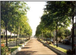
Bild 3: So genannte Vairie protégée auf der Trans Val de Marne (TVM) in Paris – TCSP für Linienbusverkehr
