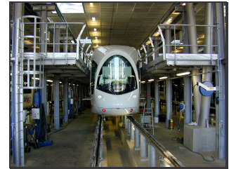
Bild 107: Ein Straßenbahnsystem erfordert immer auch die Errichtung einer neuen Betriebshofanlage einschließlich einer neuen Werkstatt. (Bild oben, ALSTOM)
