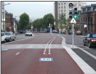
Bild 53: Haltestellenanfahrt mit optischer Spurregelung auf der Linie T2. Die zulässige Einfädelungsgeschwindigkeit beträgt 30 km/h.
