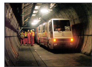
Bild B.27: Servicefahrzeuge spurgeregelt im Eurotunnel (CÉGÉLEC)
