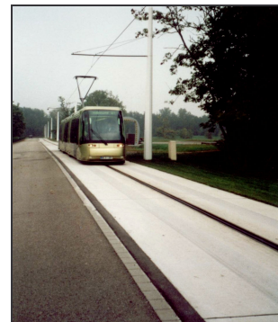
Bild E.7: Kunststofffaserverstärkte Betonstraße mit Scheinfugen, Translohr-Teststrecke in Duppigheim
