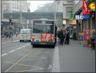
Bild 94: Geradlinige Anfahrt, Leitmarkierung in der Flucht des Fahrers, Formstein als Anfahrhilfe. Eine geringe Spaltbreite lässt sich auch bei handgelenkten Fahrzeugen verwirklichen.
