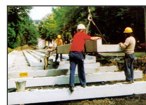
Bild E.8: Einbau der Fahrwegbauteile beim Spurbus Essen (ESSENER VERKEHRS-AG)
