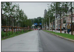
Bild 38: Der Vleutensweg mit mittigem Grünstreifen ist Bestandteil der zukünftigen Strecke nach Leidsche Rijn. Zur Anwendung kommt ein baulich erhöhter besonderer Fahrweg in Mittellage.
