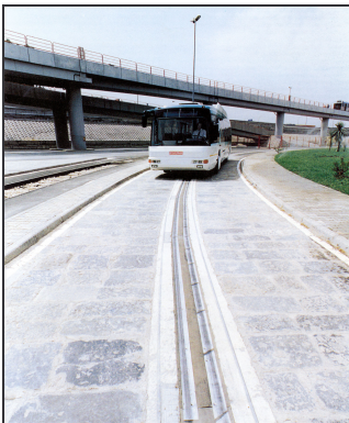
Bild C.5: Bei dem Stream-System ist die unterteilte Kontaktschiene (rechts im Bild) unter dem Fahrzeug spannungsführend, die durchgehende Kontaktschiene (links) dient der Rückleitung (ANSALDOBREDA)
