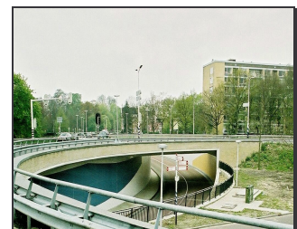
Bild 41: In Tieflage unter der Berenkuil. Die Uithof-Trasse kreuzt hier planfrei eine Autostraße. (HONDIUS)
