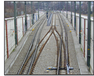
Bild 116: Kehrgleisanlage auf freier Strecke
