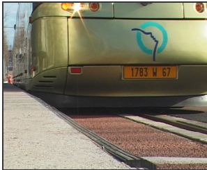
Bild E.4: Standfester, polymermodifizierter Asphaltbelag im Haltestellenbereich. Man beachte die körnige Oberfläche der Asphaltdecke, hervorgerufen durch den hohen Splittgehalt. (LOHR INDUSTRIE)
