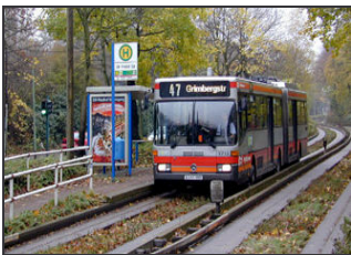
Bild B.14: Fahrweg mit Leitkanten aus Beton-Fertigteilelementen, die sich in Essen als nahezu wartungsfrei erwiesen haben.
