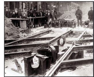
Bild C.1: Bau von Kanälen für eine unterirdische Stromzuführung für Straßenbahnen durch Siemens & Halske im Jahre 1895 in Dresden (DVB AG)
