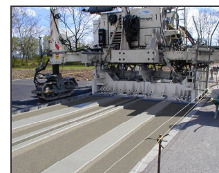
Bild E.18: Gleitschalungstechnik zur Herstellung einer kunststoffaserverstärkten Beton-Fahrbahn (LOHR INDUSTRIE)
