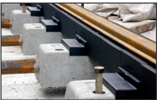
Bild 89: Schwingungsmindernde Oberbauformen erhöhen zwar die Herstellungskosten, sie erhöhen aber auch die Akzeptanz seitens der Anlieger. Betontragplatte, Zweiblockschiene sowie Kammerfüllsteine aus Gummigranulat.
