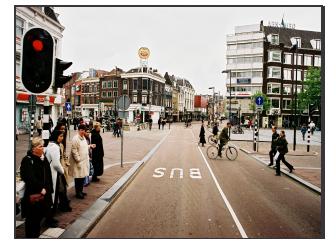
Bild 33: Die Uithof-Trasse im Zentrum von Utrecht. Beachtenswert: Es kommen hohe Borde und Fußgänger-Lichtsignalanlagen zum Einsatz. (HONDIUS)
