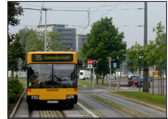
Bild E.17: Begrünter Fahrweg bei handgelenkten Bussen. Betonplatten mit eingelassenen Pflanztrögen, die sich außerhalb der Abrollfläche der Gummireifen befinden.
