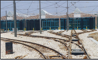
Bild 135: Betriebshof und Werkstätten stellen eine bedeutende Kostengruppe bei der Neueinführung eines Straßenbahnsystems dar. (VDV)
