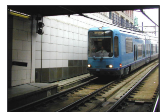
Bild 44: Stadtbahn Richtung Bouligrin bei der Einfahrt in den Tunnelabschnitt im Innenstadtbereich Rouen (Haltestelle Théâtre des Arts)
