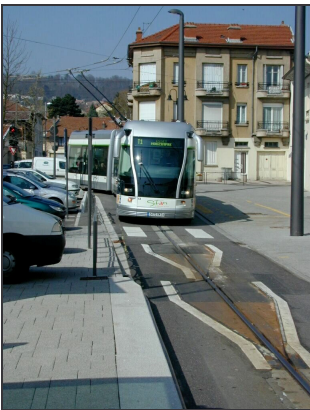
Bild B.21: Ungenügende Planung in Nancy bei dieser Einfädelungsstelle unmittelbar hinter einer Kurve, direkt vor einer Haltestellenanfahrt. Nachträglich musste eine zweite Einfädelungsvorrichtungen eingebaut werden.
