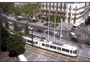
Bild 133: Ein qualitativvoller Straßenraumentwurf beinhaltet die Neugestaltung von Fassade zu Fassade, was aber zweifellos mit sehr hohen Kosten verbunden ist – Beispiel Nantes. (TAN)
