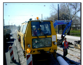
Bild 106: Fremdfirma verlegt einen neuen Gleisrost, Schotteroberbau
