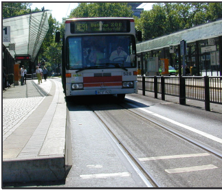
Bild B.7: Haltestelle in der Geraden, spaltfreie Halteposition durch Formstein. ÖPNV-Trasse in Oberhausen.
