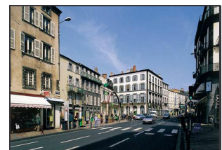
Bild 70: Nördlich und südlich des Place de Jaude werden solche vielbefahrenen Hauptverkehrsachsen zu Fußgängerzonen mit Straßenbahnandienung rückgebaut.
