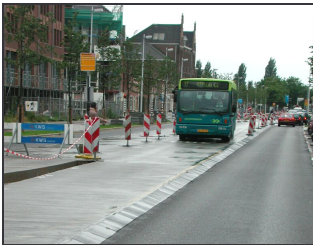
Bild 114: Streckenabschnitt des Utrechter HOV-Systems wird unmittelbar nach seiner Fertigstellung vorübergehend vom Linienverkehr befahren.
