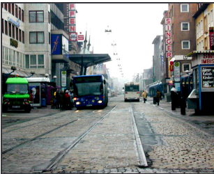
Bild 97b: Ungenügender Fahrkomfort und hoher Materialverschleiß. Aufgelassene Straßenbahnstrecke mit Kopfsteinpflaster und zahlreichen Schadstellen.
