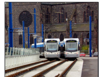
Bild 123: Große Radien und Spurführung erfordern nur geringere Verbreiterung der Verkehrsräume. Begegnungsfall zweier Schienenbahnen.
