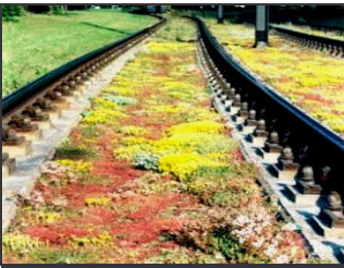
Bild 126a: Feste Fahrbahn mit Längsbetonbalken und tiefstehender, extensiver Begrünung. Diese Form der Begrünung ist äußerst pflegearm. (N.N.)
