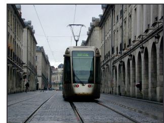
Bild 80: Unauffällige Einfachdraht-Oberleitung im historischen Bereich der Rue Royale. Die Gehwege befinden sich im Arkadenbereich.
