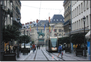
Bild 118b: Gleicher Blick nach der Einführung der Straßenbahn, es ist nun ein Gegenrichtungsverkehr möglich. Man beachte die schmale Abmessung des Straßenbahnfahrzeuges. Die Standorte der Leuchten in den Seitenräumen sind unverändert geblieben.
