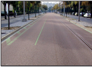
Bild B.36: Die markierte Sperrfläche am linken Rand der TVM-Eigenstrasse stellt die Flächensparnis bei einem Gegenrichtungsbetrieb mit einem spurgeführten GLT/TVR im Vergleich zum handgelenkten Betrieb dar.
