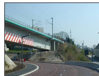
Bild 50: Linie T1 auf einer unabhängigen Eigentrasse vor dem Anstieg zum Campus. Im Hintergrund das neu erstellte SNCF-Brückenbauwerk. (TCAR)
