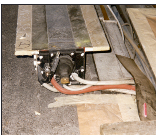
Bild C.6: Ein Kontaktschienen-Modul liegt zum Einbau bereit.
