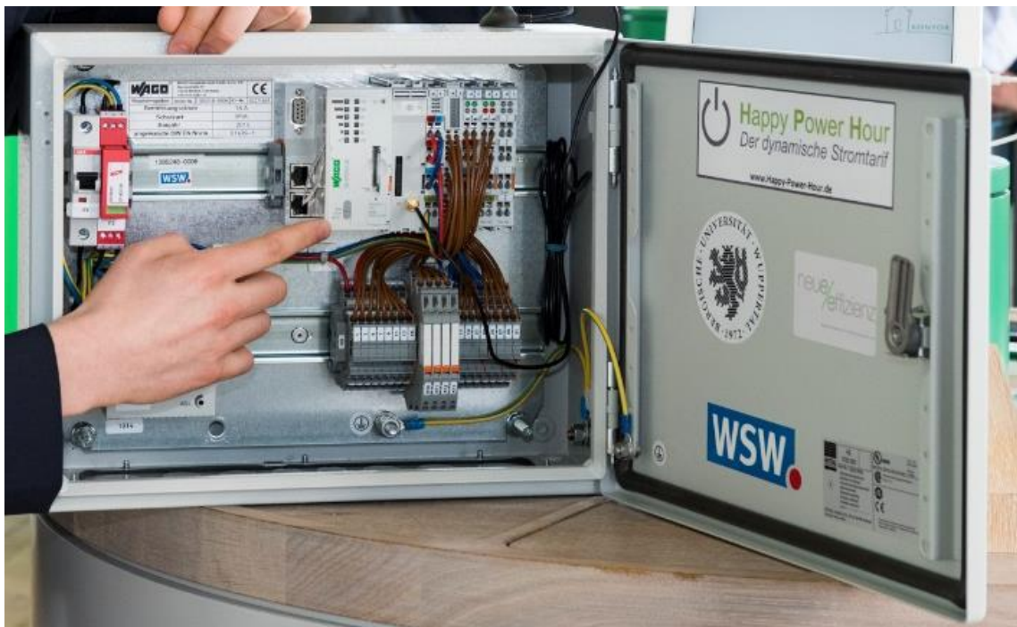
Abbildung 5.3: HPH-Box zur Steuerung der flexiblen Industrieprozesse (Foto: Stefan Tesche-Hasenbach (WSW))
