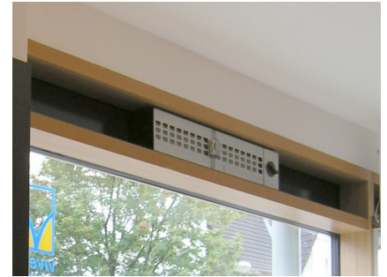
Abb. 155: Raumseitiger Zuluftauslass im Verkaufsraum der Apotheke.
