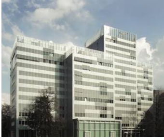
Abb. 181: Haupthaus der KfW-Bank in Frankfurt. Der Dachbereich, auf dem die Wetterstation aufgestellt ist, wird von einer Glasbalustrade gesäumt. (Foto: Uni Karlsruhe)
