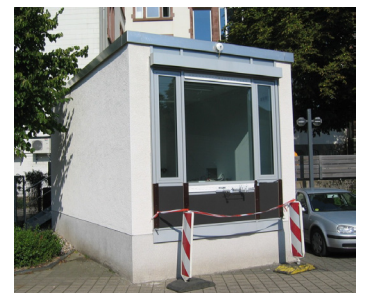
Abb. 230: BTGA-Box mit einer Brüstungsverkleidung aus schwarzen Faserzementplatten.
