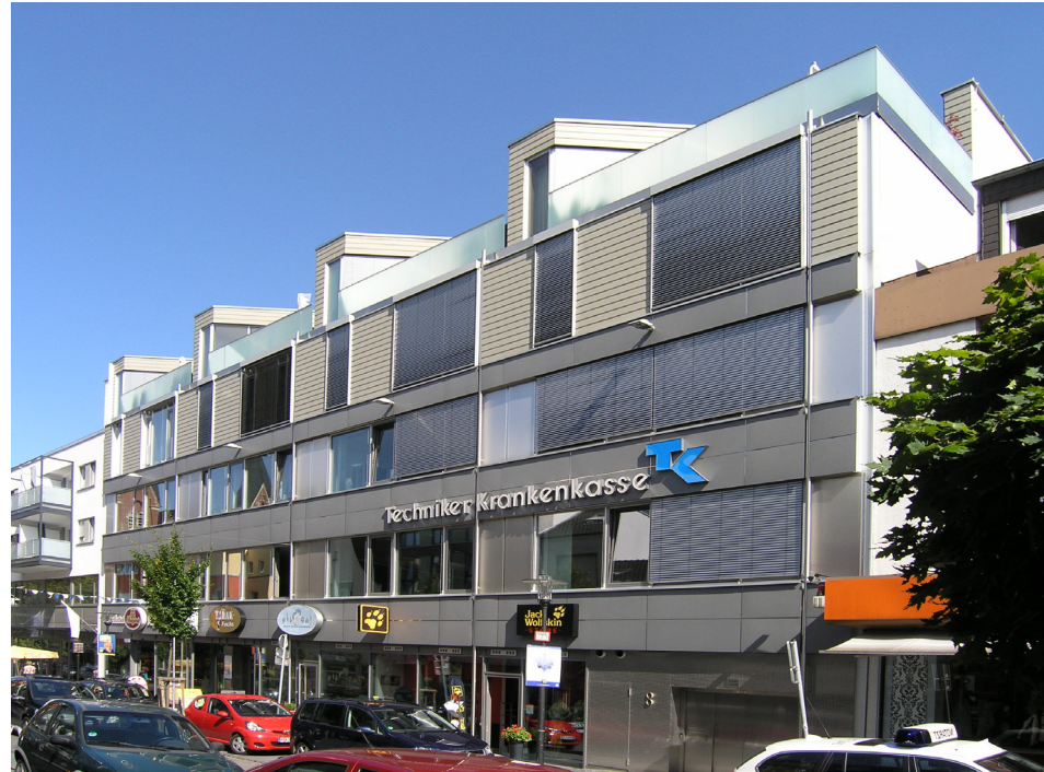
Abb. 42: Süd-West-Fassade des Wohn- und Geschäftshauses APO23. (Architektur: Banz + Riecks Architekten, 2007)
