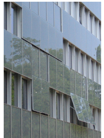
Abb. 66: Fassade mit teilweise herunter gefahrenen bzw. abgeklappten Sonnenschutz-Paneeelen.
