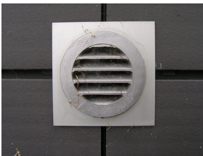
Abb. 118: Fassadenseitige Ansaugöffnung.
