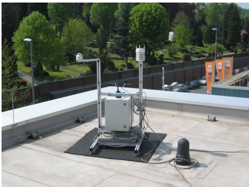
Abb. 95: Wetterstation auf dem Dach des REB-Gebäudes.
