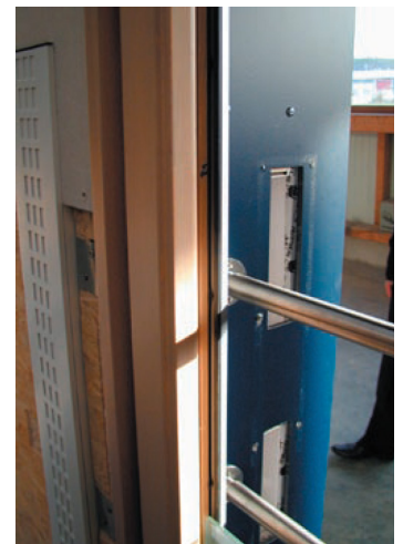
Abb. 167: Luftansaugung und Zuluftelement im Rohbau. (Quelle: enob.info)
