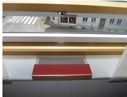
Abb. 154: Raumseitige Zuluftöffnung in einem der untersuchten Praxisräume.
