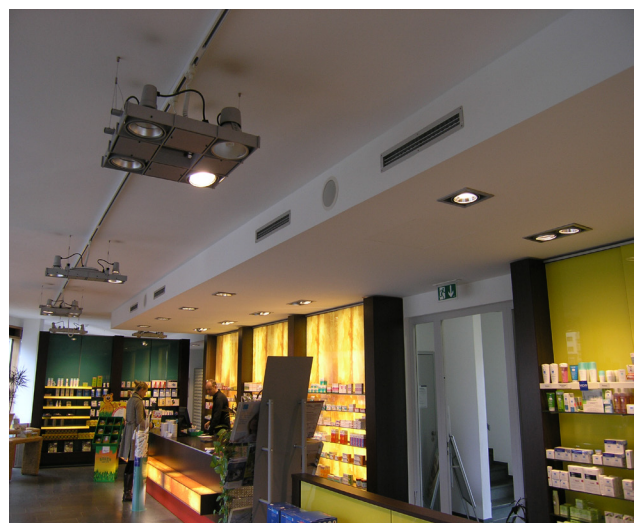
Abb. 54: Der Verkaufsraum der Apotheke im EG. Der Steinfußboden und die in weiten Teilen freiliegende Decke verleihen dem Raum thermische Schwere.
