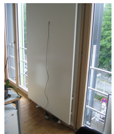
Abb. 168: Luftansaugung und durch Heizfläche verdecktes Lüftungselement im eingebauten Zustand.
