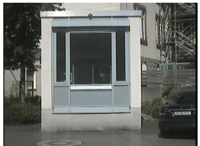
Abb. 327: Thermographie-Bild und Foto der Süd-Fassade der BTGA-Box: Bei einer Gesamtstrahlungsintensität von 710 W/m 2 auf der Fassade, Umgebungstemperaturen von 32 °C und einer mittleren Windgeschwindigkeiten um 1,5 m/s erwärmen sich die Vakuum-Dämm-Paneele im Brüstungsbereich auf 68 °C. Auf Grund der höheren Wärmeleitfähigkeit und der Kühlung durch den Zuluftstrom ist das Lamellenblech am unteren Lüftungselement ca. 20 K kühler. Das verschattete obere Ansauggitter wird durch die Diffusstrahlung lediglich um 5,5 K erwärmt. An der Fensterscheibe führen die vergleichsweise geringe Absorption von Solarstrahlung (ein großer Teil der Direktstrahlung wird auf Grund des Einfallswinkel von 42° reflektiert und wegen des g-Wertes von 42 % führen lediglich 58 % der absorbierten Solarenergie zu einer Erwärmung der Scheibe) und der größere U-Wert zu einer 20 K niedrigeren Oberflächentemperatur als an den Vakuum-Dämm-Paneeelen.
