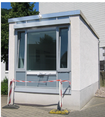
Abb. 333: Fassade der BTGA-Box
