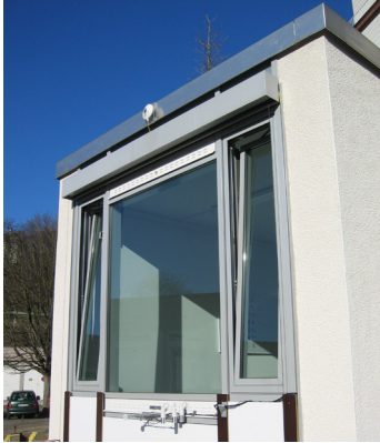
Abb. 221: Durch automatisiertes Kippen der seitlichen Fenster wird ein stilisiertes Nutzerverhalten abgebildet.
