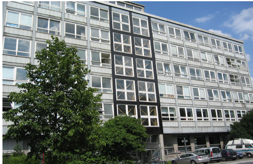
Abb. 35: Ehemaliges Gebäude des Fachbereichs Architektur an der Universität Wuppertal (Süd-West-Fassade) (Architektur: nicht bekannt)
