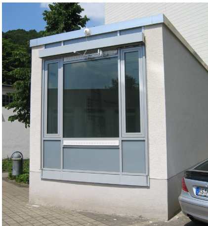
Abb. 224: Fassadenkonfiguration während der Messung am oberen Lüftungselement.
