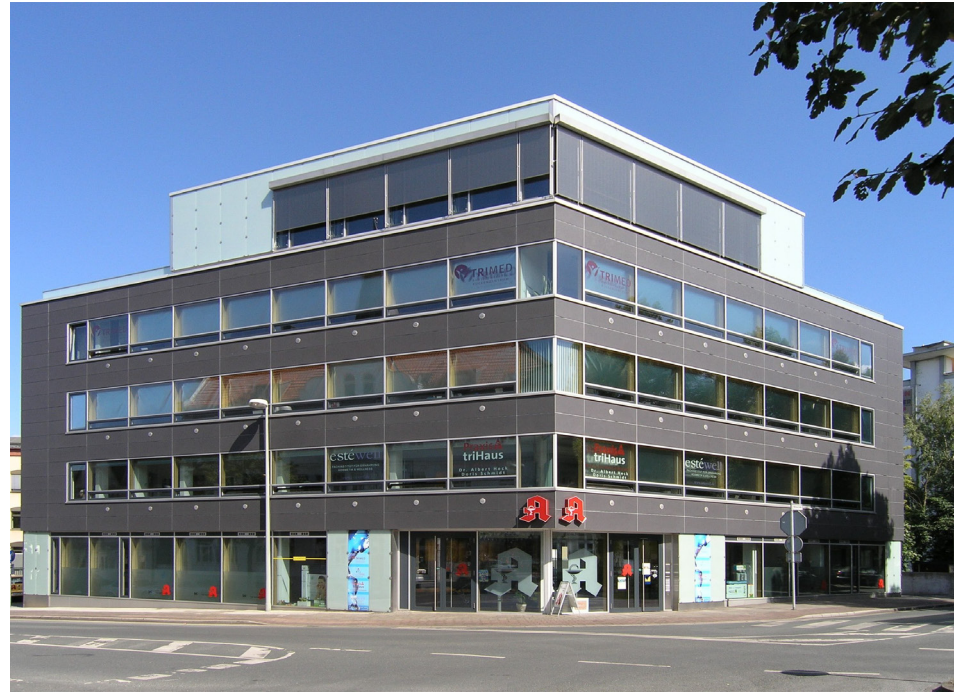
Abb. 49: Süd-Ost- und Süd-West-Fassade des TRI-Hauses. (Architektur: Banz + Riecks Architekten, 2004)
