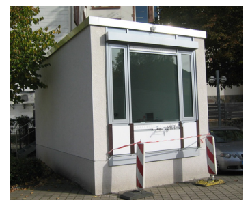
Abb. 231: BTGA-Box mit weißen Faserzementplatten im Brüstungsbereich.
