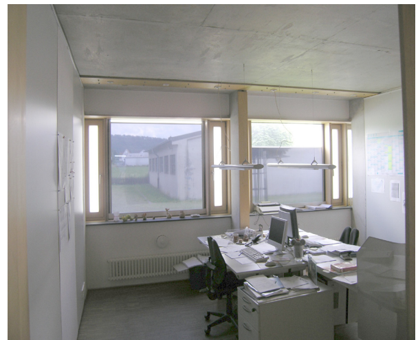
Abb. 33: Büro auf der Süd-Ost-Seite des Gebäudes: Gut erkennbar sind der Sonnen- bzw. Blendschutz sowie die Sichtbetondecke.
