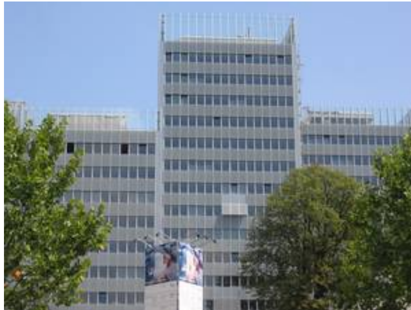
Abb. 63: Haupthaus der KfW-Bank bestehend aus vier an einander grenzenden Hochhäusern. (Architektur: RKW Architekten, 2006) (Bild: Uni Karlsruhe)
