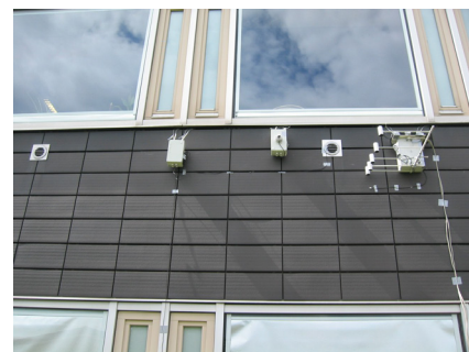
Abb. 85: Messtechnik im Brüstungsbereich des untersuchten Raumes auf der Süd-Ost-Seite.
