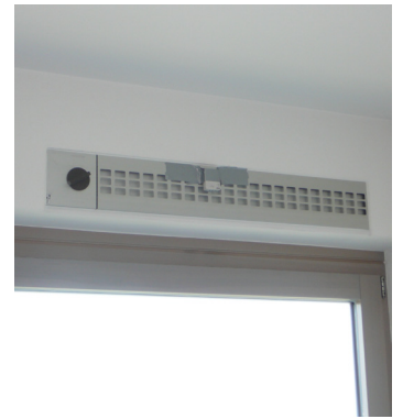
Abb. 72: Schalldämmendes Zuluftelement vom Typ Aeromat 150 in einem straßenseitigen Büroraum.
