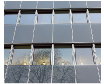
Abb. 65: Fassade der KfW-Bank mit hochgefahrenem Sonnenschutz. (Foto: www.enob.info)
