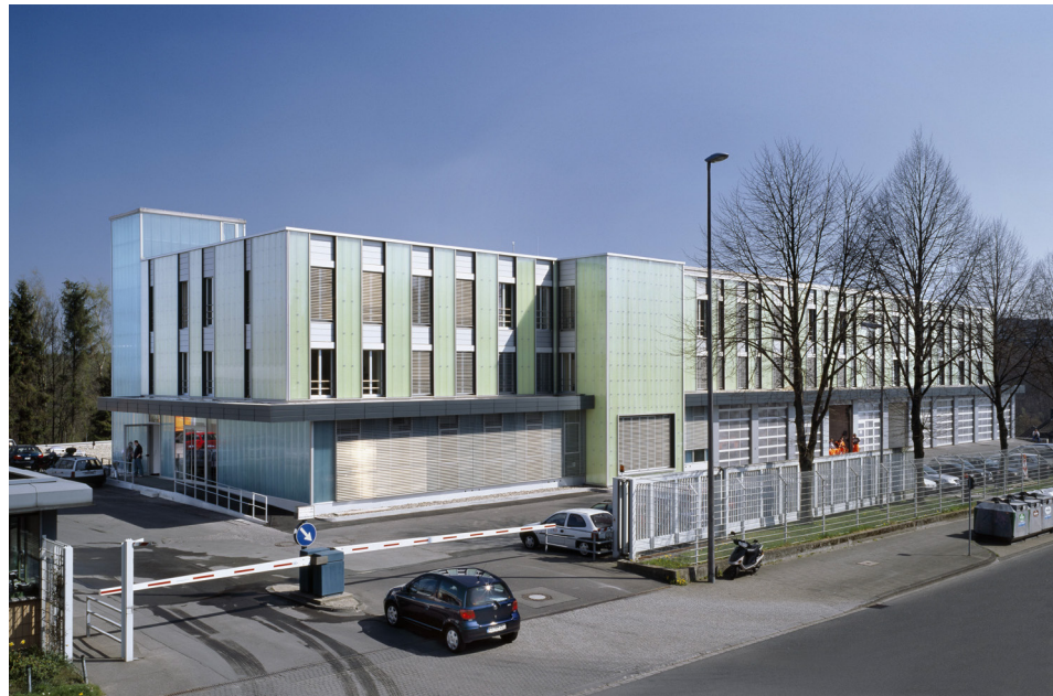
Abb. 56: Verwaltungsgebäude der Remscheider Entsorgungsbetriebe nach der Sanierung im Jahr 2006. (Architektur: Architektur Contor Müller Schlüter, 2006) (Foto: Tomas Riehle, Köln)
