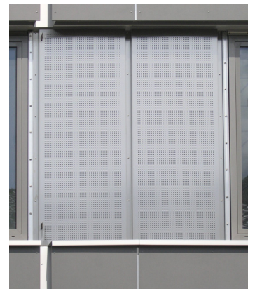
Abb. 45: Fassadenseitige Lochblechverblendung der Lüftungselemente. Die Frischluft wird aus einem ca. 10 cm tiefen Hohlraum hinter den Lochblechen angesaugt.
