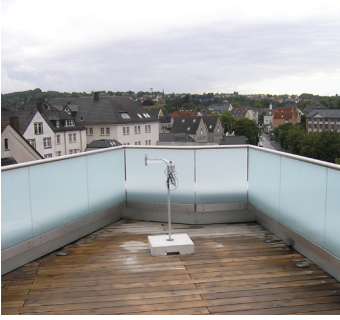
Abb. 152: Klein-Wetterstation zur Messung von Globalstrahlung und Lufttemperaturen auf der westlichen Dachterrasse.
