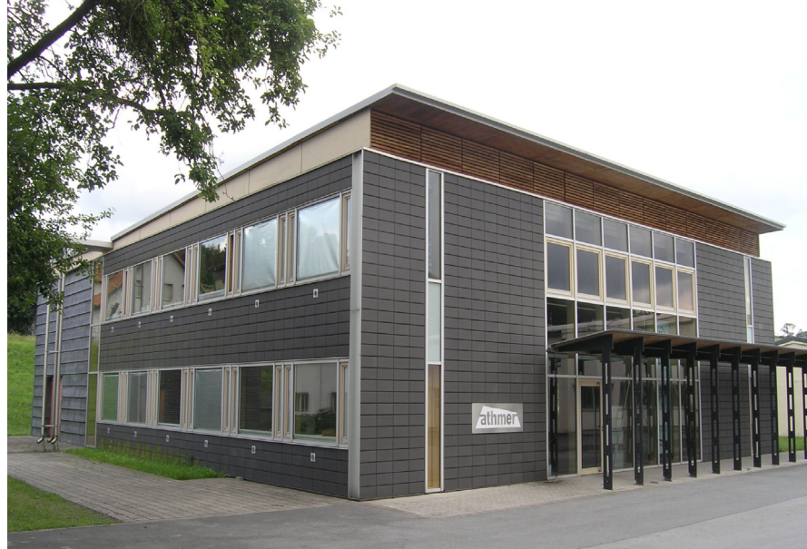
Abb. 28: Das 1998 fertiggestellte Verwaltungsgebäude der Firma Athmer. (Architektur: Banz + Riecks Architekten, 1998)
