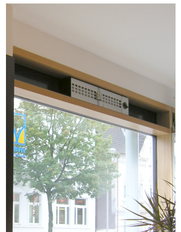
Abb. 52: Einbau-Situation der Zuluftelemente im Verkaufsraum der Apotheke.
