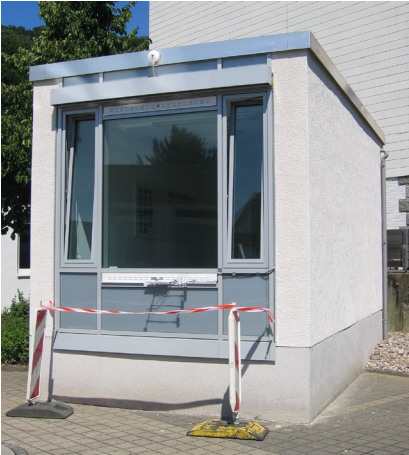
Abb. 226: Fassadenkonfiguration bei der Messung am unteren Lüftungselement.
