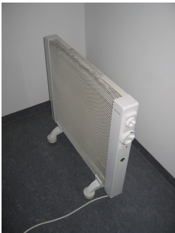
Abb. 223: Ein elektrischer Heizkörper verhindert bei kalter Witterung ein zu starkes Auskühlen der thermischen Speicher.
