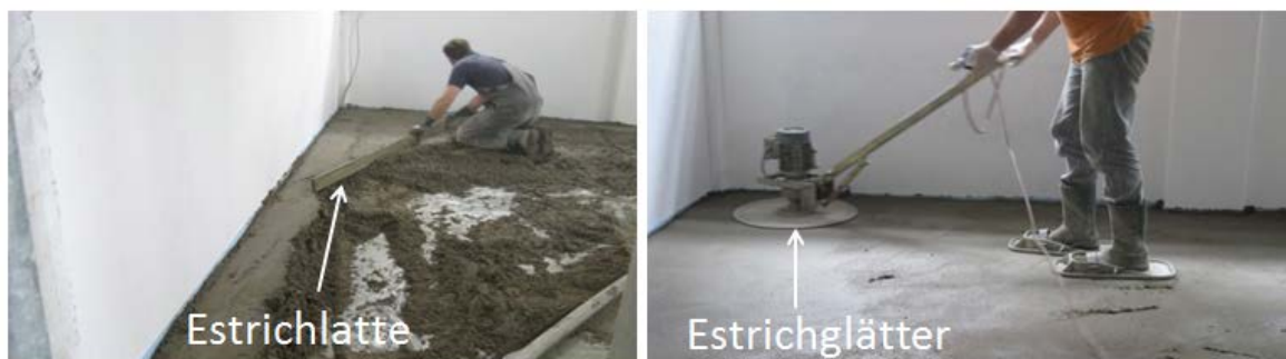
Abb. 26: Einbau des Estrichs 82
