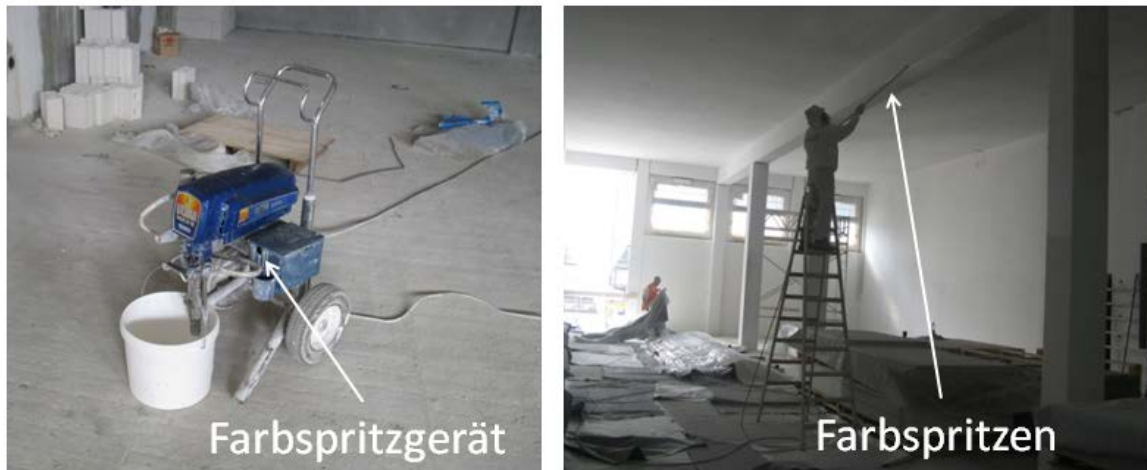
Abb. 16: Farbspritzgerät und Farbspritzen 51
