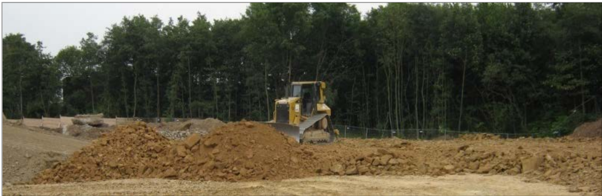
Abb. 9: Planieren einer Baustraße 16
