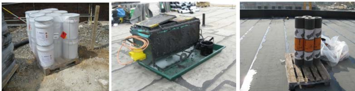
Abb. 9: Bitumen-Voranstrich, Heißbitumenkocher und Bitumen-Dampfsperren 29
