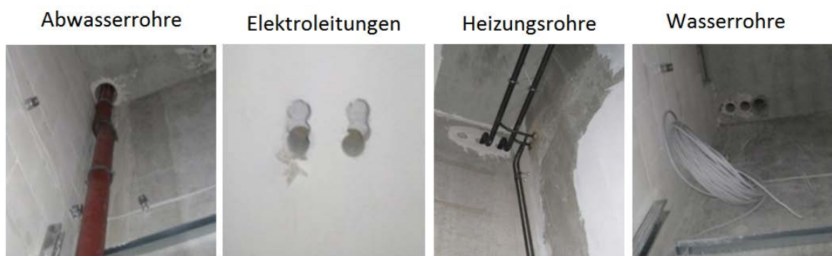
Abb. 44: Durchgeführte Kernbohrungen 141
