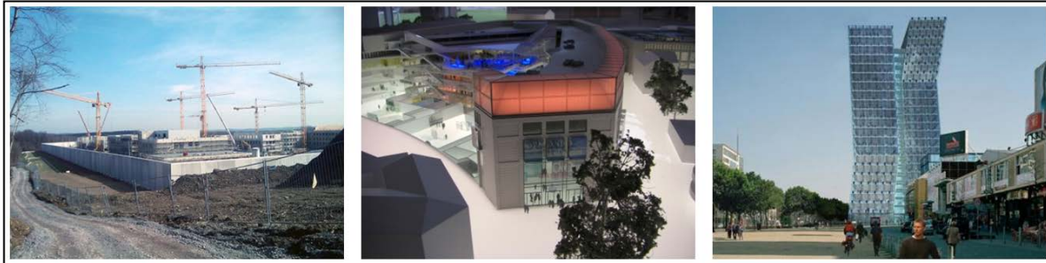
Abb. 4.1: Ansichten der untersuchten Hochbaumaßnahmen 94
