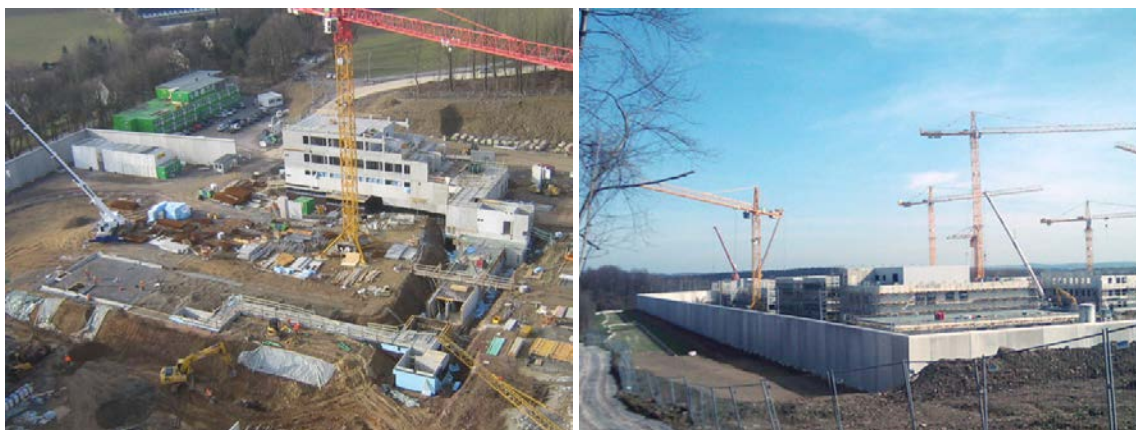
Abb. 4.30: Ansichten der Baustelle „Neubau JVA Wuppertal“ 164
