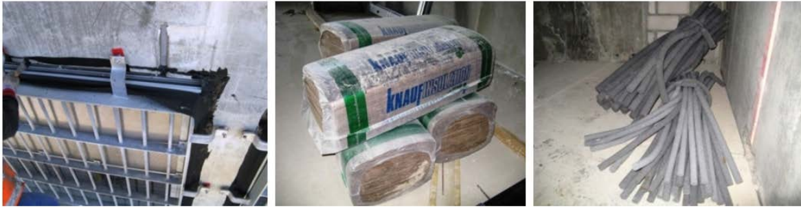
Abb. 4: Bitumen-Voranstrich, Wärmedämmung und Hinterfüllbänder 11
