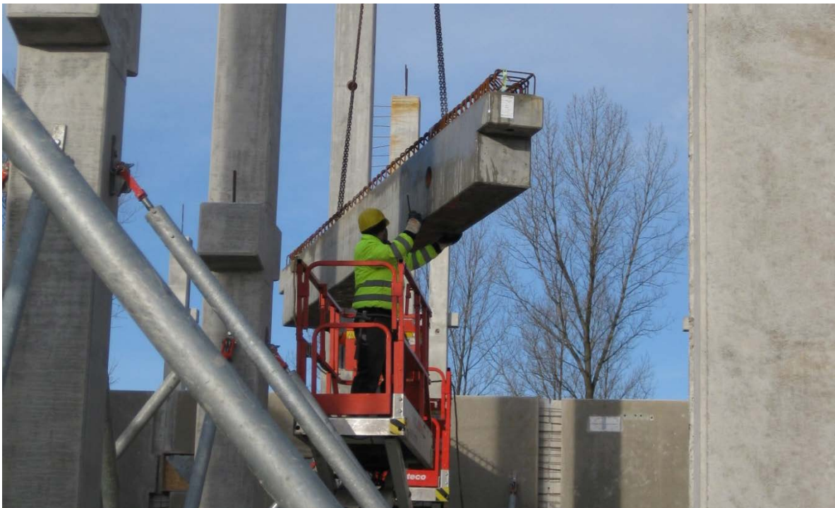
Abb. 21: Einbau eines Fertigteil-Unterzuges 40
