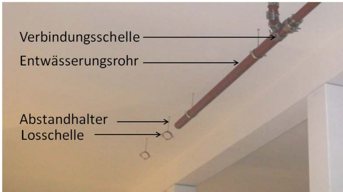
Abb. 28: Montage der Entwässerungsleitung an der Decke 88
