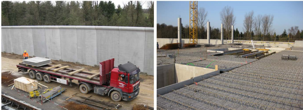
Abb. 25: Einbau der Filigrandecke 51
