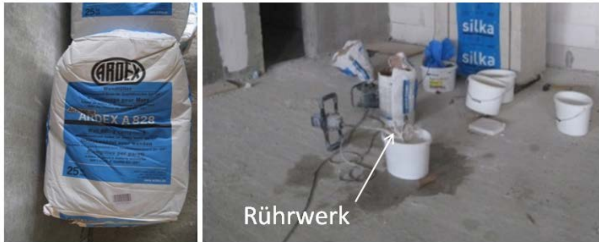
Abb. 14: Herstellung der Spachtelmasse 47
