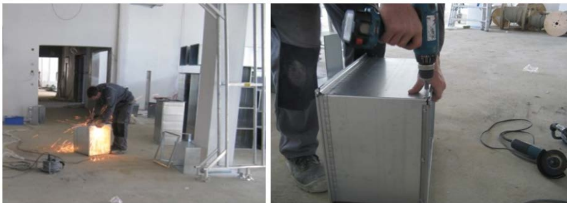
Abb. 34: Zuschneiden und Verschrauben der Lüftungsleitungssegmente 108
