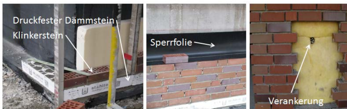
Abb. 8: Lage der druckfesten Dämmsteine, Sperrfolie und Verankerung 25
