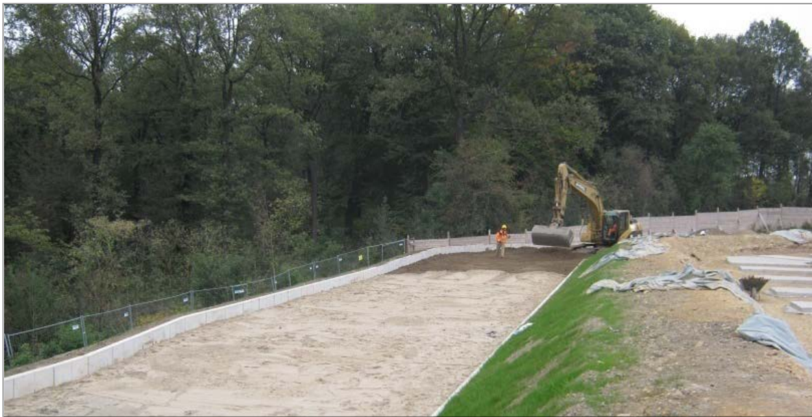
Abb. 17: Erstellen eines Versickerungsbeckens hinter der nordwestlichen Haftmauer 30
