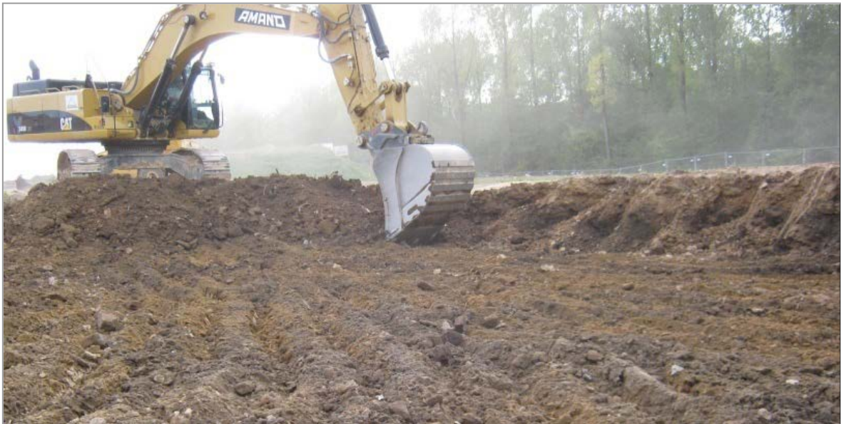
Abb. 1: Bagger beim Ausheben von Lehm Boden 1
