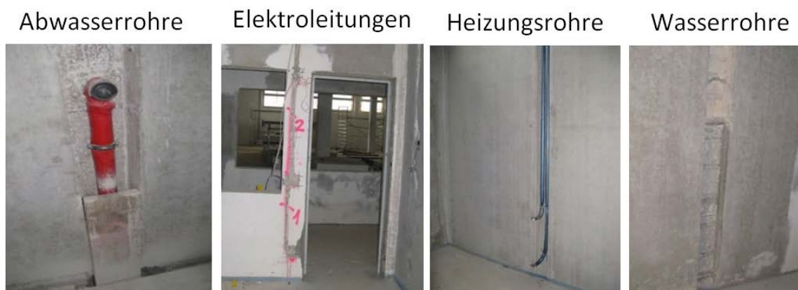
Abb. 46: Erstellte Schlitze 143
