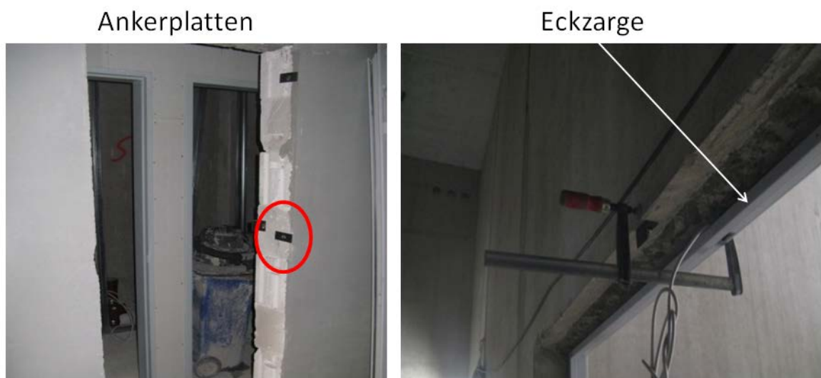
Abb. 37: In die Türöffnung montierte Ankerplatten und Eckzarge 120
