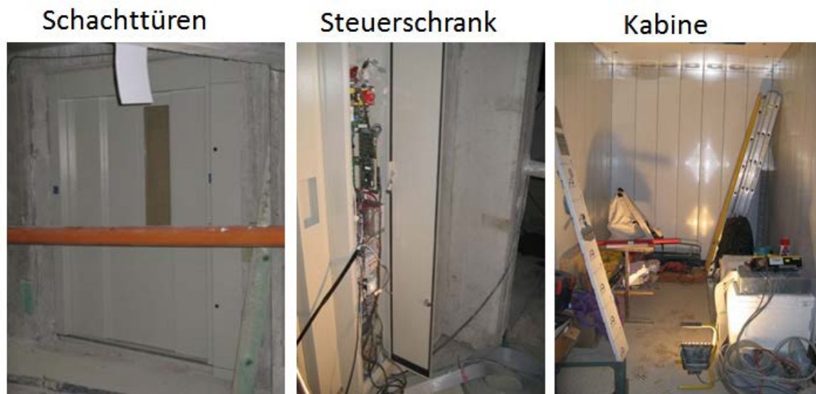
Abb. 36: Montierte Schachttüren, Steuerschrank und Kabine 115
