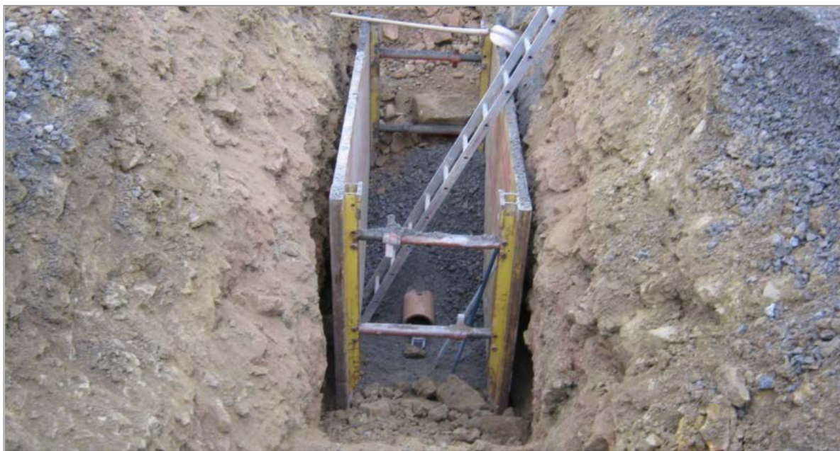
Abb. 15: Kanalverlegung am Sportplatz 24
