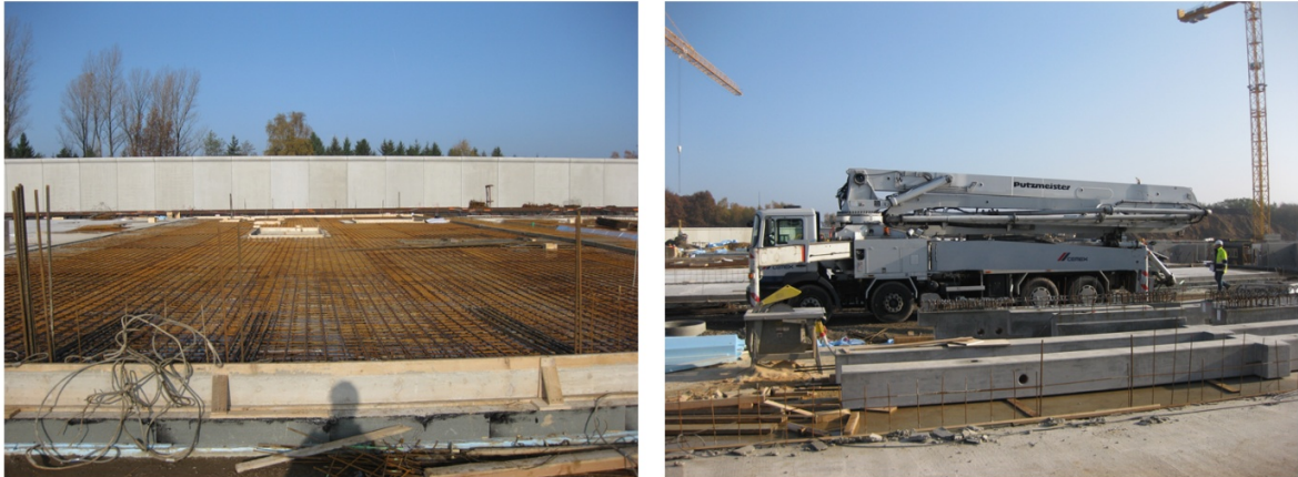
Abb. 8: Betonieren der Bodenplatte: Bewehrung und Transportbetonpumpe 15
