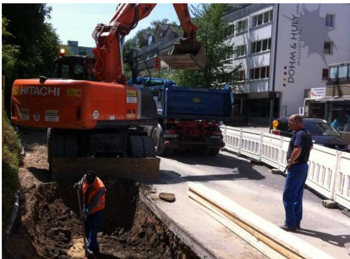
Abb. 4.33: Bagger beim Ausschachten 171
