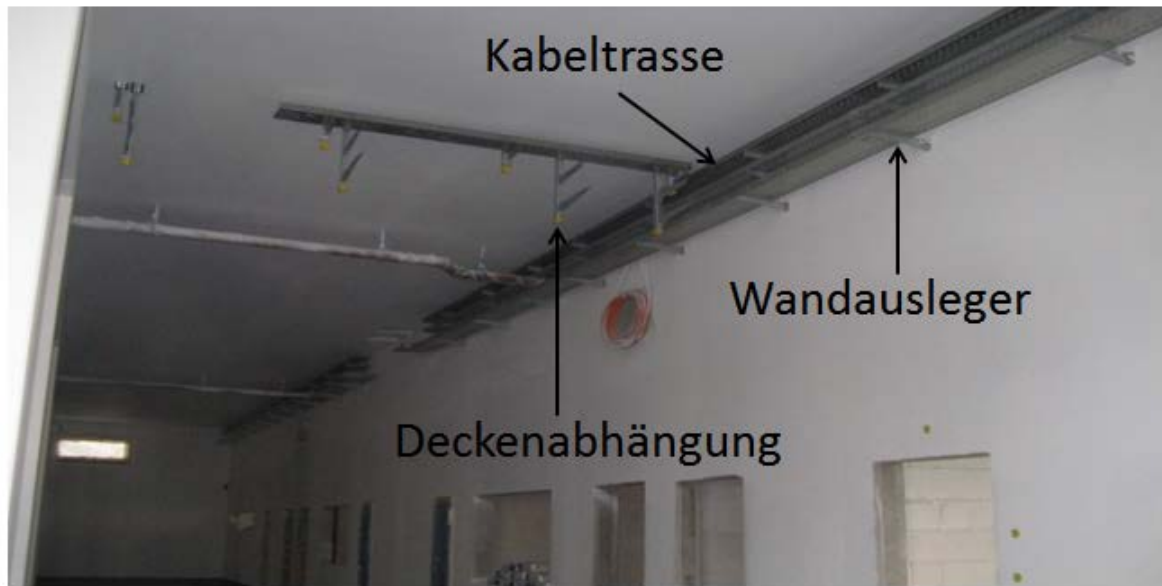
Abb. 19: Installierung einer Kabeltrasse 60
