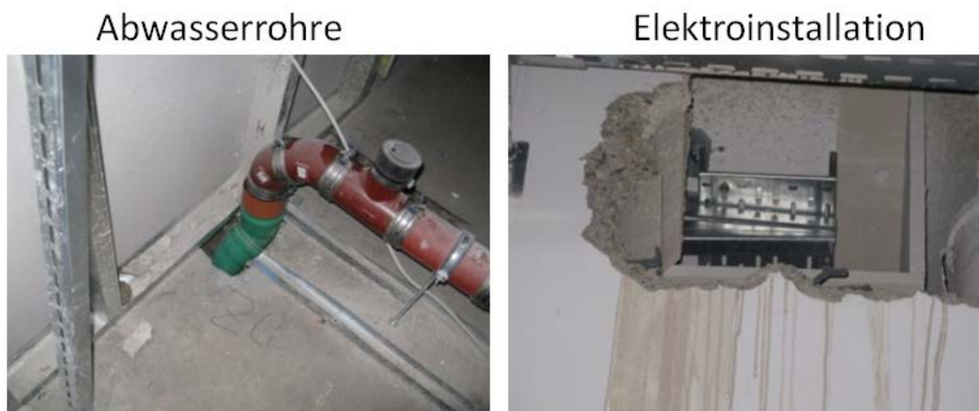
Abb. 45: Durchgeführte Durchbrüche 142
