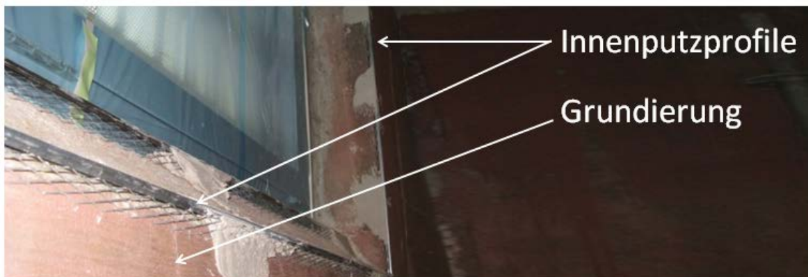
Abb. 22: Innenputzprofile an einer Fensteröffnung 71
