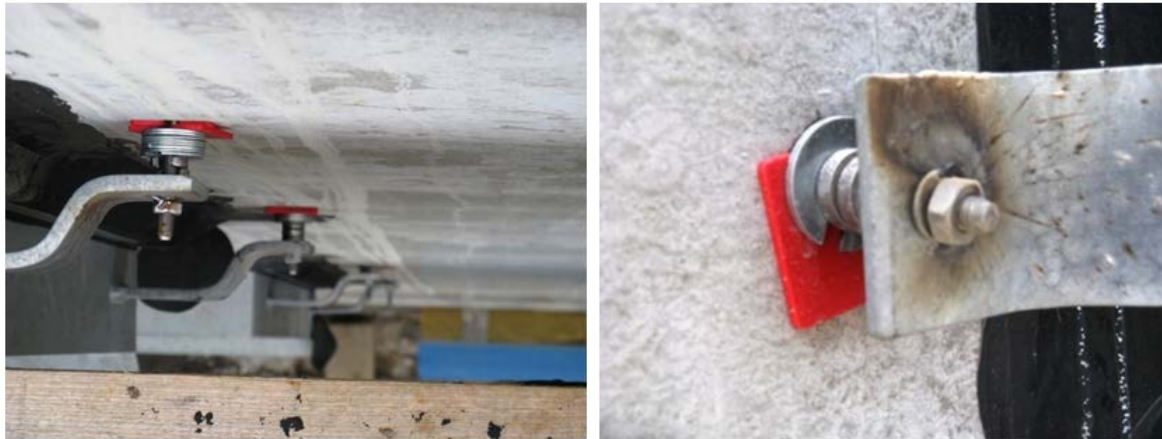
Abb. 2: Ausgleichen von Abweichungen mit Unterlegscheiben und Verschweißen 3
