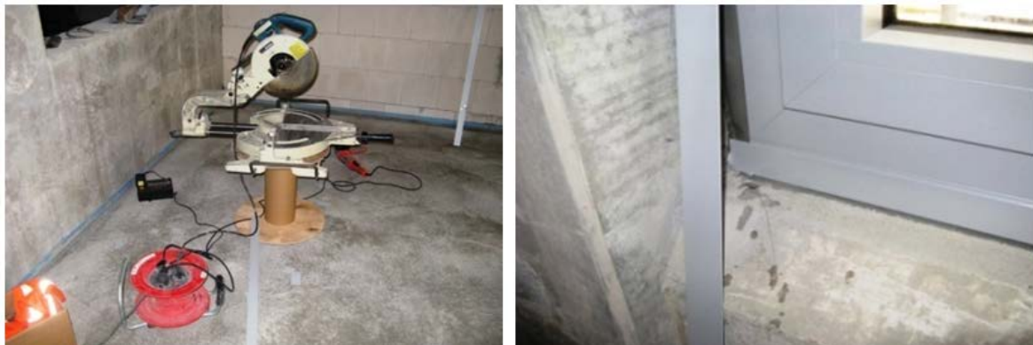
Abb. 5: Kapp- und Gehrungssäge und Leiste auf der Fuge 13
