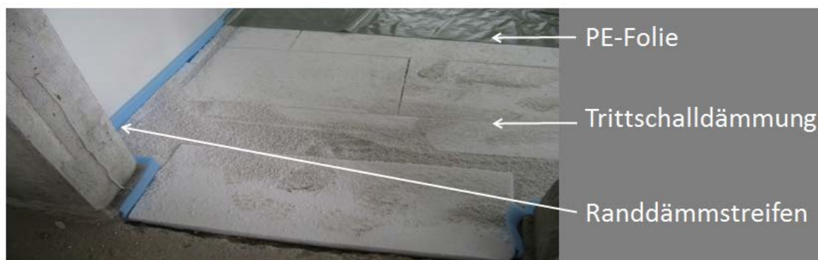
Abb. 25: Verlegen der Trittschalldämmung, PE-Folie und Randdämmstreifen 80
