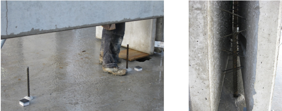
Abb. 13: Einbau einer Fertigteil-Hohlwand: Einpassen der Stahlstifte 22
