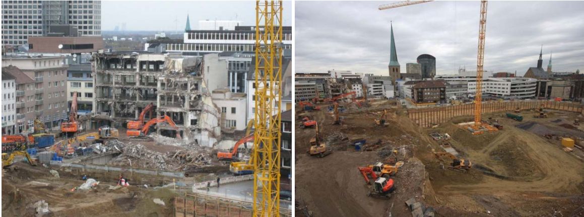
Abb. 4.3: Baumaßnahme THIER Galerie: Abriss und Erdbau 97
