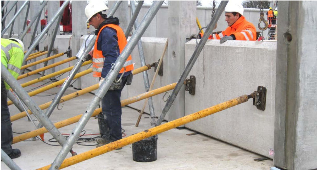
Abb. 23: Einbau einer Fertigteil-Brüstung 45
