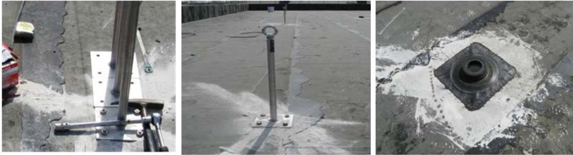
Abb. 10: Montage der Dachabsturz Sicherungen und der Dachabläufe 31
