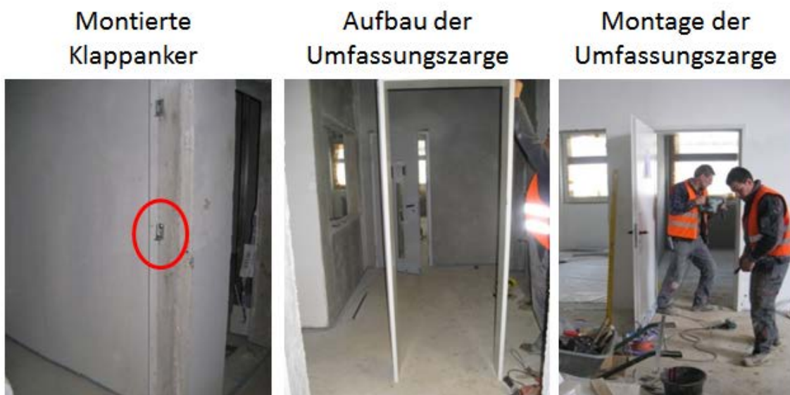
Abb. 39: Montage der Klappanker und Umfassungszarge 126
