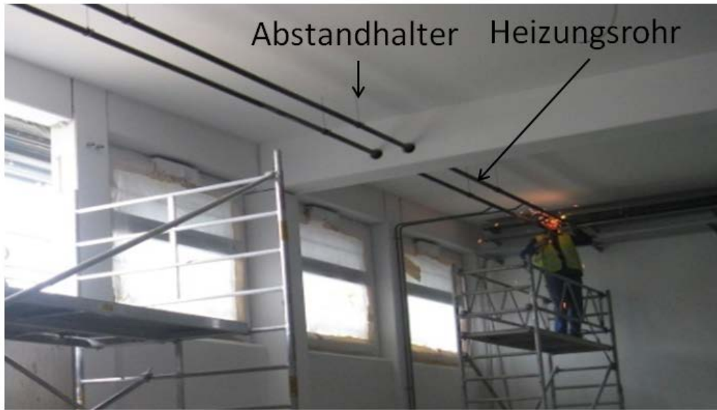
Abb. 31: Installierte Heizungsrohrleitungen 98
