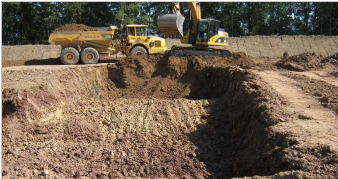
Abb. 21: Ausschachten einer Baugrube 34
