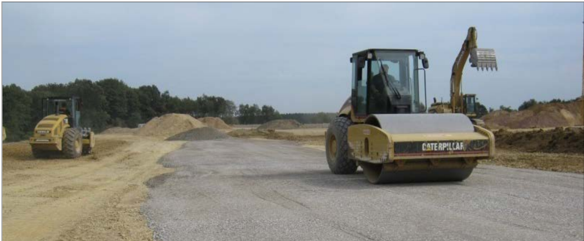
Abb. 13: Verdichten einer Baustraße mit einem Walzenzug 21
