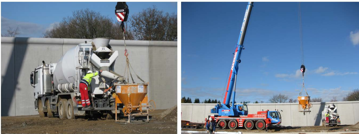
Abb. 4: Betonieren der Sauberkeitsschicht: Befüllen und Schwenken des Betonkübels 7
