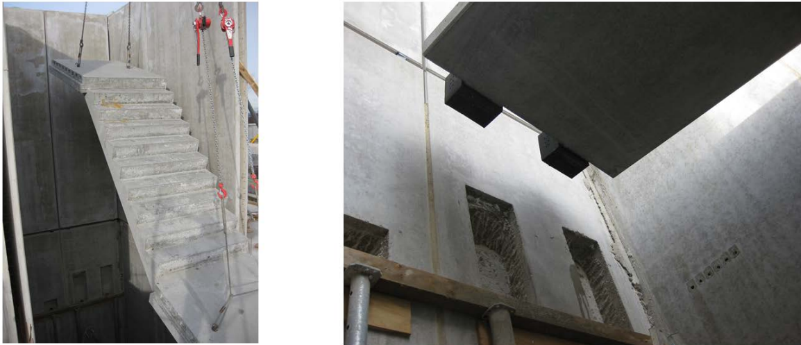
Abb. 31: Einpassen der Fertigteil-Treppe 62
