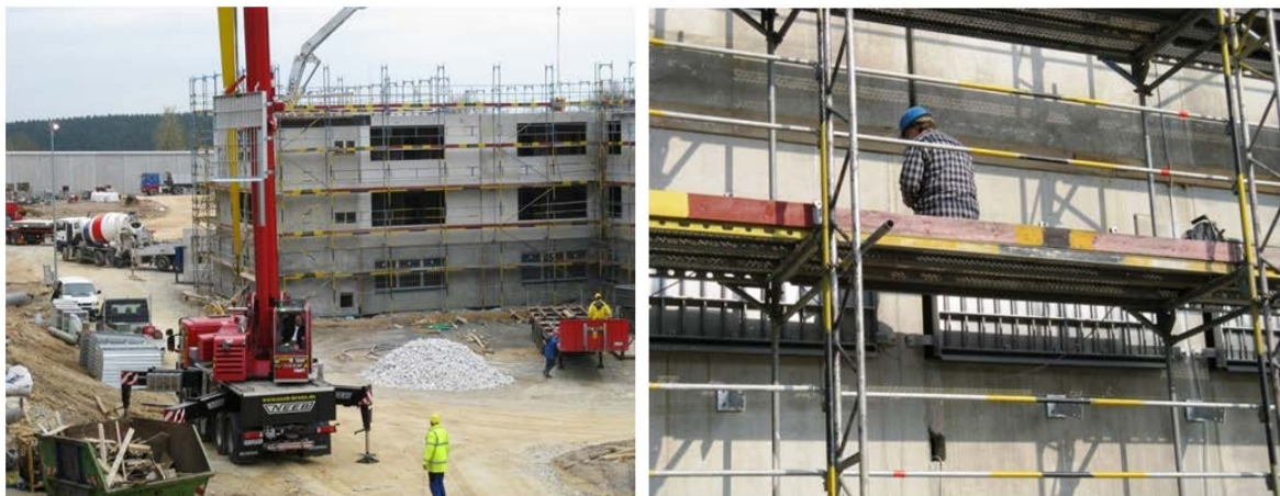
Abb. 1: Einheben der Vergitterung mit einem Mobilkran und anschließende Montage 1
