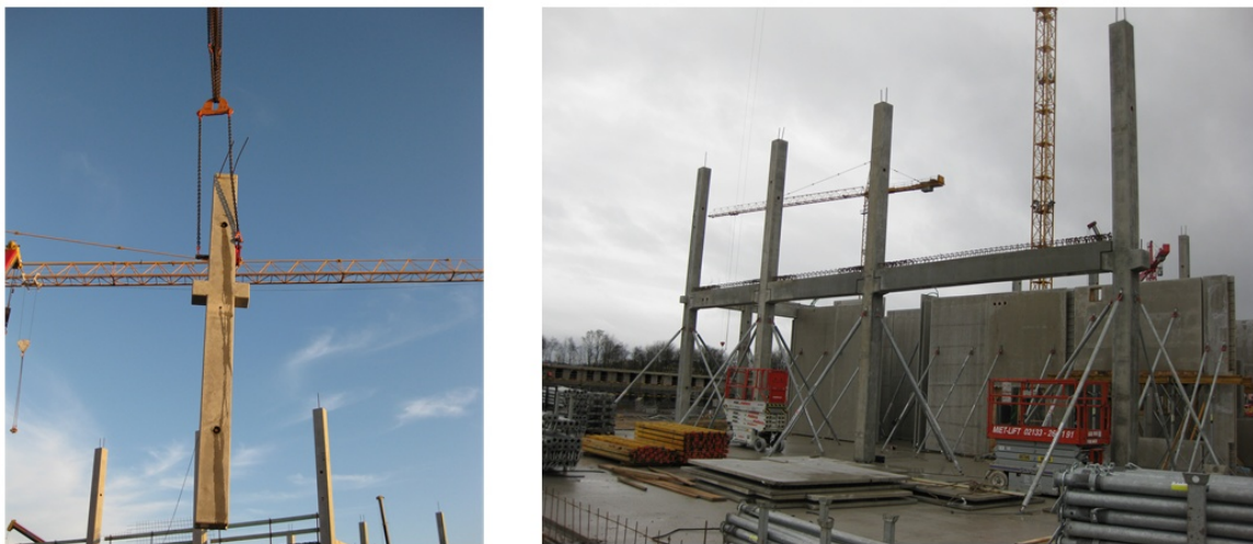
Abb. 19: Einbau der Fertigteil-Stützen 34
