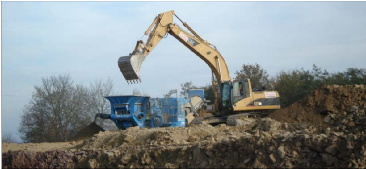
Abb. 5: Brechen von Fels auf der Miete der JVA 10
