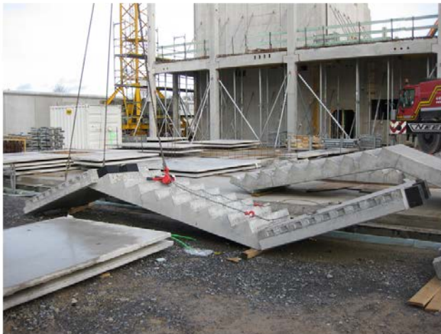
Abb. 30: Einbau der Fertigteil-Treppe 60
