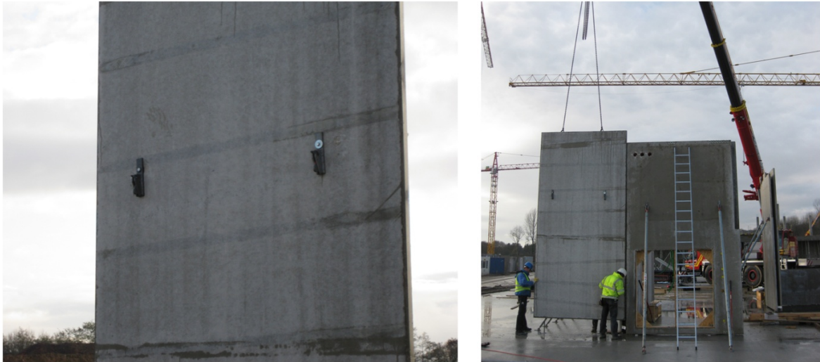
Abb. 12: Einbau einer Fertigteil-Montagehülsen und Einheben an Anschlagmitteln 21
