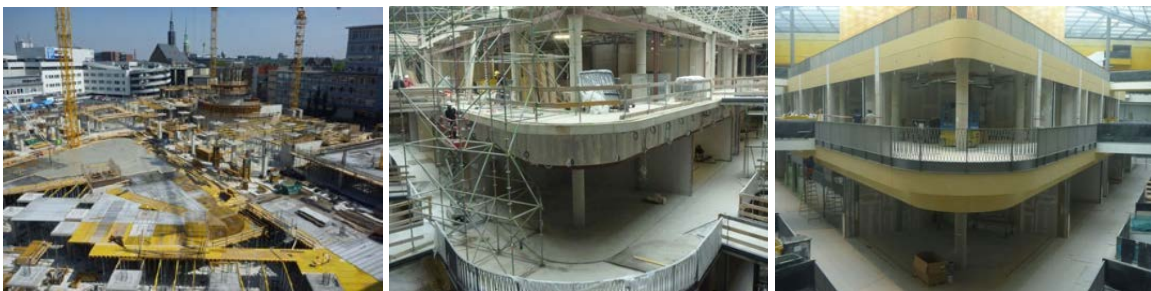
Abb. 4.4: Baumaßnahme THIER Galerie: Rohbau- und Ausbauarbeiten 98
