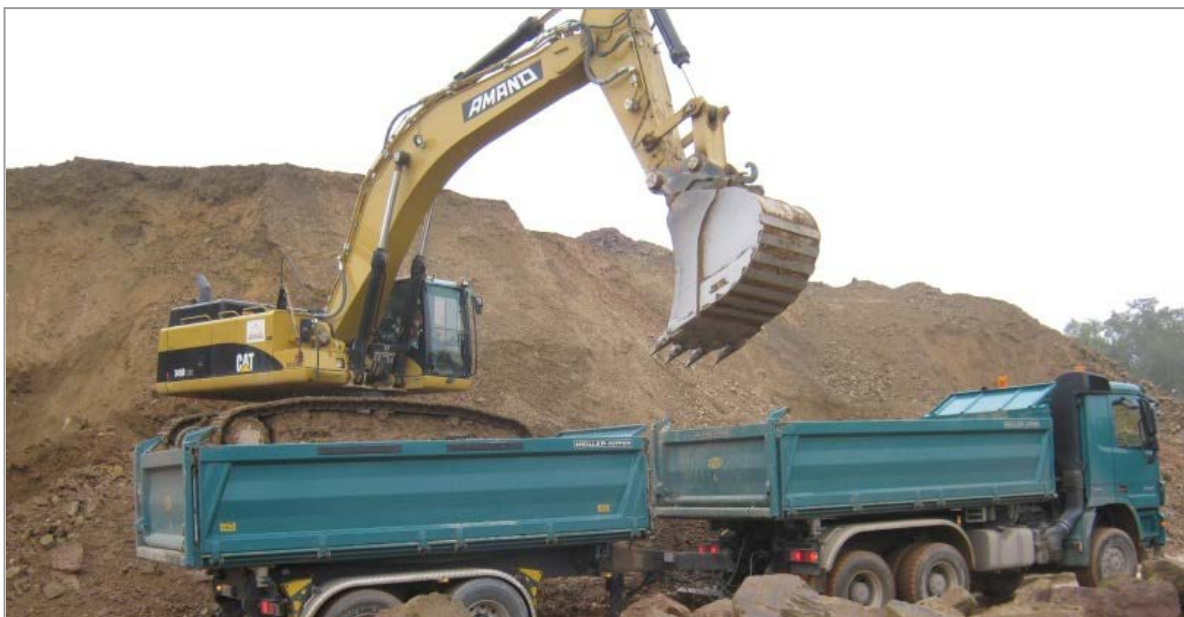
Abb. 3: Umschlagen von Boden vom Bagger auf LKW 4
