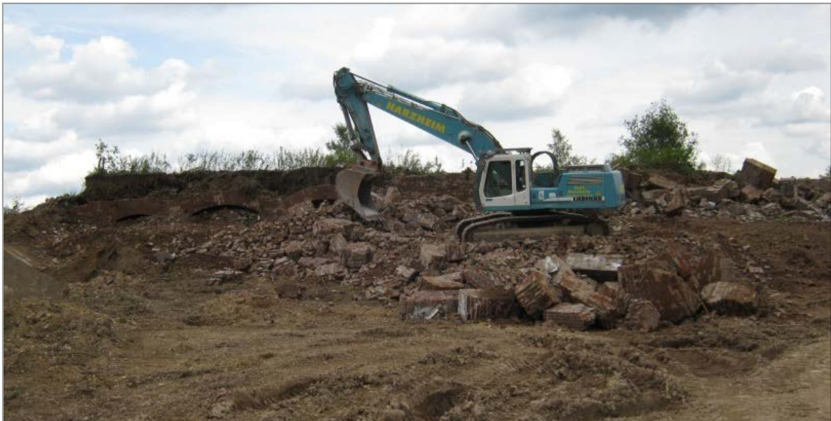
Abb. 19: Abtrag von Betonresten der ehemaligen Schießwand 32
