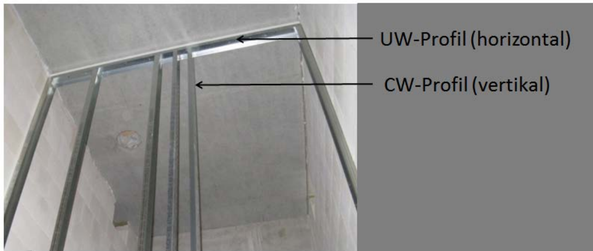
Abb. 41: Trockenbau Unterkonstruktion aus UW- und CW-Profilen 133
