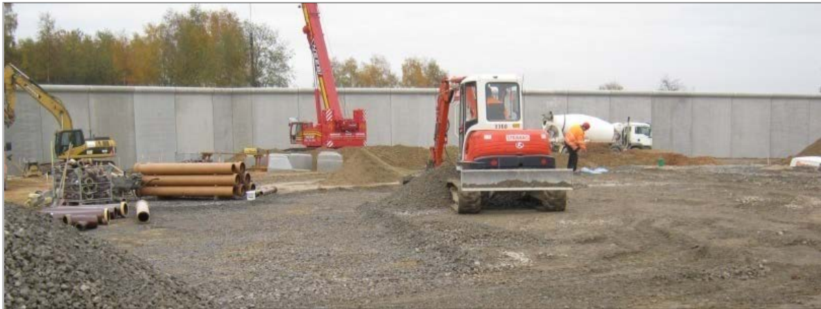
Abb. 11: Erstellen eines Schotterplanums mit einem Minibagger 19
