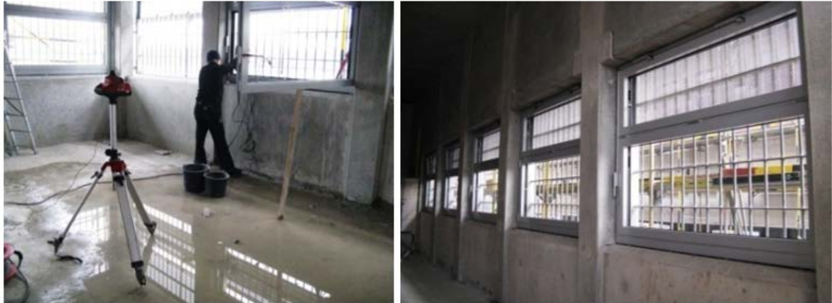
Abb. 3: Rotationslaser zum Ausrichten der Fenster nach dem Einbau in der Werkhalle 9
