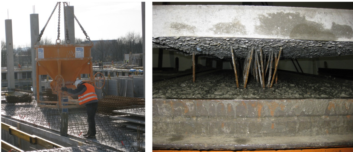
Abb. 16: Ausbetonieren der Fertigteil-Hohlwand 30
