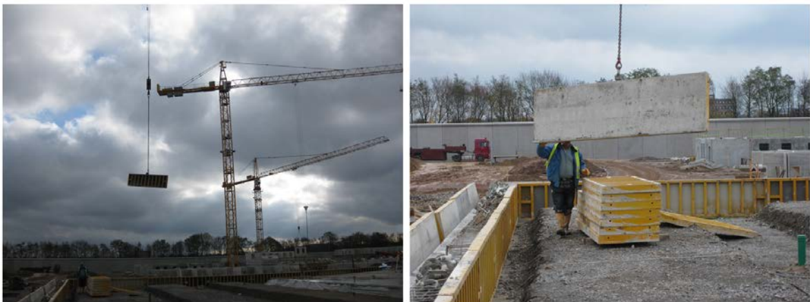
Abb. 1: Einbau von Schalelementen mittels TDK 2
