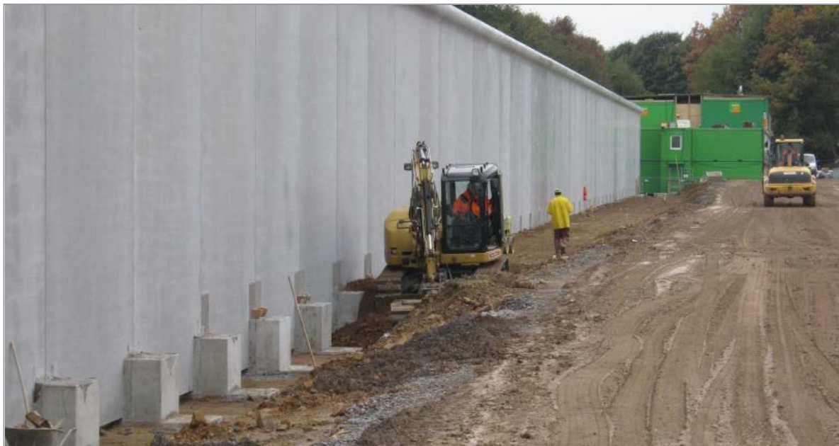
Abb. 7: Verfüllen der Fundamente der Haftmauer 14
