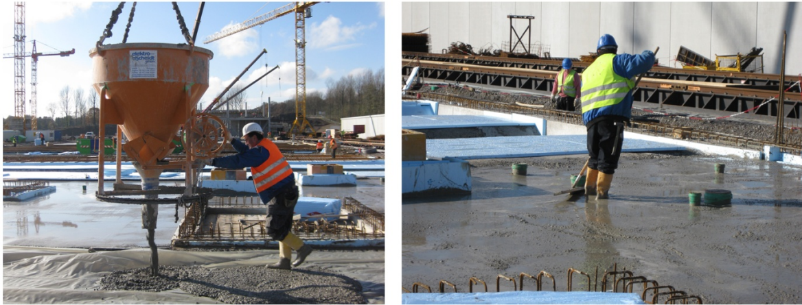
Abb. 5: Betonieren der Sauberkeitsschicht: Verteilen und Glattstreichen des Frischbetons 9
