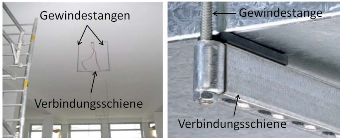
Abb. 33: Befestigungskonstruktion aus Gewindestangen und Verbindungsschienen 106
