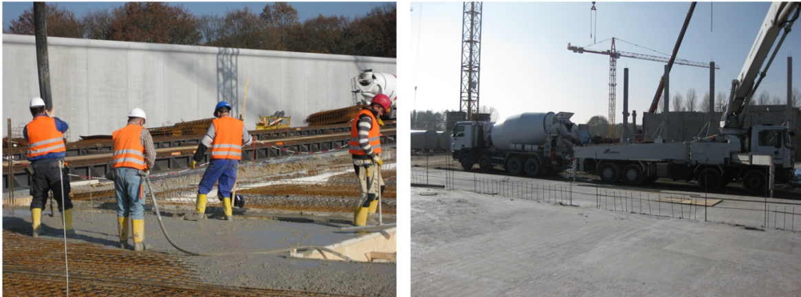
Abb. 9: Betonieren der Bodenplatte: Betoniervorgang und Endzustand 17
