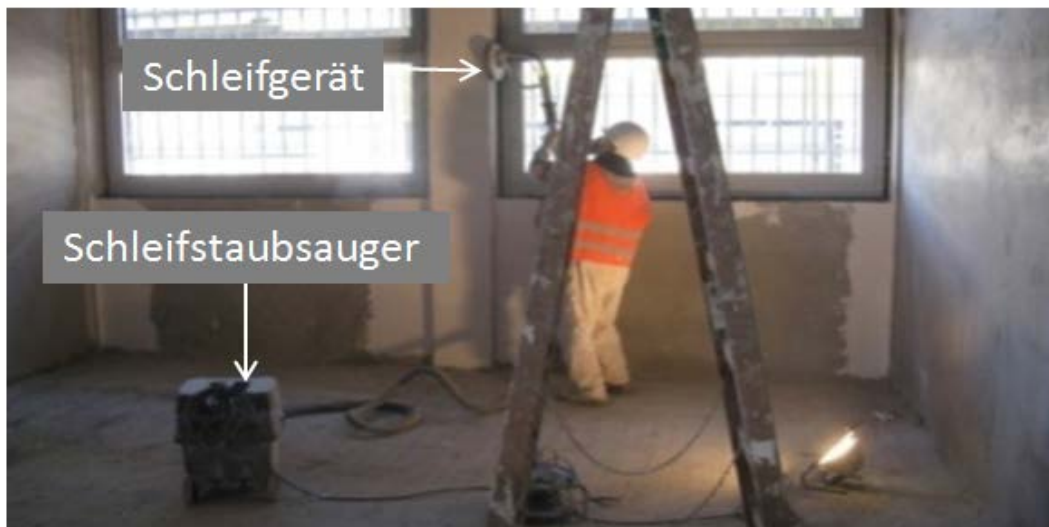
Abb. 15: Abschleifen der gespachtelten Flächen 49
