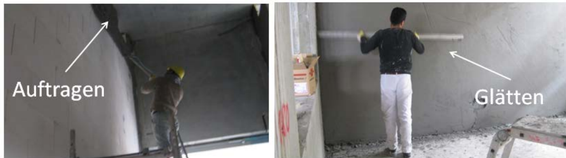
Abb. 23: Auftragen und Glätten des Putzes 73
