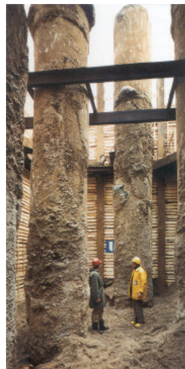
Abbildung 1-2: Freigelegte Pfähle
