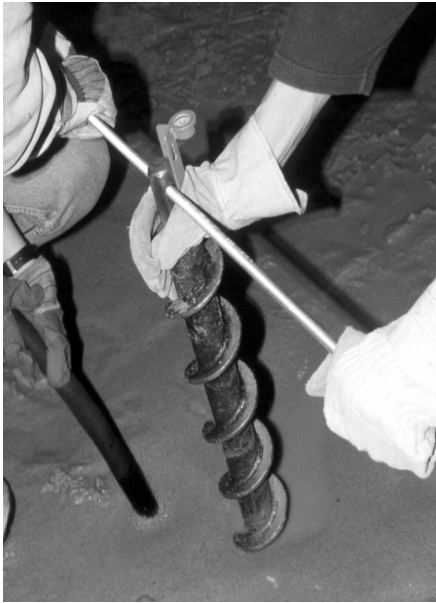
Abbildung 5-15: Pfahleinbau bis 60 cm Länge
