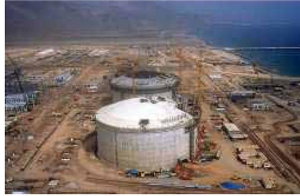
Bild 3.2: Zwei Flüssiggasbehälter im Bauzustand in Oman, Fassungsvermögen je 120000 m<sup>3</sup> [DyWI]
