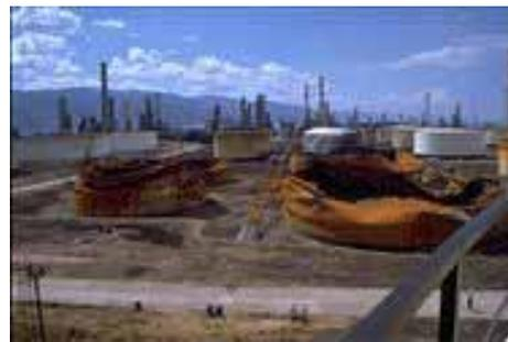
Bild 1.3: Ausgebrannter Tank in der Türkei 1999 [EERC]
