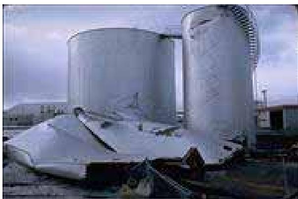
Bild 3.10: Durch Erdbeben zerstörter Tank [EERC]
