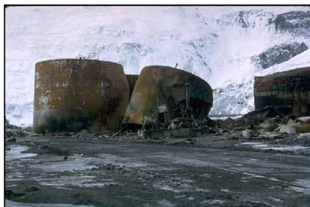
Bild 3.11: Zerstörung durch Erdbeben und Brand [EERC]
