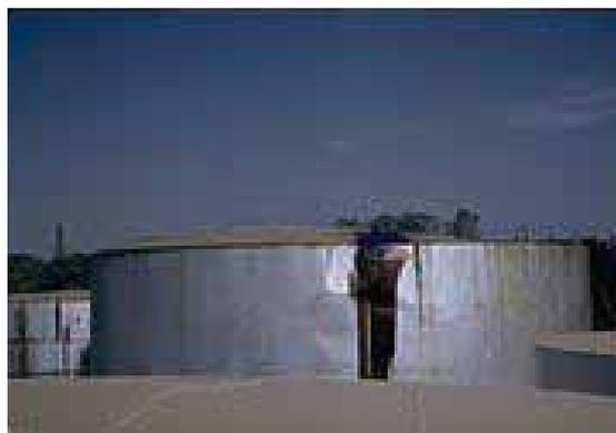
Bild 3.18: Aufreißen der Tankwand [EERC]
