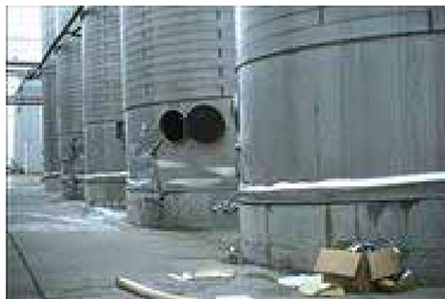
Bild 3.21: Im Jahr 1980 durch das Erdbeben in Kalifornien beschädigte Weintanks [EERC]
