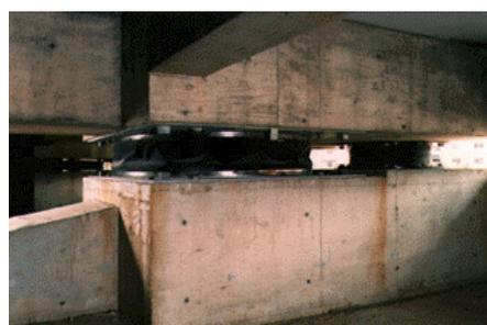
Bild 3.7: Sliding Bearing
