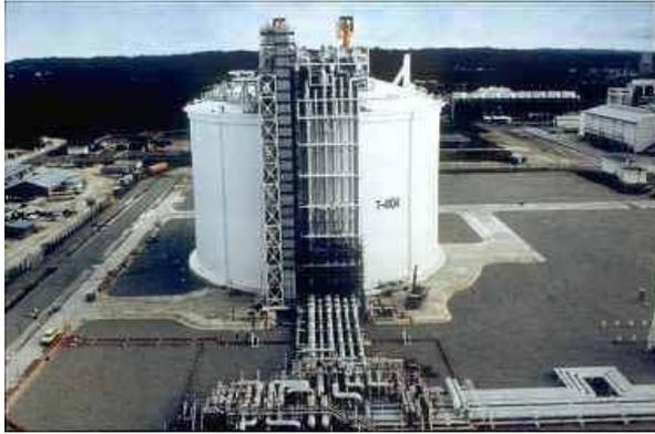
Bild 3.1: Flüssiggastank in Brunei mit einem Fassungsvermögen von 65000 m<sup>3</sup> [DyWI]
