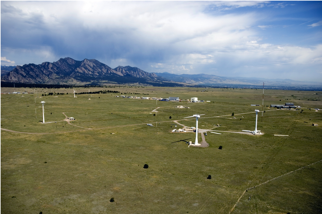
Abbildung 7.2: Luftaufnahme der CART2 vom Juni 2006 (NREL)
