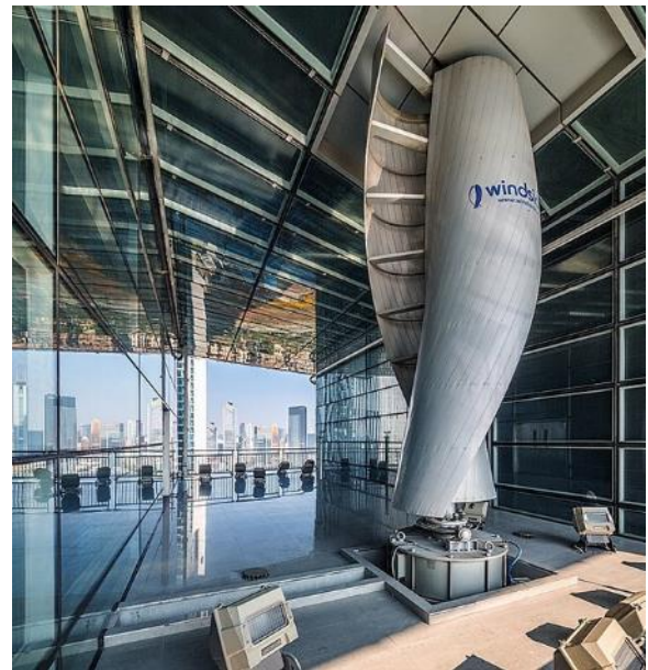
Abbildung A-44: Adaption des Savonius-Rotors als verdrehte Vertikal Windturbine im trichterförmigen Zwischenraum eines Technikgeschosses des Pearl River Tower in Guangzhou (s. Abbildung A-43). Quelle Skidmore, Owings & Merrill, Foto Tim Griffith
