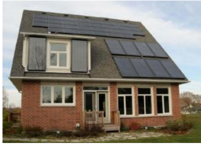
Abbildung 9-9: Der additive und teilflächige Charakter der Solarthermie- und -stromanlagen beim Einfamilienhaus „Minto Ecohome“ (s. CA_4) offenbart eine fehlende Abstimmung zwischen Gebäudeentwurf und Technikkonzept. Quelle The Minto Group
