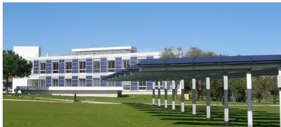
Abbildung 7-30: Das Verwaltungs- und Laborgebäude „SOLAR XXI“ (s. PT_1) erreicht die ausgeglichene Energiebilanz erst durch die Ergänzung der Solarstromanlage in der Fassade (12 kW p ) durch weitere 205 kW p auf dem Grundstück. Die mittlerweile unter den zusätzlichen PV-Modulen parkenden PKW werden verschattet und sollen damit weniger Kraftstoff für die Klimaanlage aufwenden. Foto Helder Gonçalves und Pedro Cabrito, LNEG Lissabon
