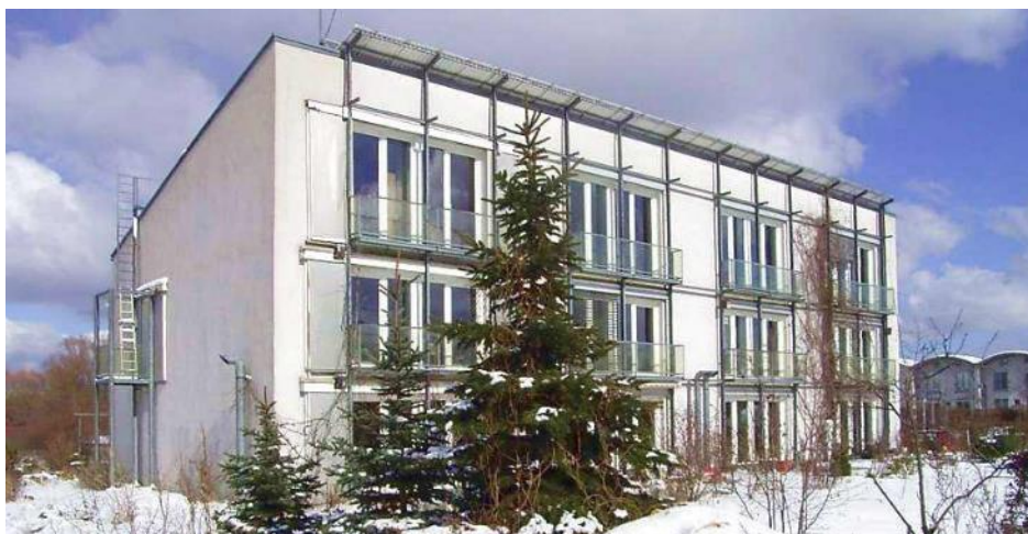
Abbildung 5-5: Das erste Passivhaus wird 1991 in Darmstadt errichtet. Der trapezförmige Querschnitt vergrößert die südlich orientierte Fassade mit den bei einem Passivhaus üblichen großen Fenstern. Die Wärmeversorgung erfolgt über Warmwasser-Vakuumkollektoren in Verbindung mit einem 1 \text{ m}^3 Warmwasserspeicher und einer Erdgas-Brennwerttherme [Feist 2007]. Quelle Passivhaus Institut Darmstadt
