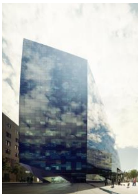
Abbildung 9-26, 9-27 und 9-28: Das „Power house I“ in Trondheim (s. NO_1) beschreibt den Einfluss des Ziels der ausgeglichenen Energiebilanz bei hohen und dichten Gebäuden durch die extreme Keilform. Ein homogenes Gesamtbild wird durch ähnliche Materialitäten in Dach (PV-Anlagen) und Fassade (verspiegelte Gläser) erreicht. Quelle Internet, Foto Snøhetta / MIR
