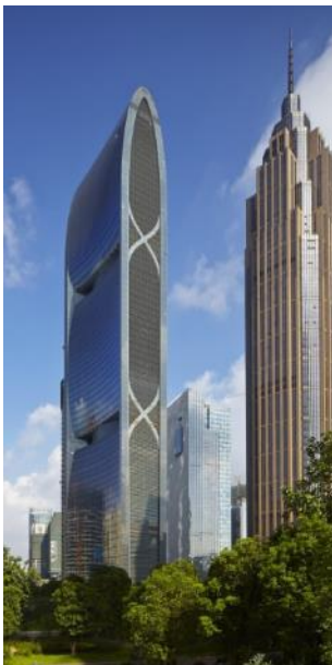
Abbildung A-43: Beim Pearl River Tower in Guangzhou (s. CN_1) trägt die Form zum Energieertrag bei. Die vier trichterförmigen Öffnungen in beiden markanten Technikgeschossen leiten den Windstrom zu dort positionierten Windturbinen (s. Abbildung A-44). Die eigentlich relativ geringen Winde aus verschiedenen Richtungen werden hierüber verstärkt und kanalisiert und steigern damit die Effizienz der Windturbinen um das 2,5-fache.
