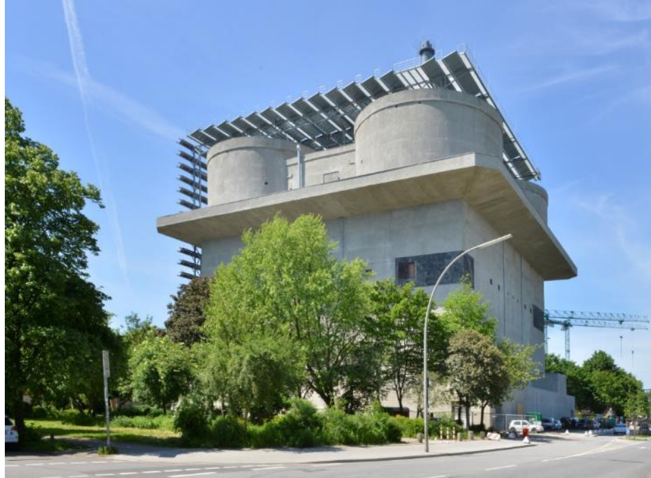
Abbildung 4-8: Der seit dem zweiten Weltkrieg ungenutzte Bunker in Wilhelmsburg (Hamburg) wurde im Zuge der Internationalen Bauausstellung IBA bis 2013 zum sog. „Energiebunker“ umgebaut und beliefert nun 800 umliegende Wohneinheiten mit Wärme aus einem Biomethan-Blockheizkraftwerk, einem Holzackschnitzel-Kessel sowie Solarthermieanlagen. Ein 2.000 m 3 großer Wassertank speichert die Wärme zwischen. Mittelfristig sollen 3.000 Wohneinheiten mit Wärme versorgt werden. Auf der Dach- und südliche Fassadenfläche erzeugen Solarstromanlagen auf einer Fläche von 3.000 m 2 Strom. Quelle Internet, Foto IBA Hamburg GmbH / Martin Kunze
