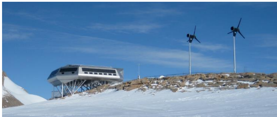
Abbildung 5-7: Die 200 m 2 große Belgische Forschungsstation „Princess Elisabeth“ (s. AQ_1) wird in der Antarktis über Windturbinen und Solaranlagen autark betrieben. Diese decken den Strom- und Wärmebedarf von bis zu 48 Personen. Das energieautarke Konzept hat auf Grund der Windenergieerträge kaum formalen Einfluss. Quelle International Polar Foundation, Foto René Robert
