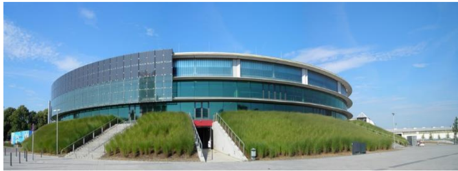
Abbildung 7-60: Der großzügig verglaste Erschließungsbereich der „EWE Arena“ in Oldenburg (2005, asp Architekten) wird von einer dem Sonnenstand nachgeführten Photovoltaikanlage mit transluzenten Modulen umfahren. Hierüber wird der gegenüber einer Aufdachanlage eigentlich reduzierte Energieertrag der Solarstromanlage (ca. -30 %) wiederum maximiert, wobei sie zugleich als beweglicher Sonnenschutz und sicherlich auch als Marketinginstrument dient. Die kreisrunde Geometrie der Veranstaltungshalle bietet für diese Aufgabe günstigste Voraussetzungen. Laut Projektteam kann auf eine aktive Kühlung ebenso verzichtet werden, wie auf Kunstlichteinsatz (tagsüber). Quelle Internet, Foto A. Christians
