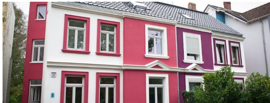
Abbildung 3-16: Eines der ersten im Zuge der Internationalen Bauausstellung 2013 (IBA) in Hamburg beispielhaft sanierten Gebäude war die Doppelhaushälfte „Auf der Höhe“. Die unter Berücksichtigung des „IBA-Exzellenz-Sanierungsstandards“ umgesetzte Sanierung des 1886 erbauten Hauses umfasst u.a. eine Außenwanddämmung der Putz-Straßenfassade durch ein Wärmedämmverbundsystem unter Nachbildung der Zierelemente bzw. durch Kerndämmung der Luftschicht im Erdgeschoss. Zudem wurden auch Dachflächen (Aufsparrendämmung) und Kellerdecke (Zwischenbalkendämmung) gedämmt sowie dreifachverglaste Fenster mit Sprossung eingesetzt. Eine Lüftungsanlage mit WRG, ein Holzpelletkessel und eine thermische Solaranlage ermöglichen einen Jahresprimärenergiekennwert von unter 30 kWh/m 2 NGFa . Quelle IBA Hamburg GmbH, Foto Johannes Arlt
