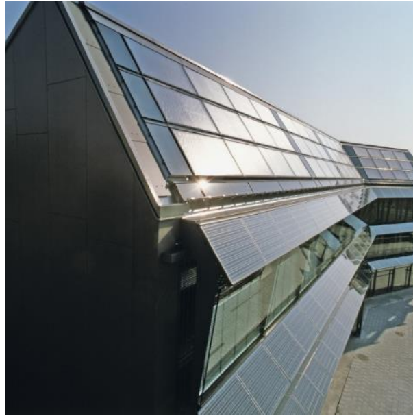
Abbildung 9-1: Die Verbindung von Verschattung und Stromerzeugung wird am Geschäftshaus C in Esslingen (CH_16) mittels einer zweiten Fassade, die sich als zweite Haut über die hoch gedämmte innere Holzelementfassade faltet, architektonisch ausgedrückt. Nach Süden orientiert, nimmt sie transluzente PV-Module und Solarkollektoren auf und verschattet hierüber die Fenster. Quelle Stücheli Architekten, Foto Robert Zimmermann
