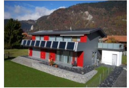
Abbildung 9-11: Sofern Solaranlagen auf Auskragungen installiert sind, die sich aus der Gebäudeform ergeben und diese vollflächig bedecken, gelten sie nicht als additiv. Beim „MINERGIE-A-Eco“-Projekt „Sol-Arch 2 “ (s. CH_22) wird dies dennoch so gewertet, da die Solarkollektoren nicht in die Balkonbrüstung integriert sind und sich generell ein stark auf die Technik ausgerichtetes Erscheinungsbild ergibt. Die kaum einsehbare Solarstromanlage auf dem Dach gilt hingegen als vollflächig und integriert. Quelle MINERGIE / Architekturbüro Jürg Wegmüller
