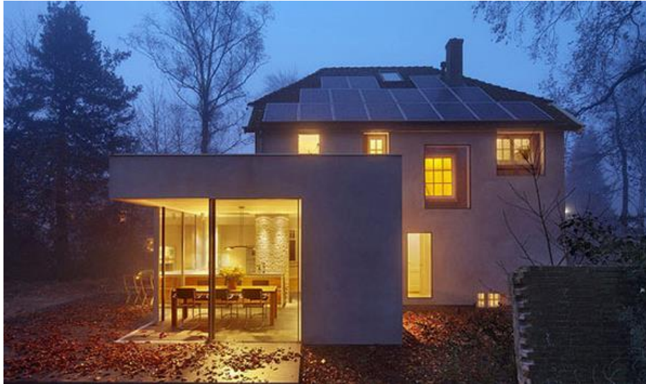
Abbildung 8-26: Bei dem denkmalgeschützten und zu einem Nullenergiehaus sanierten Einfamilienhaus in Driebergen (s. NL_9) sind die 17 Photovoltaik-Module mit polykristallinen Solarzellen auf das bestehende Dach aufgesetzt worden. Die neue Dämmung des Daches erfolgte - anders als an der Fassade - allein von innen
