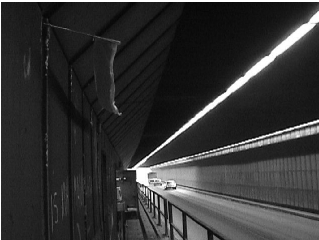
Abbildung 2-11: Meßplatz im Wuppertaler Kiesbergtunnel.
