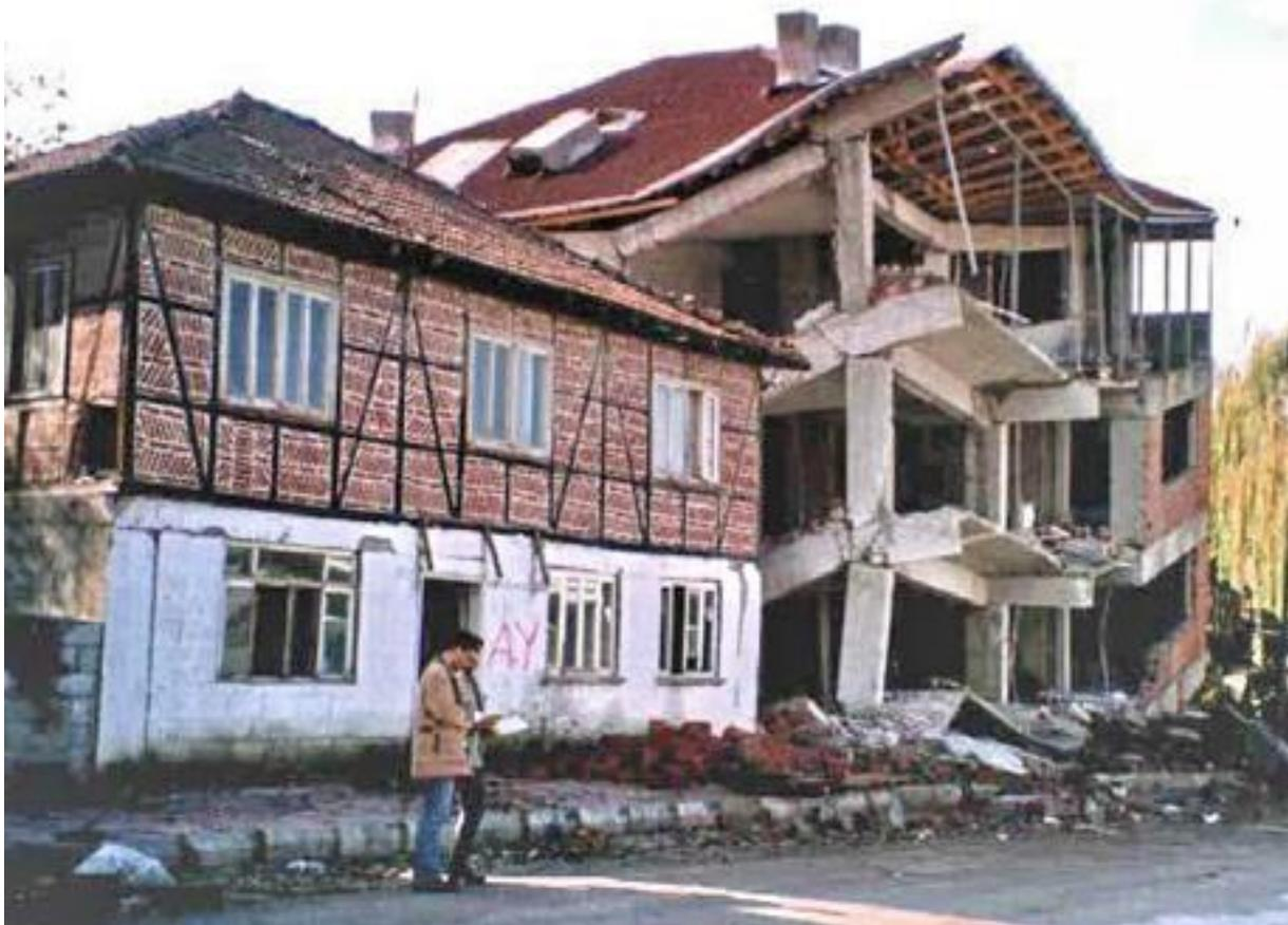
Bild 4-1: Erdbebentüchtigkeit von Fachwerk- bzw. moderner Betonbauweise
