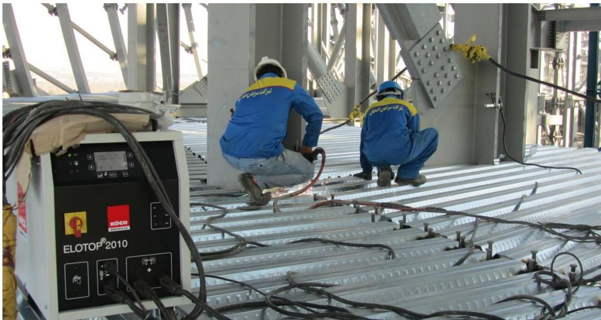
Bild 4-3: Automatisches Kopfbolzenschweißen, auch auf Baustellen sicher
