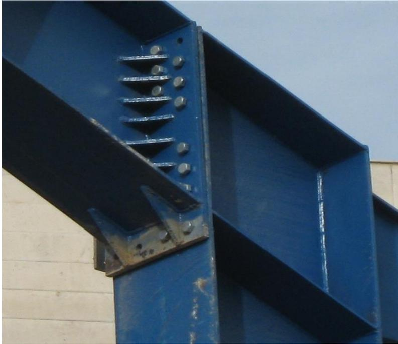
Bild 7.1-4: Rahmenecke im Entwicklungsland, Auffälligkeiten
