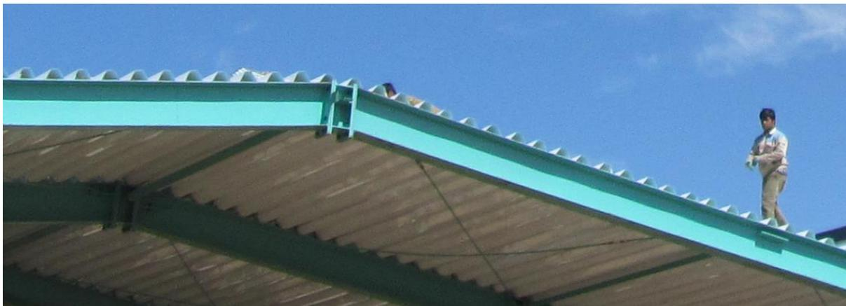
Bild 7.1-7: First-Zwischenstück mit Folgefehlern für das gesamte Tragwerk
