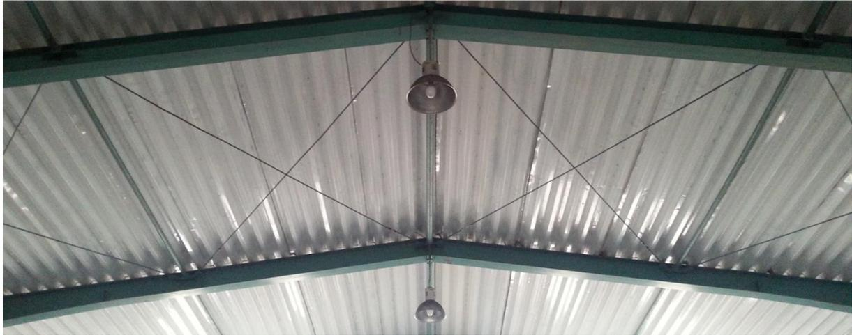
Bild 7.1-10: Unzulässige Dacheindeckung, Knittern und Beulen der Trapezbleche
