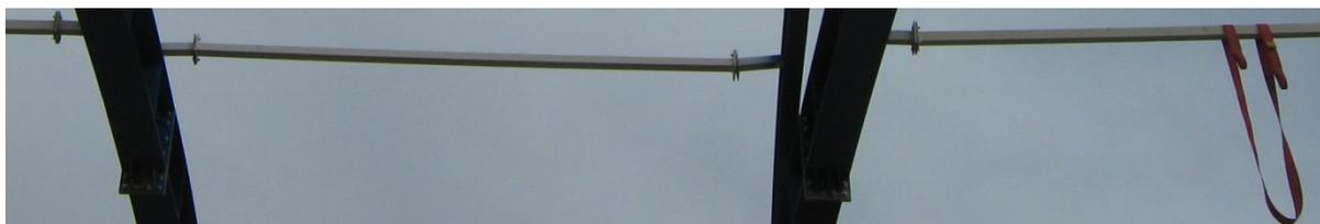
Bild 7.1-3: Knick im Montagestoß von Druckstäben
