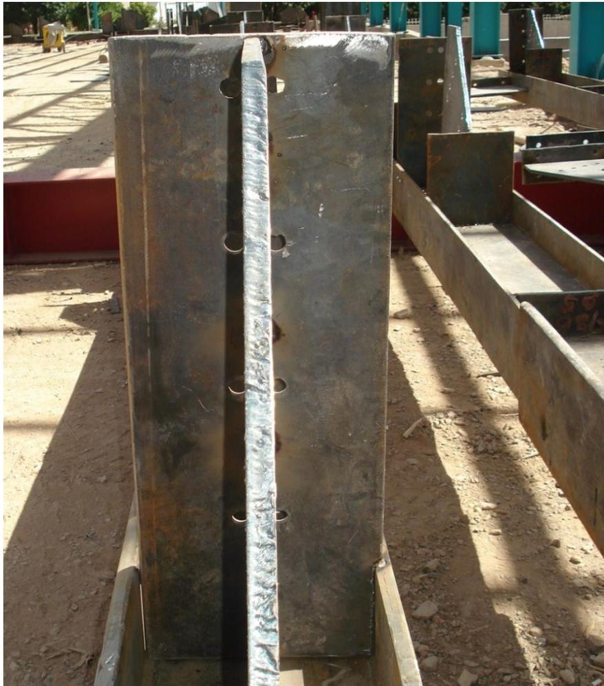
Bild 7.1-6: Serienanschluss mit nicht montierbarem Schraubenbild
