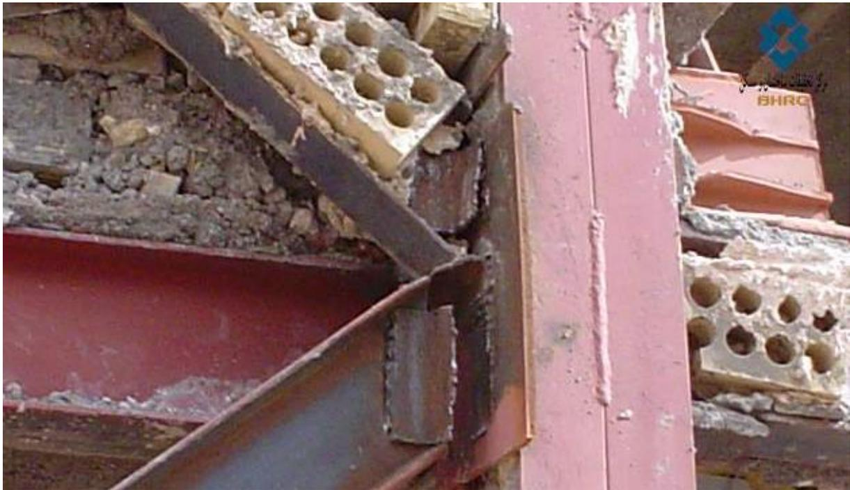
Bild 3-2: Anschlussdetails: Typische Baumängel, nach Erdbeben sichtbar
