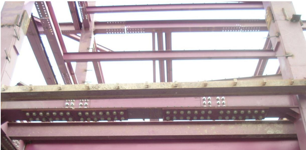
Bild 3-5: Ineffiziente Anschlüsse eines typischen Geschosßbaus
