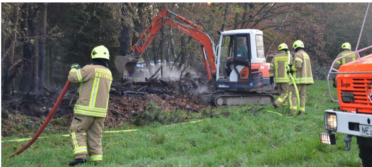
Abb. 7.1.4/4: Sind größere Haufen von organischem Material betroffen, die nur schwierig manuell umgeschichtet werden können, können für das Schaffen eines Zugangs zu Glutnestern oder das Umgraben von organischen (und damit brennbaren) Böden (z.B. Torf) auch entsprechende Maschinen genutzt werden. (Foto: Feuerwehr Ratingen)
