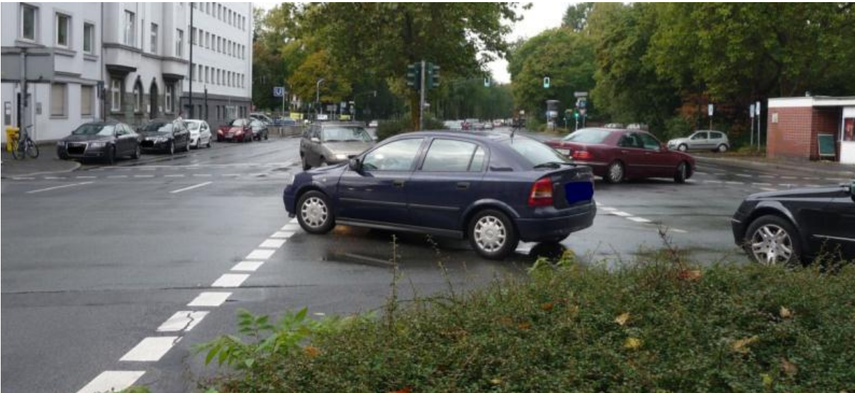
Abbildung 92: Knotenpunkt 2 - Sichtbehinderung für Linksabbieger (und Wender) durch Mittelstreifen und Fahrzeuge des Gegenverkehrs (Foto: Seipel)
