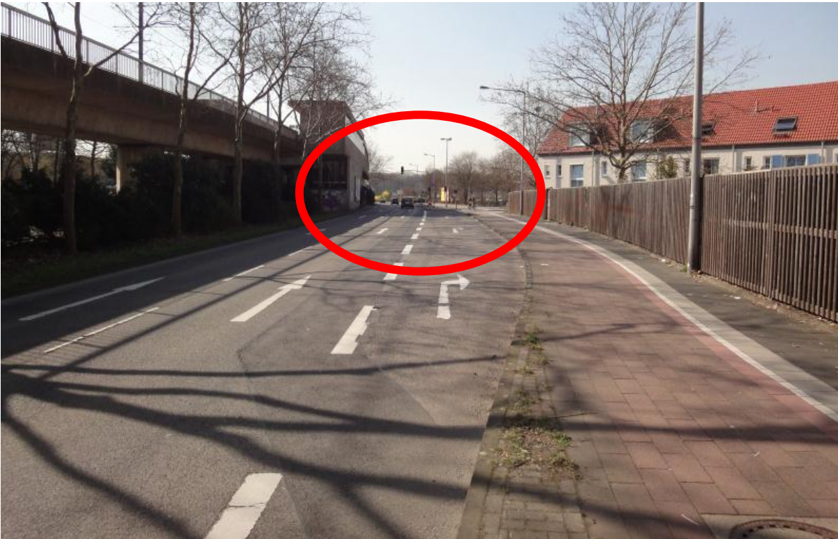
Abbildung 105: Knotenpunkt 5 – Zufahrt aus Arm 3 in Blickrichtung der Furt (Foto: Seipel)
