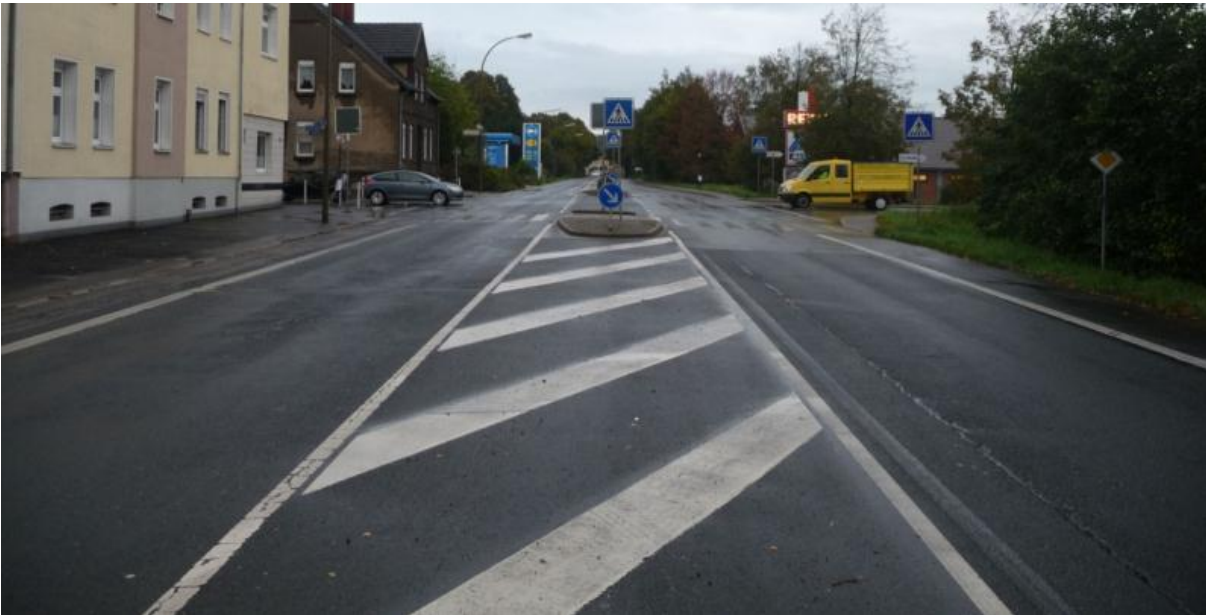
Abbildung 137: Knotenpunkt 11 - Sicht auf Kreuzungsbereich aus Arm 2 (Foto: Seipel)
