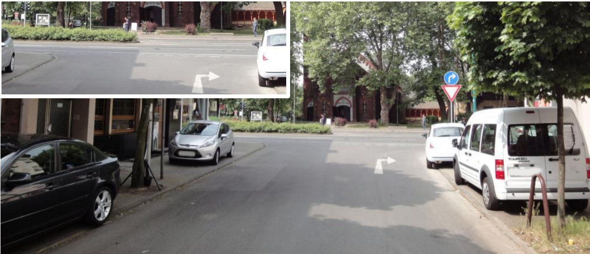
Abbildung 56: Radverkehrsfurt aus Sicht der einbiegenden Kraftfahrer nicht zu erkennen (Foto: Seipel)
