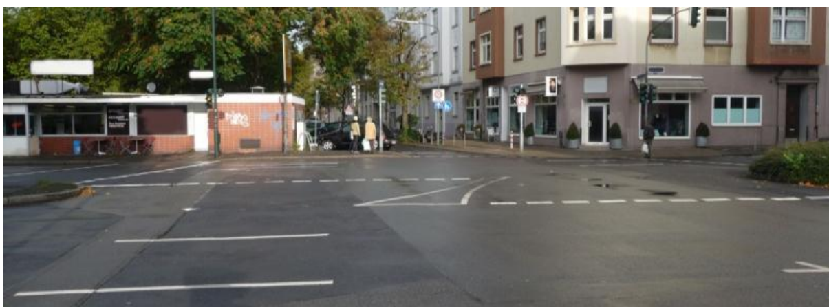
Abbildung 90: Knotenpunkt 2 - Markierung im Kreuzungsbereich (von links Zufahrt 1, von rechts Zufahrt 3) (Foto: Seipel)
