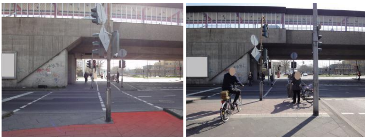
Abbildung 103: Knotenpunkt 5 – Aufstellflächen auf Dreiecksinsel am „Freien Rechtsabbieger“ aus Arm 3 in Arm 4 in Blickrichtung Südost (im Bild links ist der rot eingefärbte Bereich für den Radverkehr hervorgehoben) (Fotos: Seipel)
