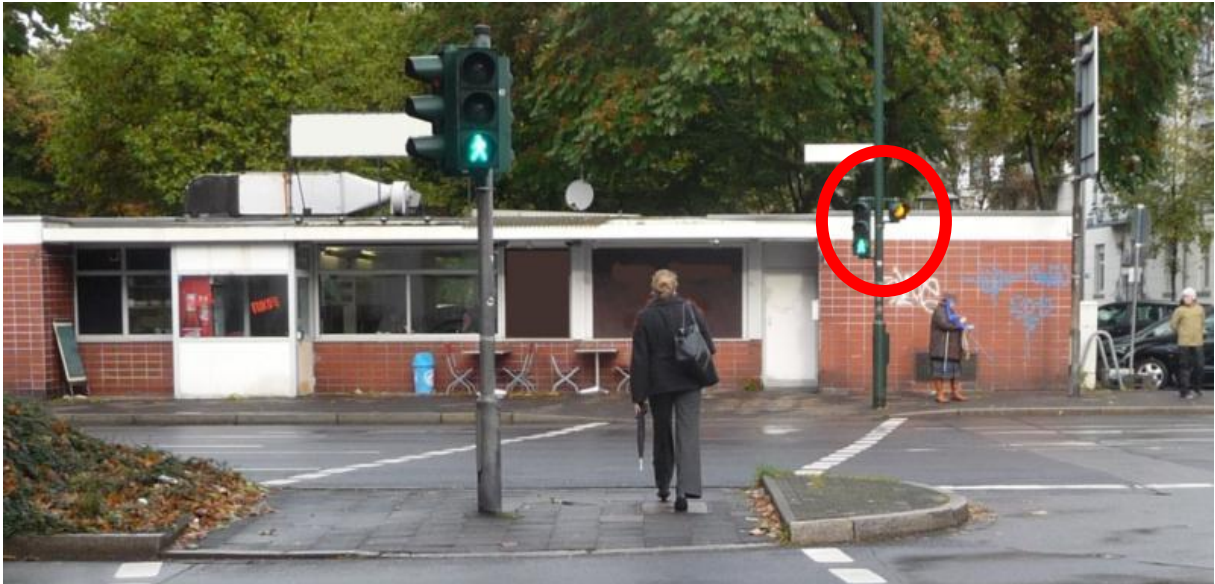
Abbildung 94: Knotenpunkt 2 – Hilfssignalgeber (gelbes Blicklicht) an Fußgängerfurt (Foto: Seipel)
