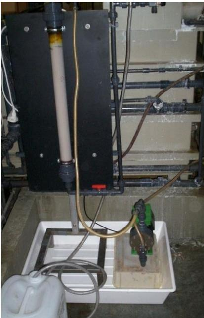
Abbildung 79: Anionenaustauscheranlage bei der Firma Galvano Röhrig GmbH.
