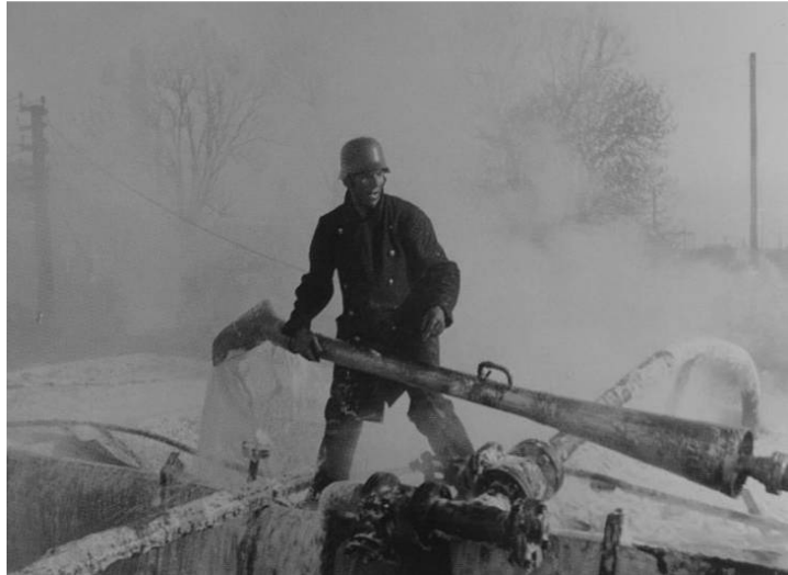
Abbildung 3-1 Feuerwehrmann mit Luftschäumrohr [25]
