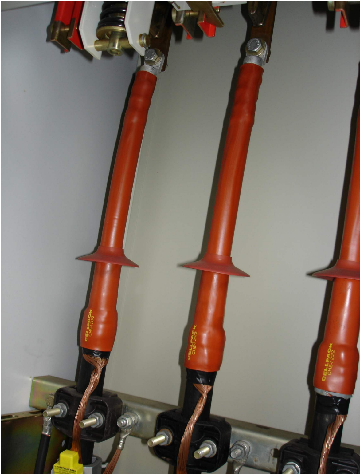
Abbildung 4.32.: Anwendungsbeispiel von Kabelendverschlüssen in einem Schalt-schrank [mit freundlicher Genehmigung der Cellpack GmbH, Radeberg].
