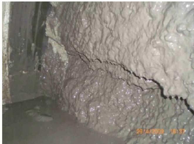
**Abbildung 4.22:** Mehrausbruch der Ortsbrust in sehr durchlässigen Kiesen, Quelle: [115]
