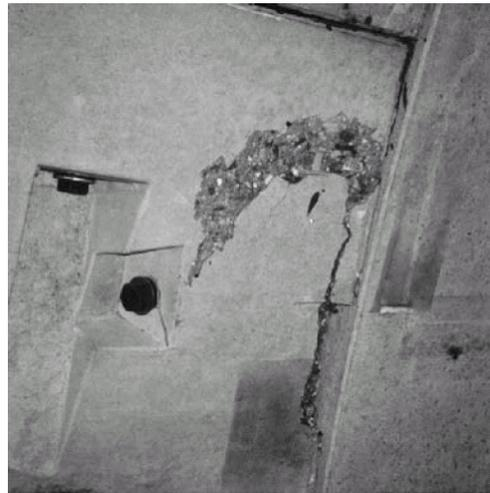
**Abbildung 1.16:** Typisches Schadensbild bei Überbelastung einer Topf-Nocke-Konstruktion, Quelle: [42]
