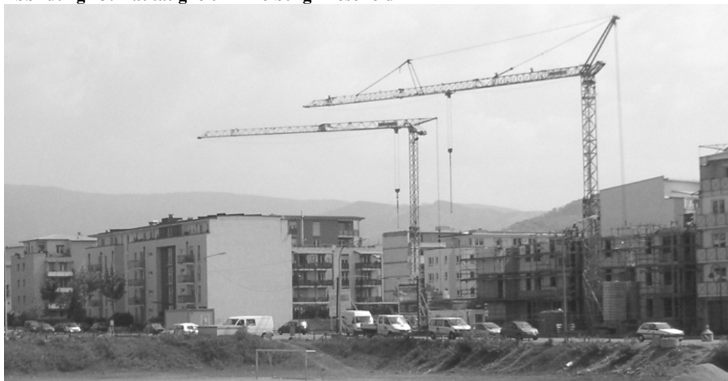
Abbildung 23: Bautätigkeit in Freiburg-Rieselfeld
