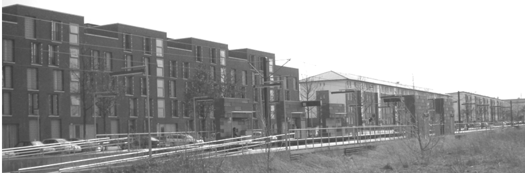
Abbildung 16: Neubaugebiet Hannover-Kronsberg mit Stadtbahntrasse im Vordergrund
