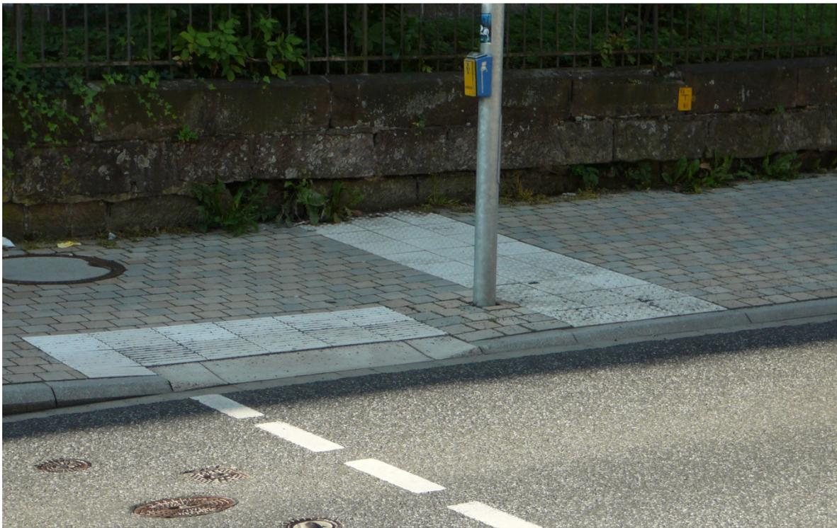
Abbildung 57: Überquerungsstelle mit differenzierten Bordhöhen: Absenkung auf Fahrbahnniveau (links) und Hochbord mit tastbarer Bordkante (rechts) [Foto: Boenke]
