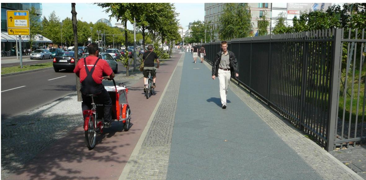
Abbildung 65: Optisch und taktil gut erkennbare Trennung von Flächen des Rad- und Fußverkehrs [Foto: Boenke]
