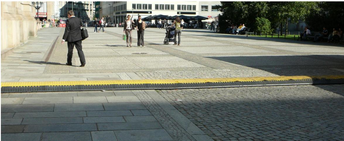
Abbildung 62: Kontrastreiche Markierung eines temporären Kabelkanals zur Minimierung der Stolpergefahr und Verbesserung der Überfahrbarkeit [Foto: Boenke]
