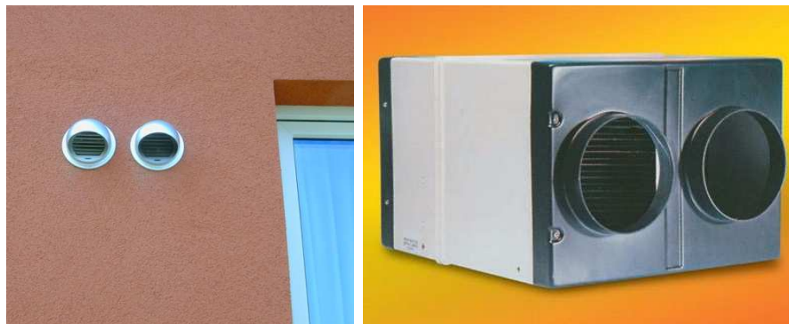
Bild 3.33) Außenansicht eines installierten dezentralen Lüftungsgeräts mit WRG (links), Lüftungsgerät selbst (rechts). Inwiefern es durch die nahe beieinanderliegenden Aussen- und Fortluftauslässe zu Kurzschlussströmungen kommt, wurde messtechnisch nicht ermittelt. Bilder: links: [SCJ05], rechts: [BENZ04]
