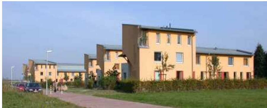
Bild 2.29) Ansicht des Wohnheimkomplexes auf dem Solarcampus Jülich .
