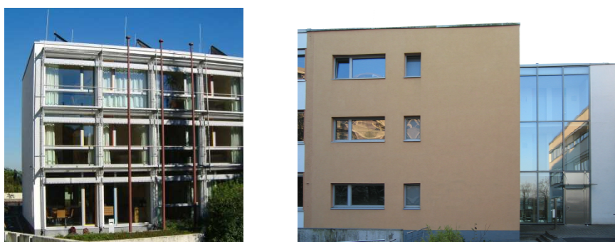
Bild 2.12) West (links) und Ostfassade (rechts) der Bildungsherberge. Auf der Südwestseite liegen 13 Einzelapartments, auf der Nordostseite sind drei behindertengerechte Doppelzimmer untergebracht. Im Erdgeschoss befindet sich ein Gemeinschaftsraum mit Küchenzeile. Bilder: P. Engelmann
