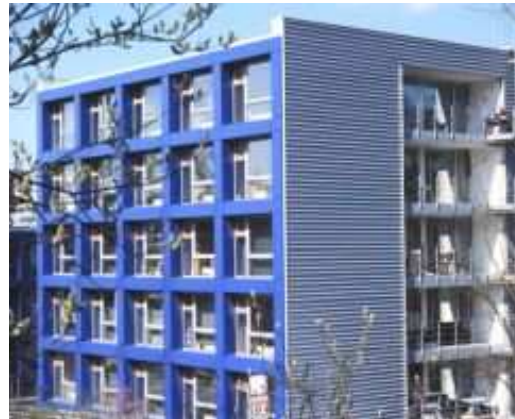
Bild 3.74) Die Wohnheime Simmeringer Hauptstraße in Wien (li, Bild: Bruno Klomfar) und Albert Einstein Str. in Wuppertal (re, Bild: HSW). Das Wiener Wohnheim ist wie die Molkereistraße ein Gästehaus für Austauschstudierende mit Wohngemeinschaften für 2 bis vier Personen. Das Wohnheim in der Albert Einstein Straße besteht aus fünf Häusern, mit Wohnungen für zweier- und dreier WGs.
