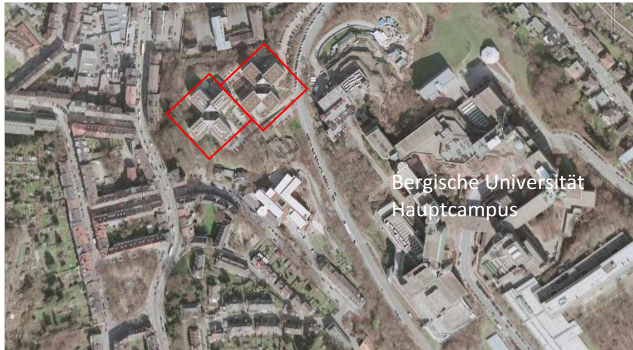
Bild 2.1) Luftaufnahme der beiden sanierten Gebäude. Auf dem Bild ist der Kreuztypus der beiden Gebäude, sowie die Lage unmittelbar am Fuß des Hauptcampus der Bergischen Universität Wuppertal zu erkennen. Bild: Google Earth
