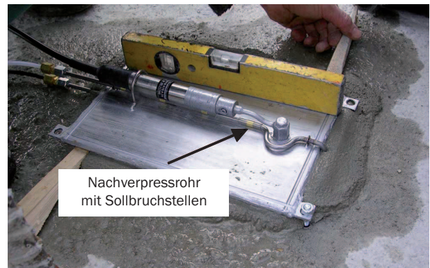
Bild 4.7: Schrumpfspalt nach Hydratationsphase des Betons (links) und Druckkissen mit Nachverpressvorrichtung (rechts)
