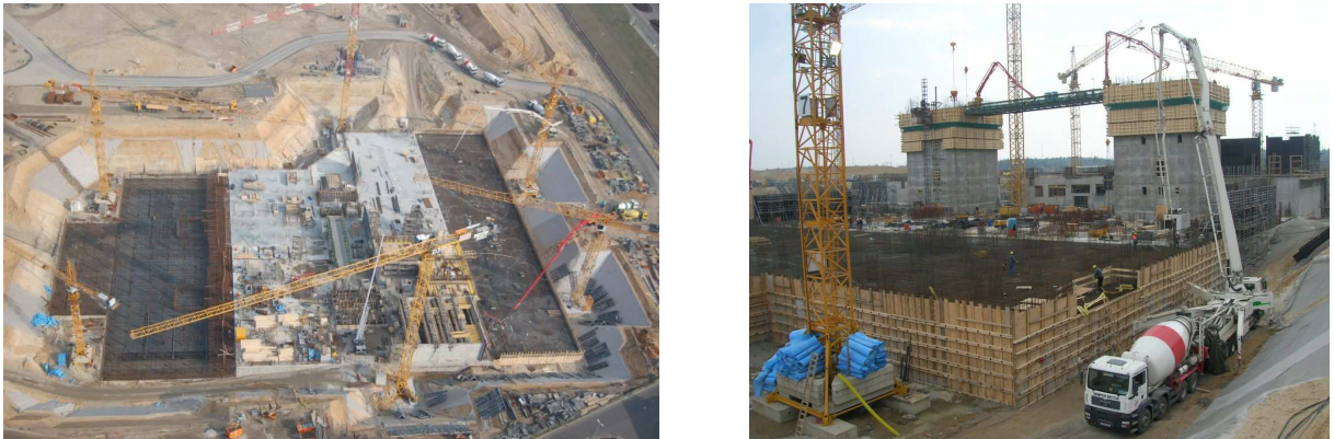
Bild 4.13: Gesamtansicht der Bodenplatte (links) und Beginn des Kletterns der Treppentürme (rechts)
