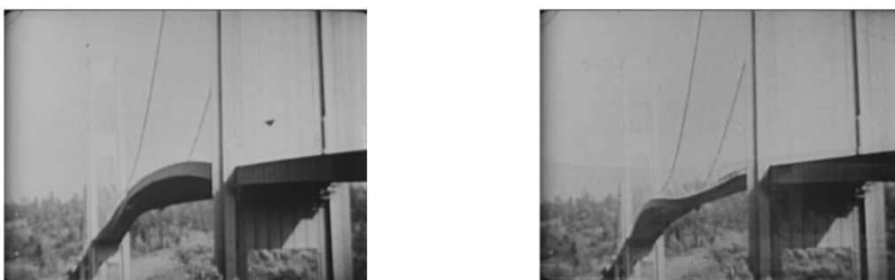
Abb. 2: Aeroelastisch instabile Schwingungen der TACOMA NARROWS Brücke [80]
