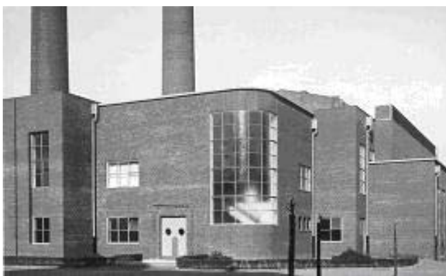
Schaltstation von 1931 - Vorderbau
