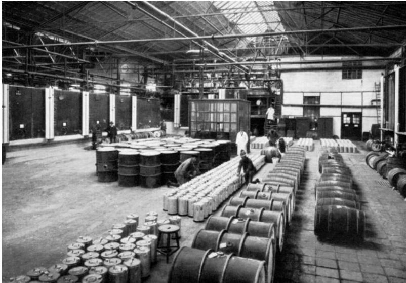
Abb. 207: Abfüllraum der Wasserglasfabrik – Architekt: Walter Furthmann; Quelle: HENKEL 1926, S. 81.
