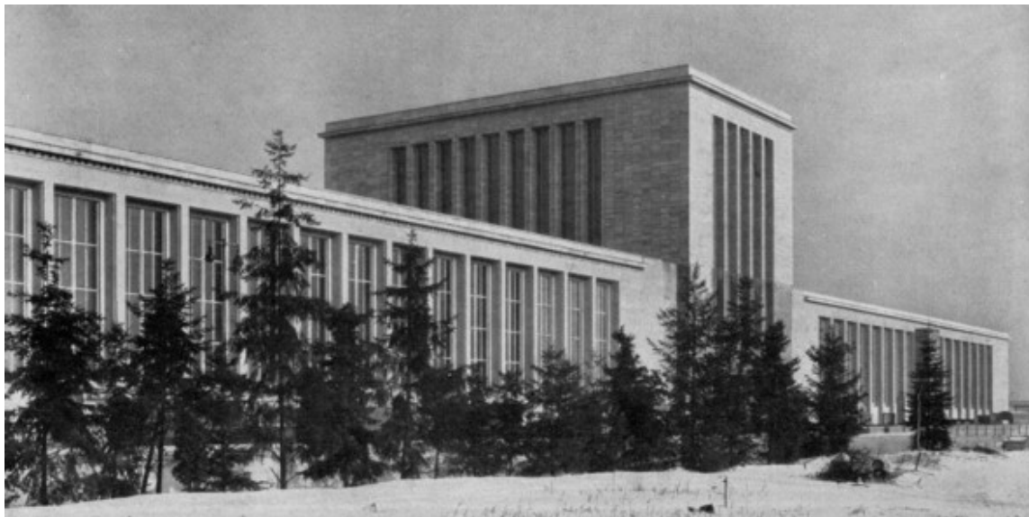
Abb. 439: Ausstellungshalle am Kaiserdamm in Berlin, vor 1938 – Architekt: Richard Emmerich
