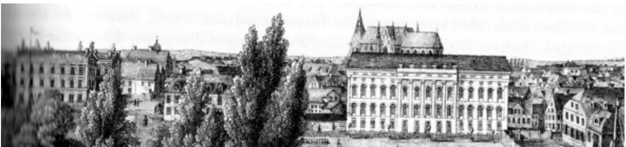
Abb. 14: Die ruhende Palaisbaustelle am Schweriner Alten Garten, Lithographie, 1844
