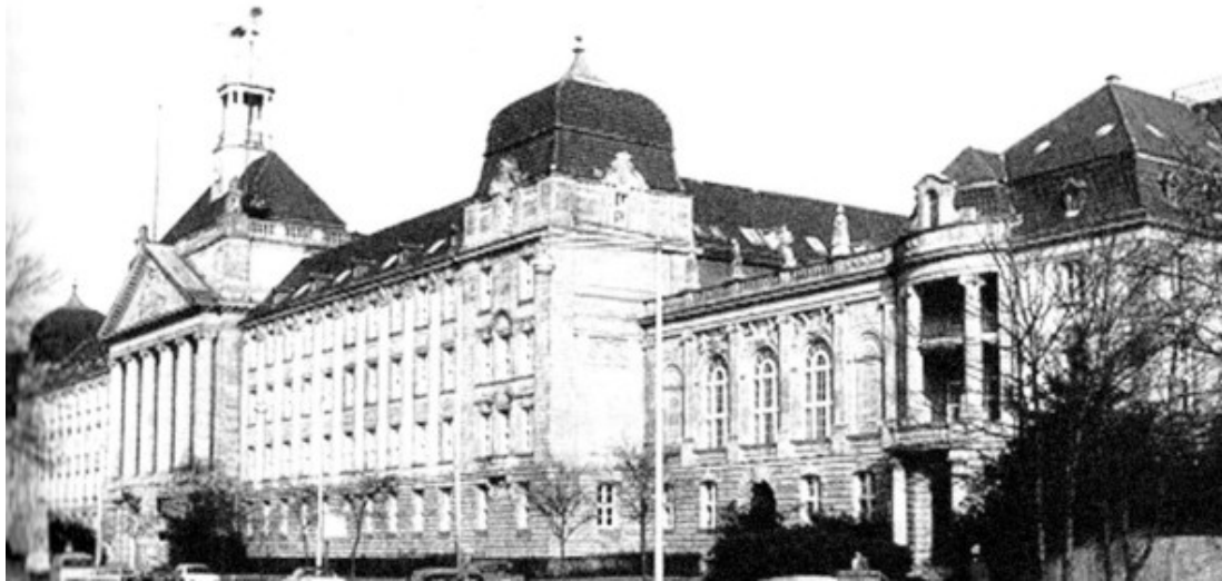
Abb. 23: Ministerium für öffentliche Arbeiten, erbaut 1907-11 in Düsseldorf – Architekten: Regierungsbauräte von Saltzwedel und Endell
