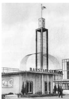
Abb. 407: Baustahl-gewebehalle – Arch.: Emil Fahrenkamp
