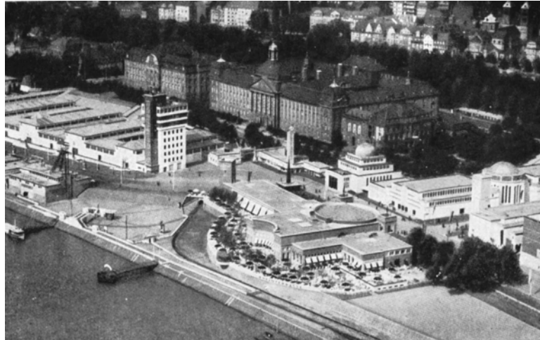
Abb. 376: Rheinterrasse, 1925/ 26, Rhein-Sicht - Architekt: Wilhelm Kreis
