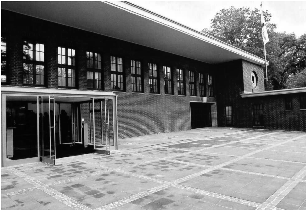
Abb. 442: Nach dem Umbau: Die >Denkfabrik< des Kosmetikunternehmensbereiches Schwarzkopf & Henkel in den Räumen der früheren Auto- bzw. Gefolgschaftshalle der Press- und Walzwerk AG (Mannesmann), Ansicht Henkelstraße.
