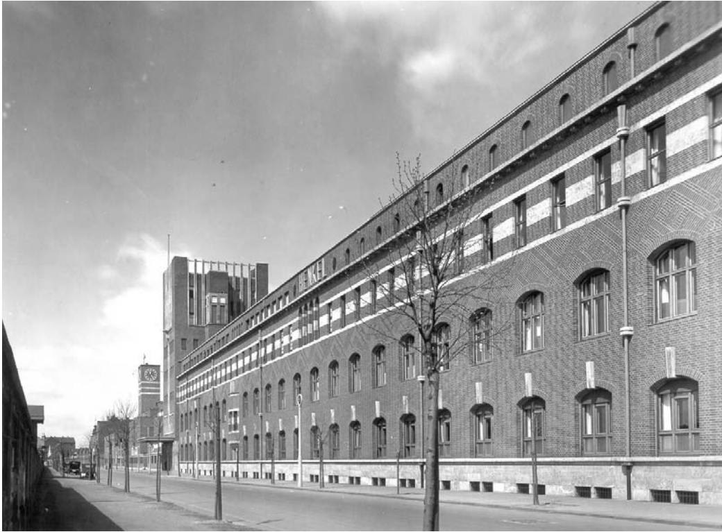
Abb. 78: Verwaltungsbau - straßenseitige Ansicht nach Überformung der Straßenfront, o. J. – Architekt: Walter Furthmann
