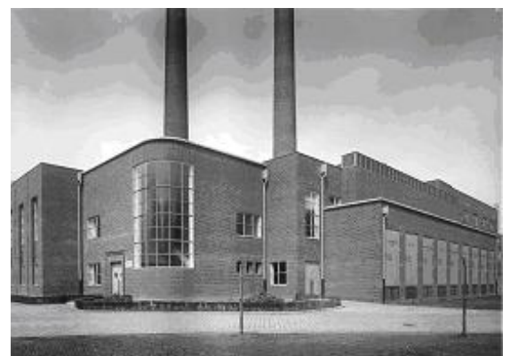
Schaltstation von 1931 - Vorderbau
