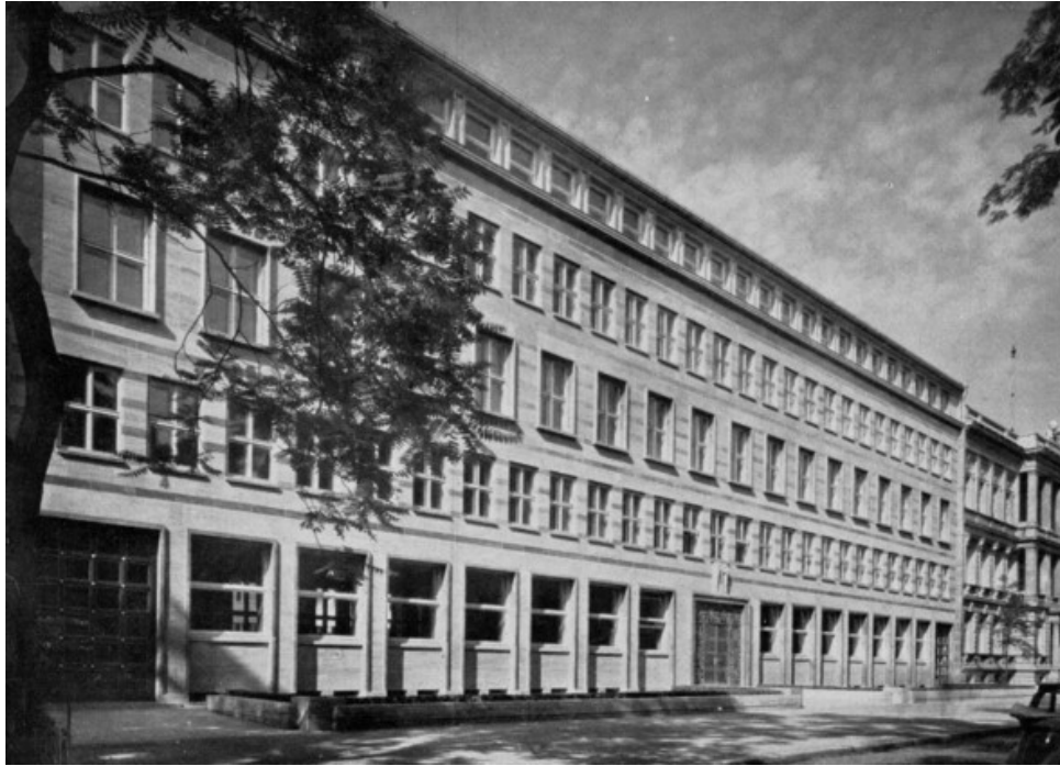
Abb. 438: Verwaltungsbau der Brandenburgischen Feuersozietät, Berlin, vor 1938 – Architekten: Paul Emmerich und Paul Mebes
