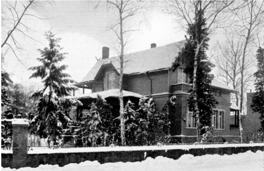
Abb. 73: Genthin: Beamtenwohnhaus, Aufnahme vor 1926
