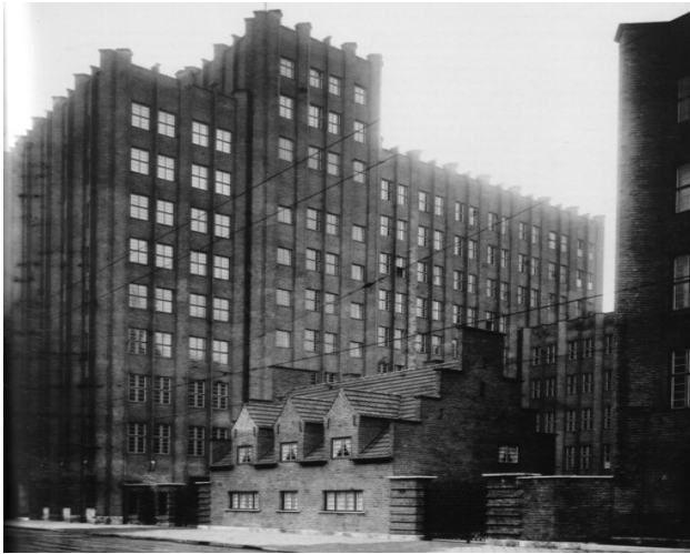
Düsseldorf: Verwaltungsgebäude und Pförtnerhaus des Stumm-Konzerns von 1922/ 24 – Architekt: Paul Bonatz
