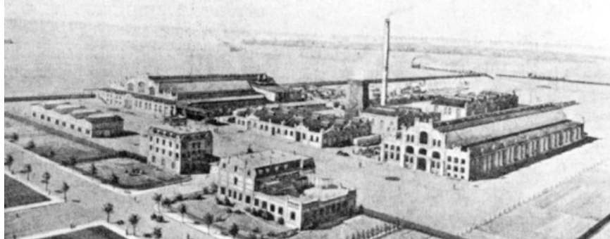
Abb. 139: Maschinenfabrik Louis Soest & Co, um 1901/ 02 – Architekt: H. Salzmann
