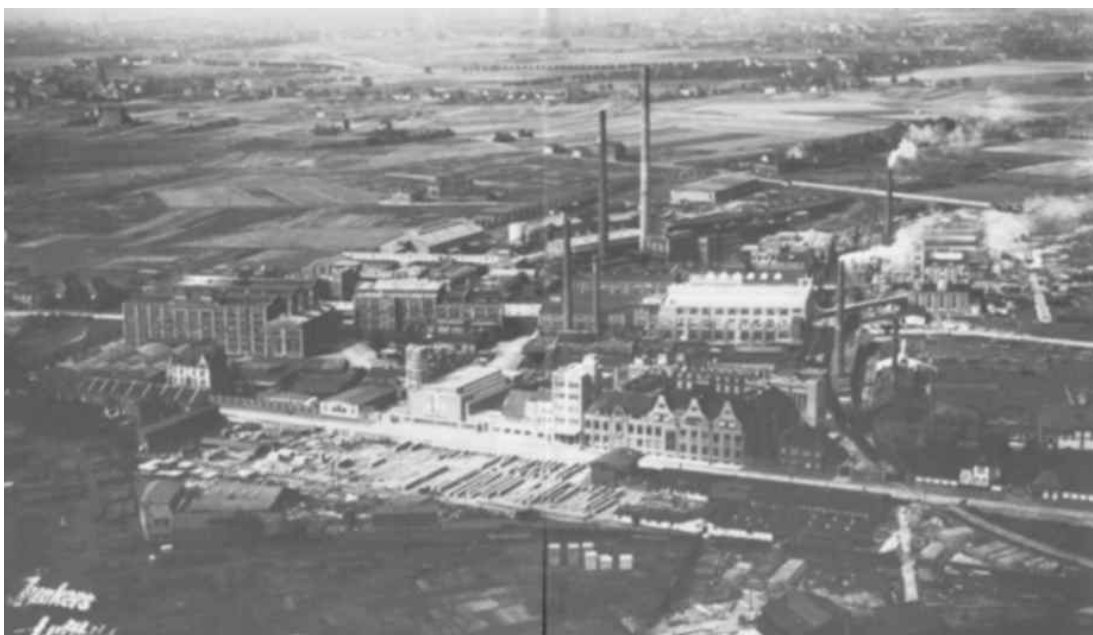
Abb. 242: Luftbild: HENKEL-Werksgelände in Düsseldorf-Holthausen, 1927 (erste Luftbildaufnahme)
