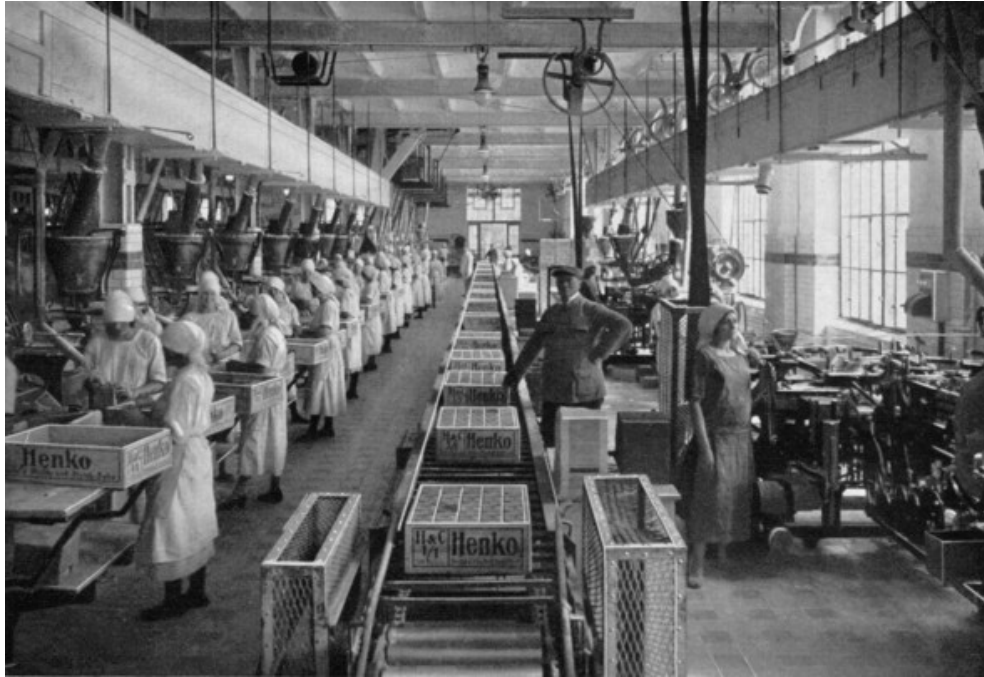
Abb. 254: HENKEL-Werk in Düsseldorf, Teilausschnitt des Packereiinnenraumes mit entsprechenden Arbeitsgängen, Aufnahme zwanziger Jahre – Architekt: Walter Furthmann
