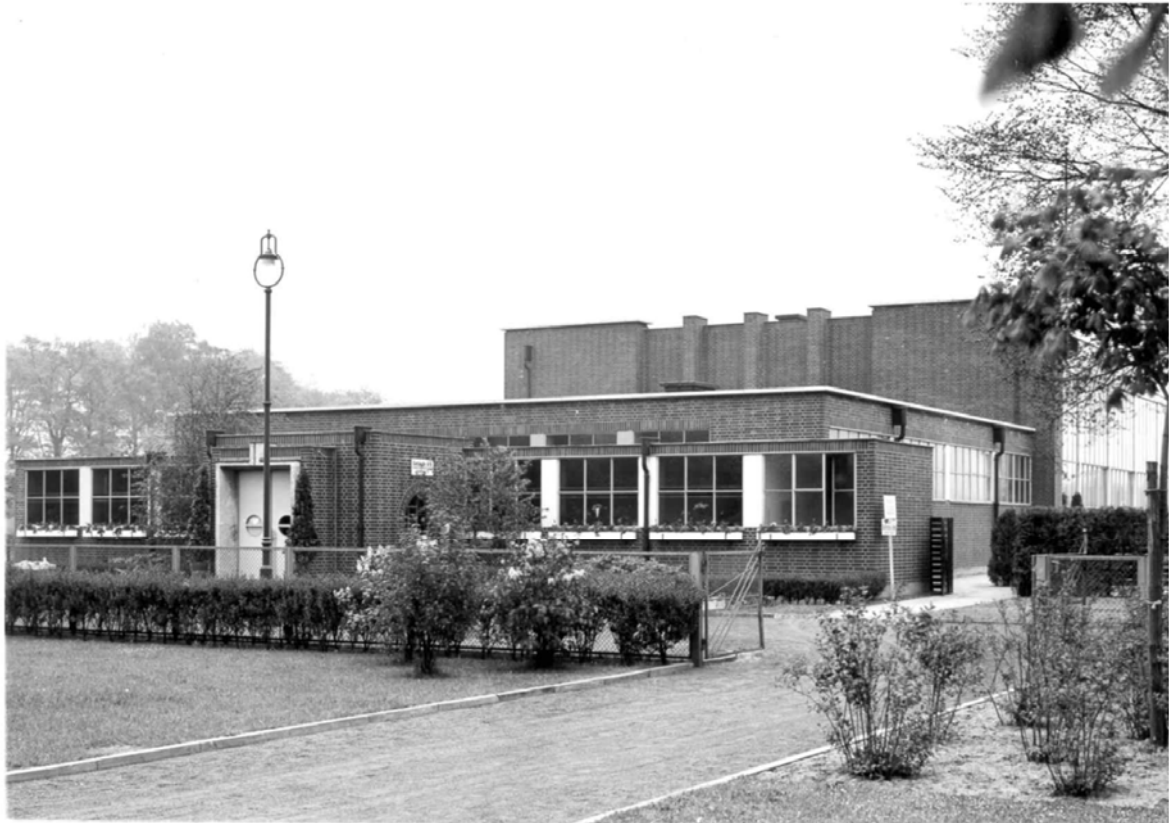
Abb. 342: HENKEL-Schwimmbad von 1930, Eingangsbereich – Architekt: Walter Furthmann
