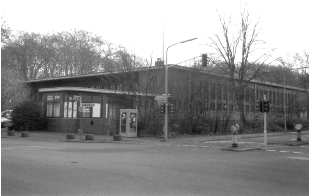
Abb. 440: Halle für Automobile, Fahrräder und Betriebsversammlungen (Gefolgschaftshalle) von 1939 vor dem Umbau in den neunziger Jahren, Ansicht Henkelstr./ Paul-Thomas-Str. – Architekt: Walter Furthmann
