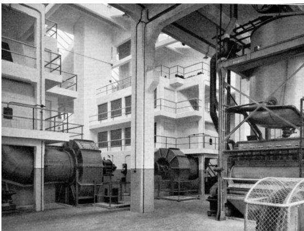
Abb. 25: Zerstäubungsanlage (Teilansicht) und Zerstäubungstürme (rechts), Aufnahmen vor 1926
