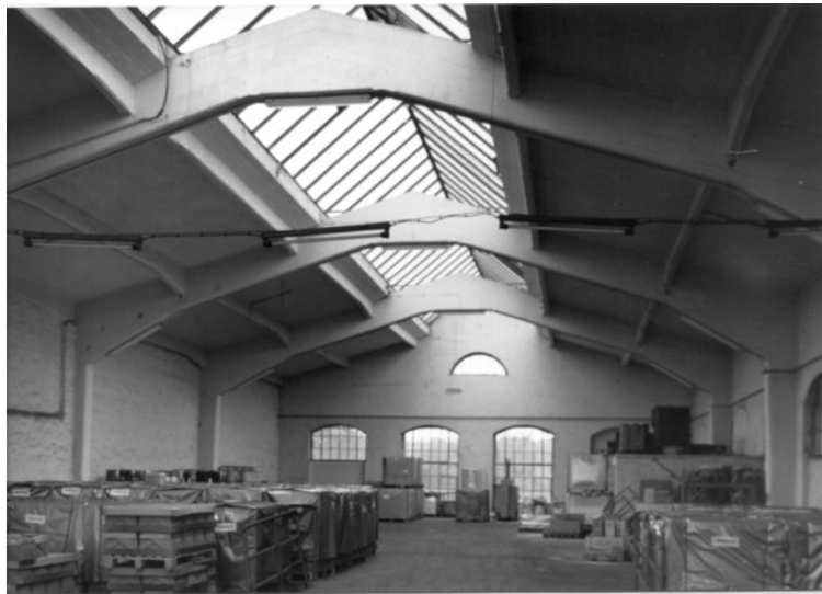
Abb. 111: Ölabfüllhalle der Mineralölwerke Rhenania GmbH in Monheim (Aufnahme in 1994) – Architekt: Walter Furthmann; Quelle: RhAD, Fotoarchiv Prof. Dr. Buschmann.
