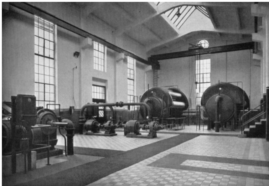
Abb. 245: Innenansicht des Maschinenhauses Geb. E 07 von 1920 - Architekt: Walter Furthmann
