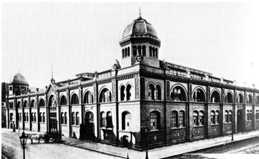
Abb. 44: Zentralmarkthalle von 1883-86 in Berlin nahe Bahnhof Alexanderplatz (Innere Tragkonstruktion: Eisenkonstruktion mit weit gespannten Fachwerkbindern) - Architekt: Hermann Blankenstein
