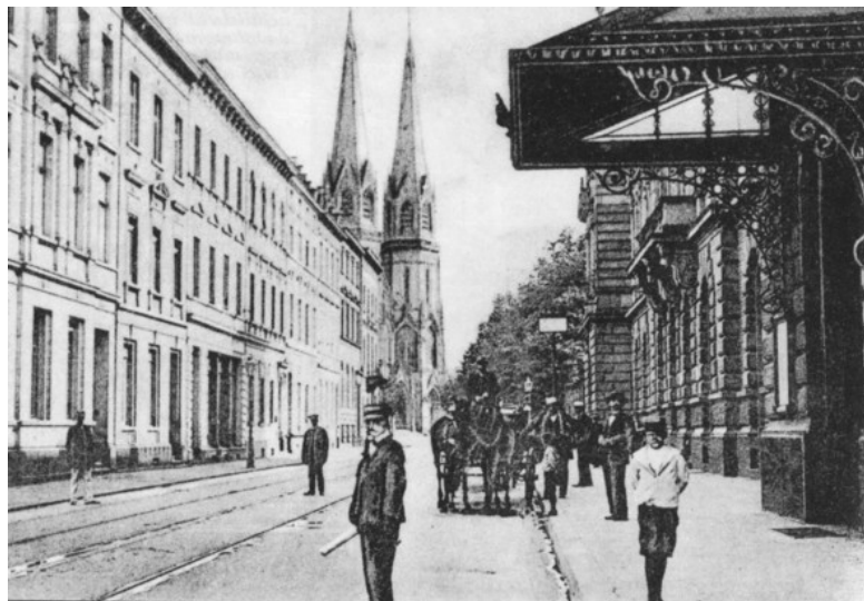
Abb. 7: Bebauung in der Tonhallenstraße in Düsseldorf
