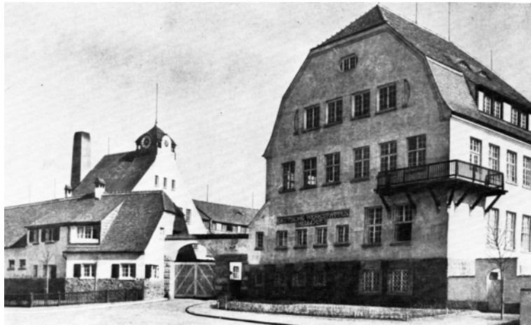
Abb. 164: Möbelfabrik für die Deutschen Werkstätten mit hohen Mansard- und Krüppelwalmdächern in Anlehnung an die Architekturforderung des Deutschen Heimatbundes, dem landschaftsbezogenen, heimatlich prägenden Bauen mit Entlehnung der Bau- und Dachformen aus dem Wohnungsbau - Architekt: Richard Riemerschmid
