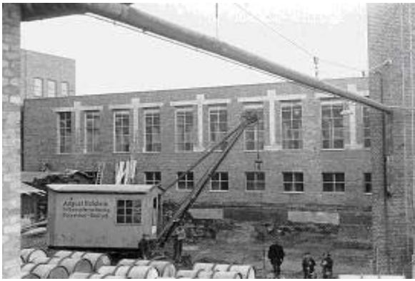
rückwärtiger Bereich, Bauphase
