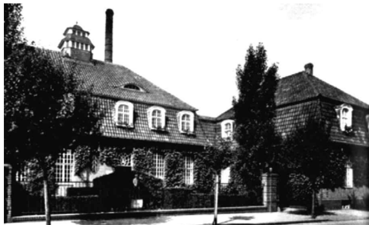
Abb. 86: Hauptverwaltung der Paul-Spindler-Werke an der Klotzstraße in Hilden von 1910
