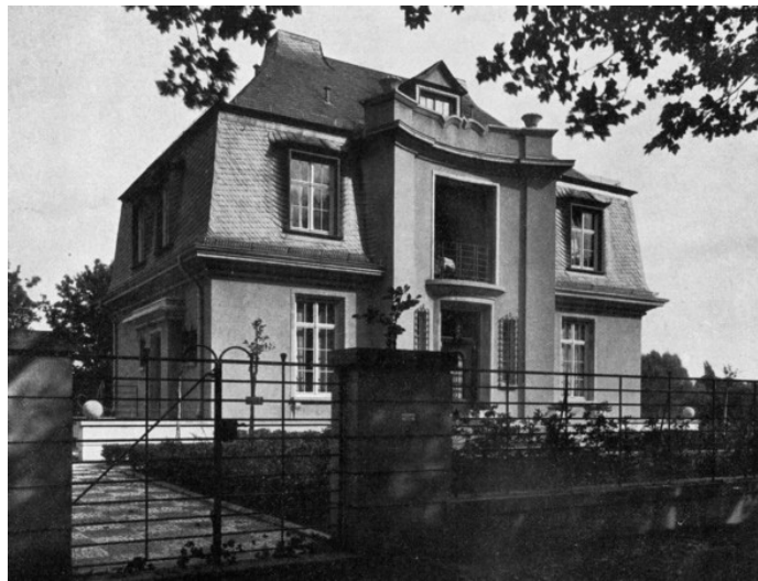
Abb. 364: Wohnhaus Schlegelsberg in Homburg v. d. Höhe, vor 1927 – Arch.: Walter Furthmann
