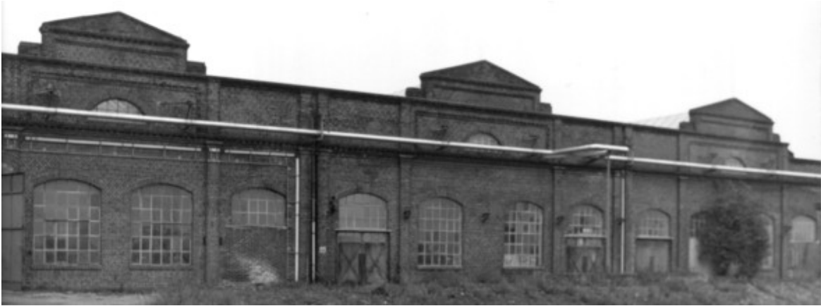
Abb. 110: Ölabfüllhalle der Mineralölwerke Rhenania GmbH in Monheim (Aufnahme in 1994) – Architekt: Walter Furthmann
