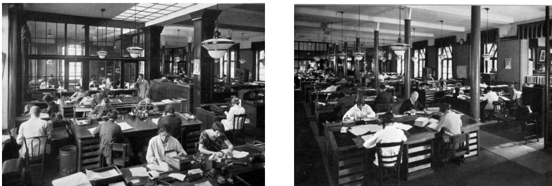
Abb. 17: Verwaltungsbau - Innenräume des Hauptbüros, o. J.
