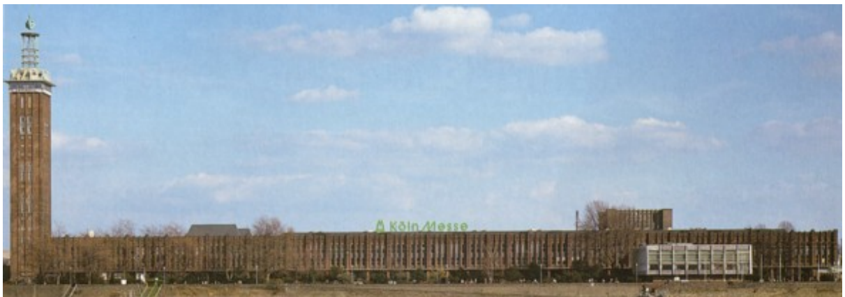
Abb. 86: Rheinansicht der Kölner Messe, errichtet zur Pressa 1928 – Architekt: Adolf Abel
