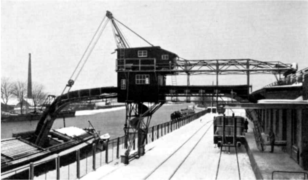
Abb. 20: Schiffs-Verladeanlage am Packerei- und Versandgebäude von 1923
