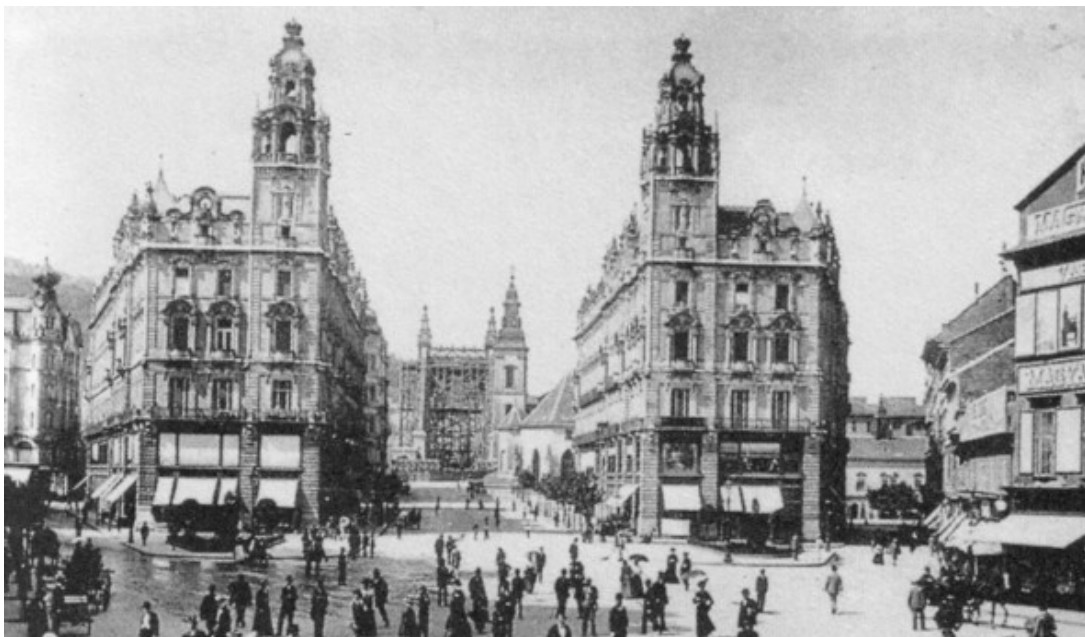
Abb. 36: Budapest: Die Zwillingspalais der Erzherzogin Klothilde, erbaut 1899-1901– Architekten: F. Korb und K. Giergl (im Hintergrund die im Bau befindliche Elisabethbrücke).
