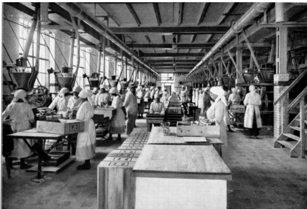
Abb. 253: HENKEL-Werk in Düsseldorf, Teilausschnitt des Packereinnenraumes mit entsprechenden Arbeitsgängen, Aufnahme zwanziger Jahre – Architekt: Walter Furthmann
