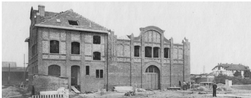
Abb. 148: Neubau der Gesellschaft für Linde's Eismaschinen A.-G. (Bau im Vordergrund)
