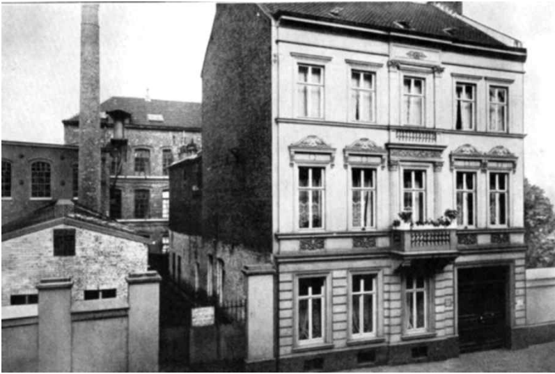
Abb. 49: Kontor- und Fabrikgebäude in Aachen, 1876
