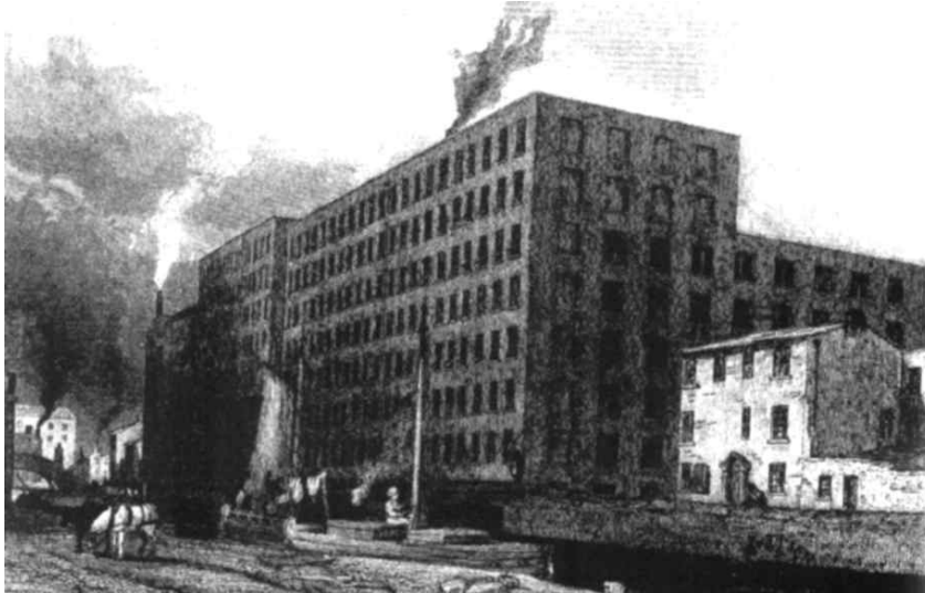
Abb. 128: Baumwollfabriken von Murray und Mc. Connel in Manchester, Union Street, Stahlstich 1829
