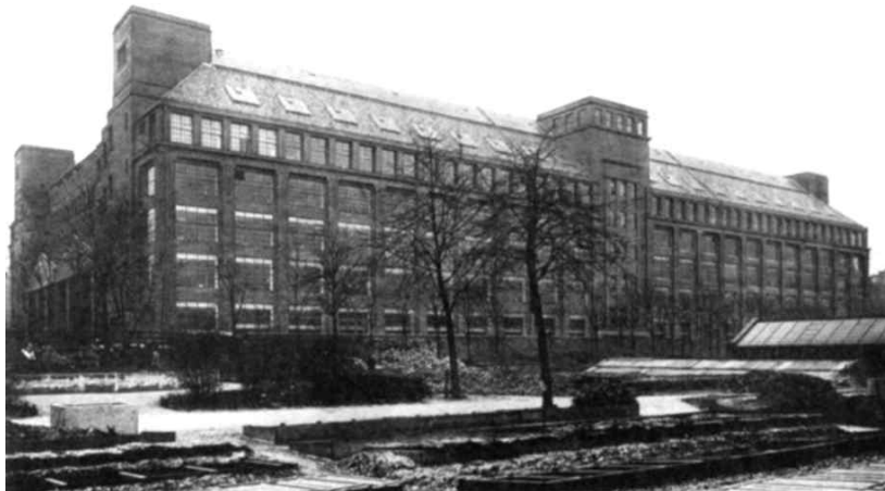
Abb. 80: Nord-Ostfront der Hochspannungsfabrik der AEG von 1910 in Berlin – Architekt: Peter Behrens
