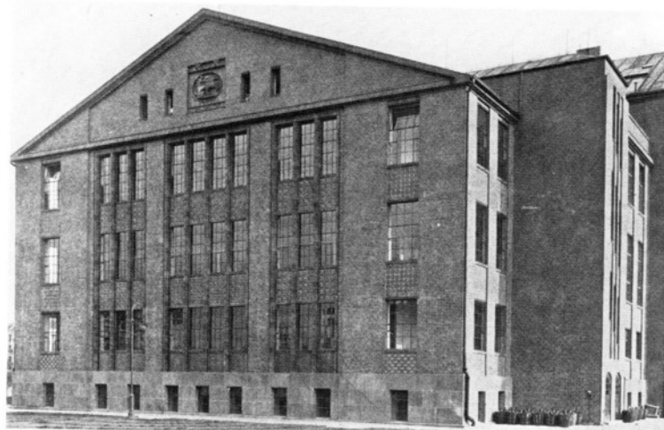
Abb. 227: Nord-Ostfront der Hochspannungsfabrik der AEG von 1910 in Berlin – Architekt: Peter Behrens
