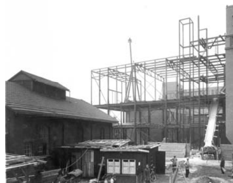
Blickrichtung zur Stahlskelettkonstruktion des Baus von 1936 mit Angrenzung an den Treppen Kubus von 1926 (rechts im Bild)
