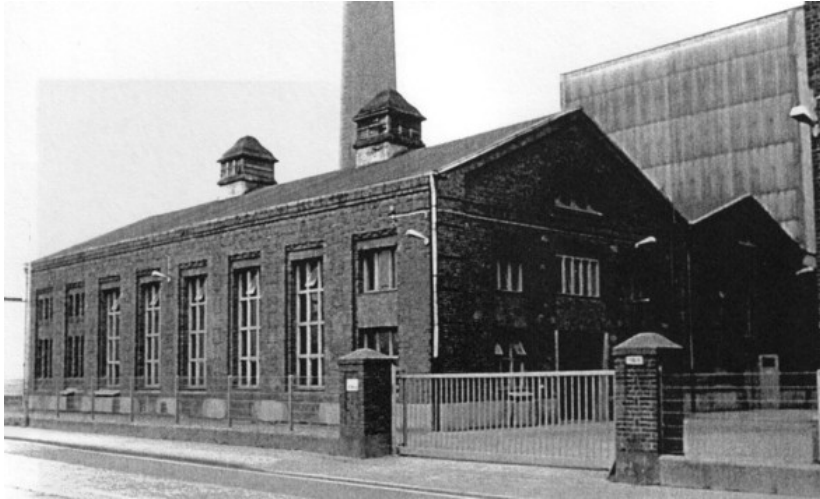
Abb. 240: Kraftzentrale der GEG-Seifenfabrik in Düsseldorf von 1914 (Fotoaufnahme in 1994)
