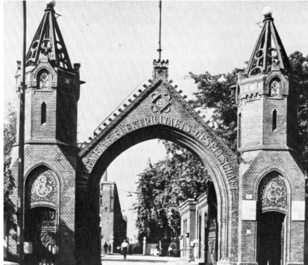
Abb. 159: Torhaus mit gotisierender Formenprägung des AEG-Fabrikkomplexes von 1897 in Berlin, Brunnenstraße - Architekt: Franz Schwechten
