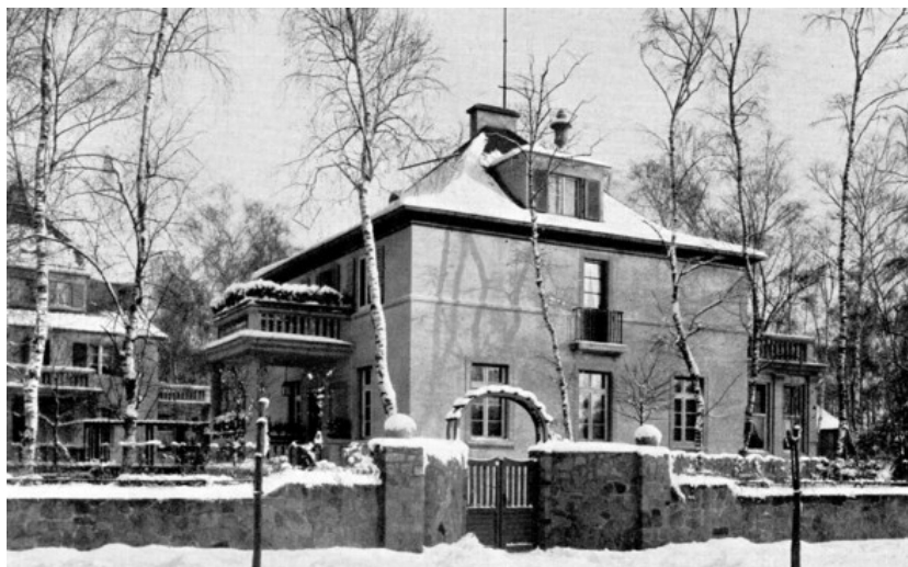
Abb. 71: Genthin: Beamtenwohnhaus, Aufnahme vor 1926
