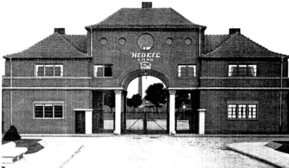
Abb. 27: Werkseingangsgebäude von 1923 – Architekt: Walter Furthmann
