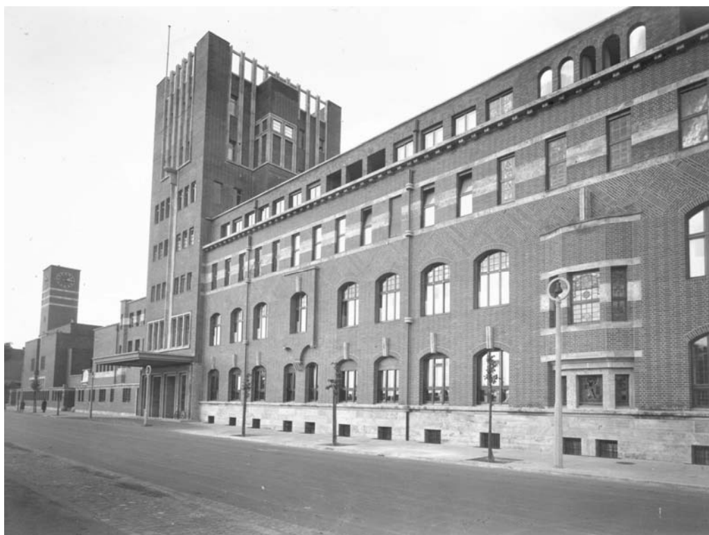
Abb. 77: Verwaltungsbau – straßenseitige Ansicht nach Überformung der Straßenfront, o. J. – Architekt: Walter Furthmann
