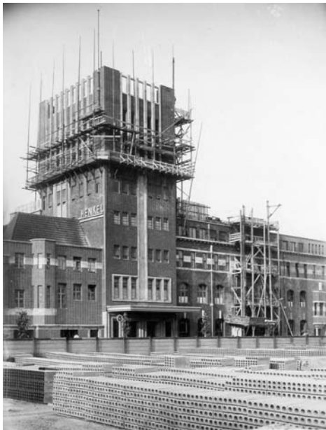
Abb. 65: Verwaltungsbau – Fertigstellung des Turmes und Überformung der straßenseitigen Fassadenfronten, Aufnahmen um 1929 – Architekt: Walter Furthmann
