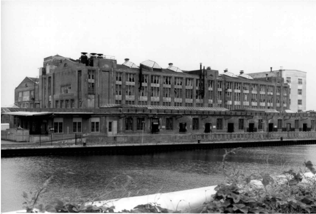
Abb. 46: Packerei- und Versandgebäude, Blickrichtung vom Plauer Kanal, Aufnahme um 1990
