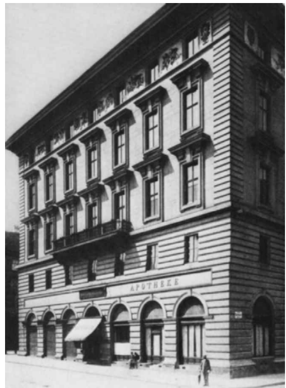
Wohn- u. Geschäftshaus, Rathaus-Str. 5, Wien, 1881
