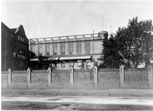
Abb. 36: Verwaltungsbau – Erweiterung von 1911 mit Sicht zum Speisesaal und Dachgarten - Architekt: Walter Furthmann
