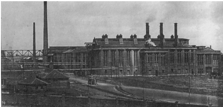
Abb. 275: Neues Kraftwerk im Mannesmann-Röhrenwerkes (Werk I) in Düsseldorf-Rath, 1924
