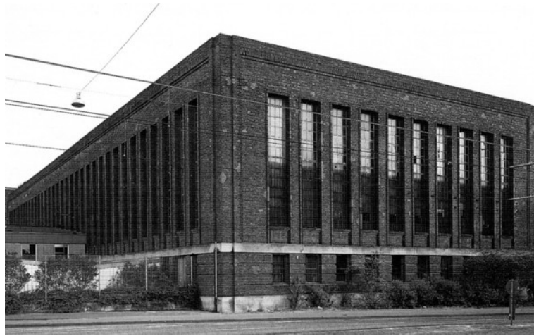
Abb. 84: Riemen- und Kolbenfabrik der ACLA-Treibriemenwerke in Köln von 1921/ 22 - Architekten: Erberich & Scheeben
