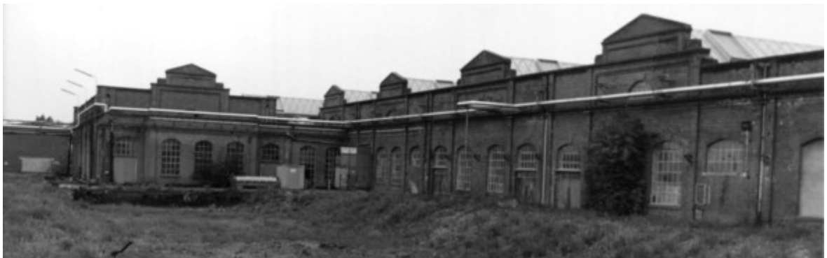
Abb. 109: Ölabfüllhalle der Mineralölwerke Rhenania GmbH in Monheim (Aufnahme in 1994) – Architekt: Walter Furthmann
