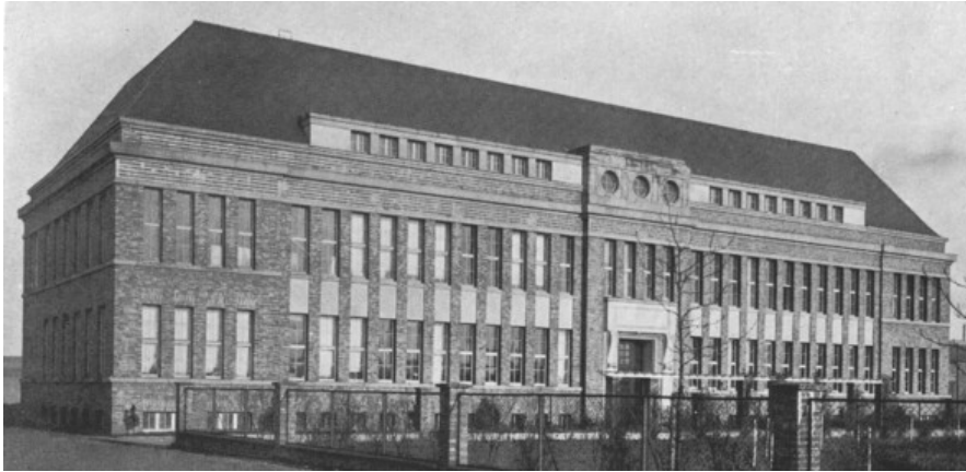
Abb. 235: Verwaltungsgebäude der Gebrüder Schöndorff-Aktiengesellschaft in Düsseldorf, 1919/1920 – Architekt: Wilhelm Pütz, Düsseldorf
