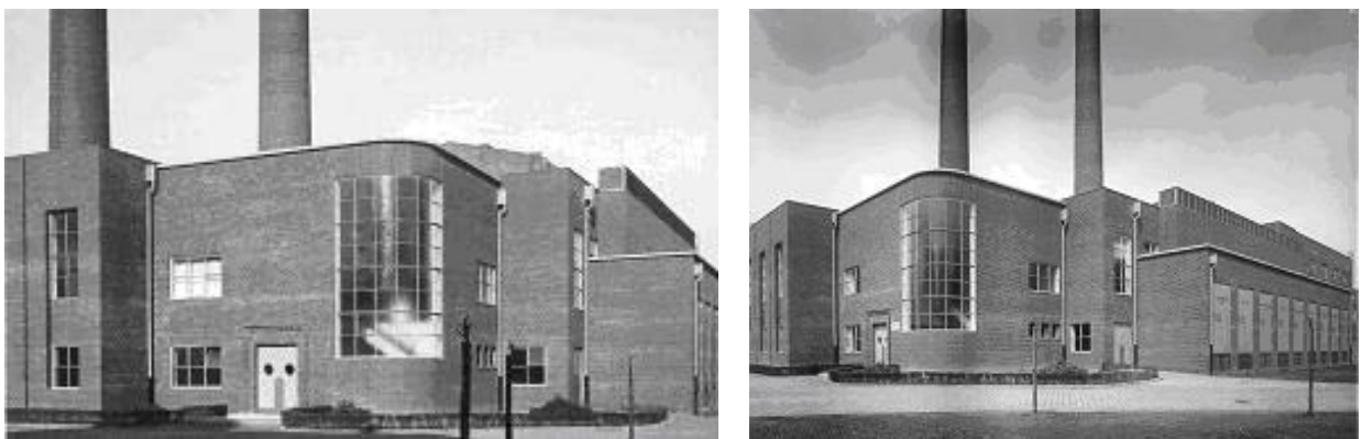
Abb. 318: HENKEL-Schaltstation Geb. F 03 von 1931 in Düsseldorf - Architekt: Walter Furthmann
