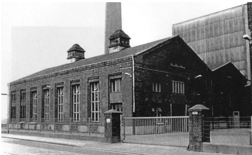
Abb. 83: Kraftzentrale der GEG-Seifenfabrik in Düsseldorf von 1914 (Fotoaufnahme in 1994)
