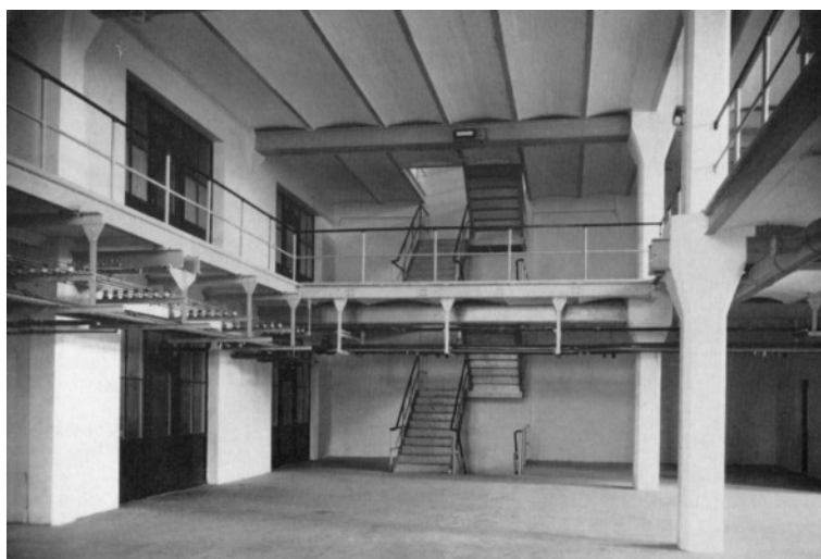
Abb. 301: HENKEL-Versuchsabteilung, Ausschnitt Innenraum des Technikums für großtechnische Versuche mit Deckendurchbruch vom 1. zum 2. Obergeschoss – Architekt: Walter Furthmann
