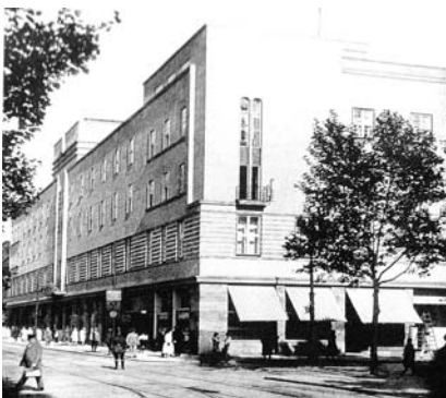
Abb. 397: Breidenbacher Hof – Fassade Th.-Körner-Str., 1928 – Architekt: Emil Fahrenkamp
