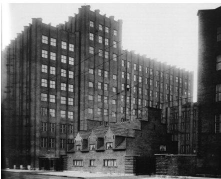
Verwaltungsgebäude und Pflörtnerhaus
