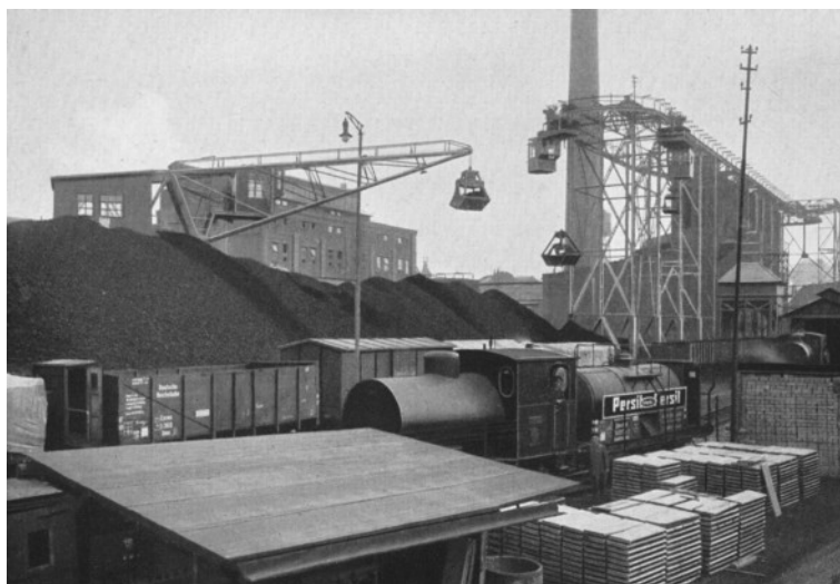
Abb. 189: Kesselhaus mit Bekohlungsanlage Geb. F 02, vor 1926 - Architekt: Walter Furthmann
