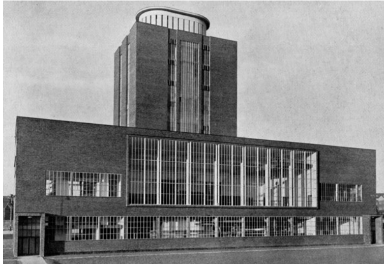
Abb. 323: Y-Kraftwerk (Schornsteinloses Kraftwerk) für den Bayer-Konzern in Leverkusen von 1935, entworfen vom Architekten Emil Fahrenkamp und Ingenieur Karl Hencky.
