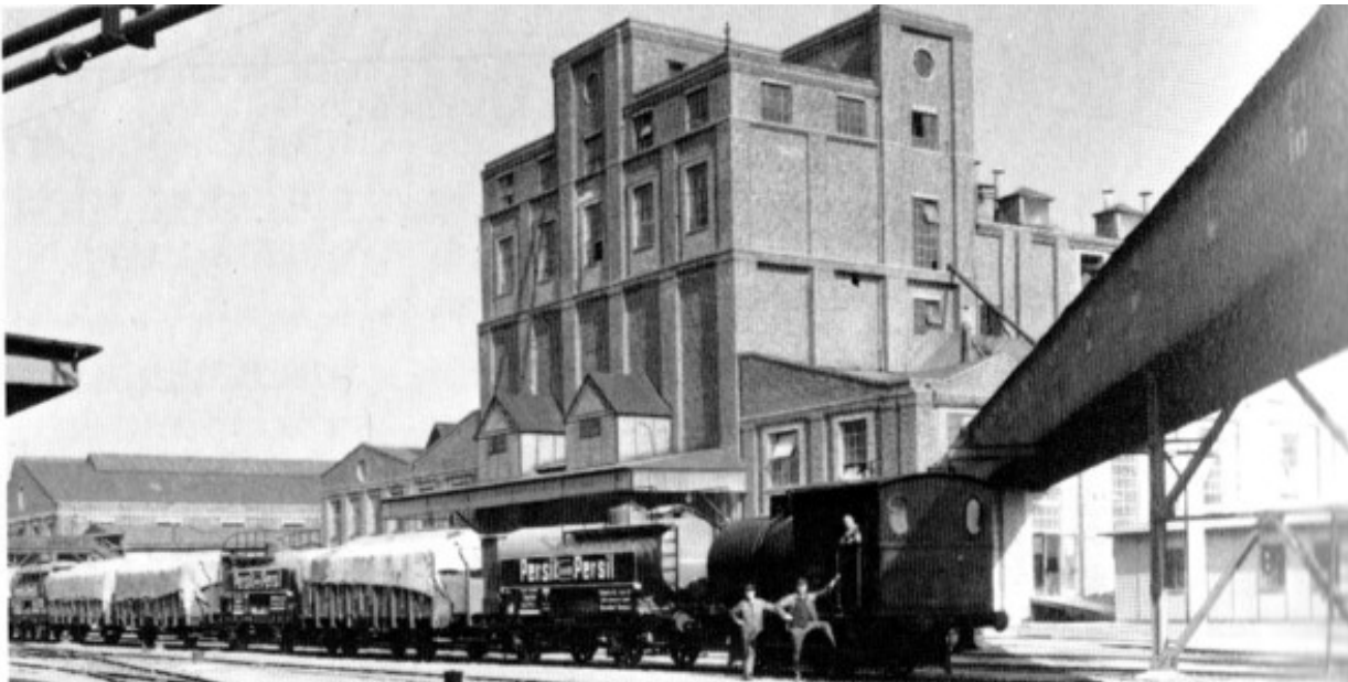
Abb. 243: Trocken- bzw. Zerstäubungsanlage mit Maschinenhaus Geb. E 07, um 1920 - Architekt: Walter Furthmann
