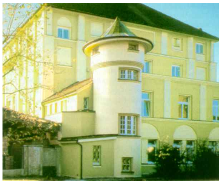
Abb. 3: Restaurierter und überformter Verwaltungstrakt mit Fabrikgebäude in Putzausführung, Aufnahme um 1986
