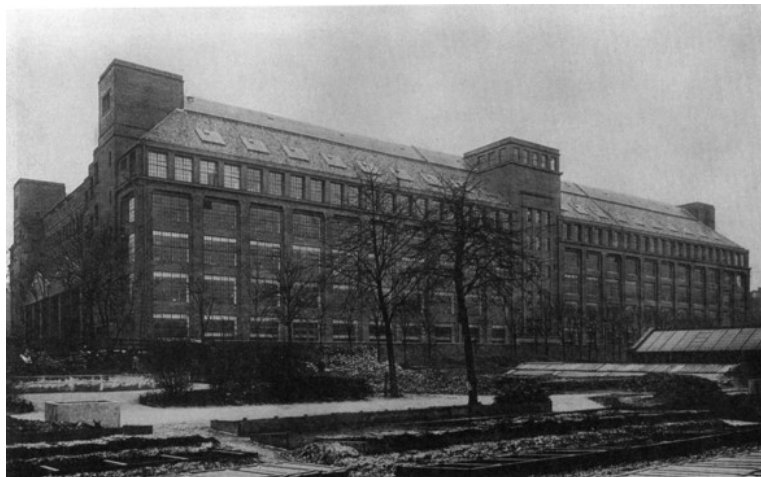
Abb. 226: Nord-Ostfront der Hochspannungsfabrik der AEG von 1910 in Berlin – Architekt: Peter Behrens
