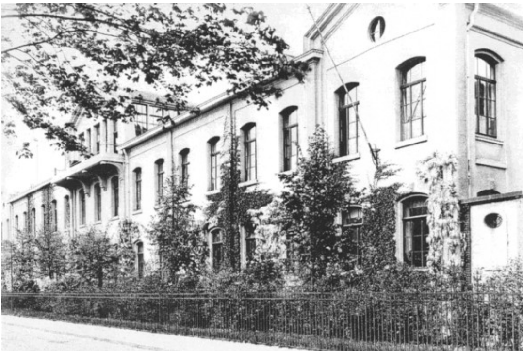
Abb. 48: BAYER-Verwaltung nach Aufstockung und Verputzung in 1913, Umplanung erfolgte durch die Bauabteilung im BAYER-Konzern
