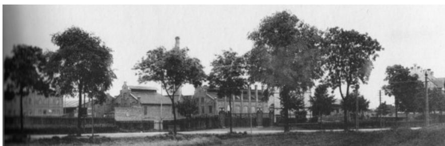
Abb. 137: Waggonfabrik des Düsseldorfer Eisenbahnbedarf vorm. C. Weyer & Co., 1907
