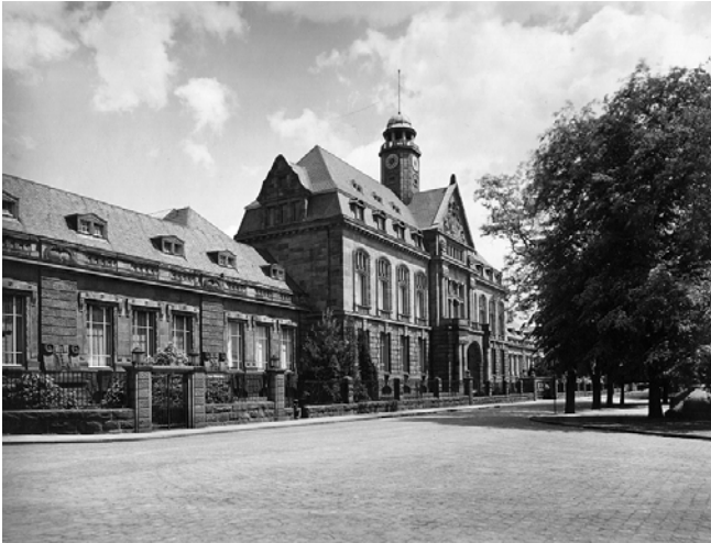
Abb. 49: Hauptverwaltungsgebäude des BAYER-Konzerns, Bau von 1912/13
