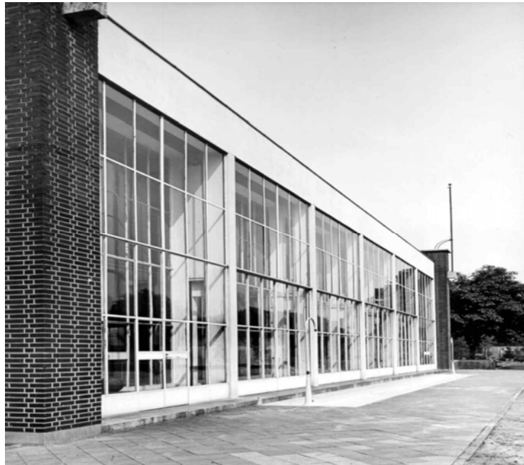
Abb. 343: HENKEL-Schwimmbad von 1930, südliche Glaswand – Architekt: Walter Furthmann
