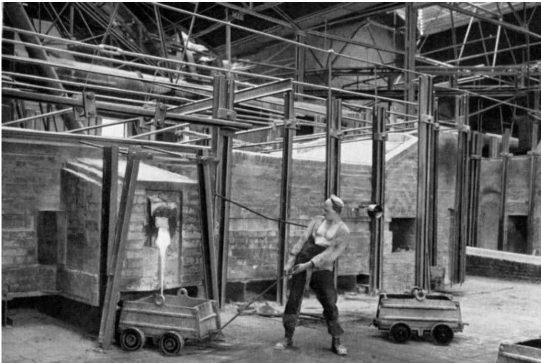
Abb. 204: Wasserglasofen innerhalb der Wasserglasfabrik mit Auslauf des geschmolzenen Glases in eine eiserne Kokille zum Weitertransport des Wasserglases, Aufnahme in den zwanziger Jahren. (Aufgrund der seinerzeitigen mechanischen Betreibung war körperliche Schwerstarbeit vonnöten.)
