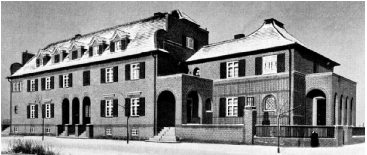
Abb. 57: HENKEL-Mehrfamilien-Arbeiterhaus an der Ziegeleistraße in Genthin (rechts: Einmündung in die Richard-Wagner-Straße), Aufnahme vor 1926
