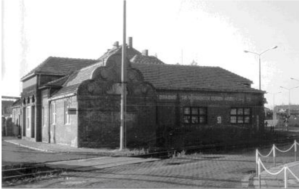
Abb. 29: Speisesaal von 1923 – Architekt: Walter Furthmann (Aufnahme: neunziger Jahre)
