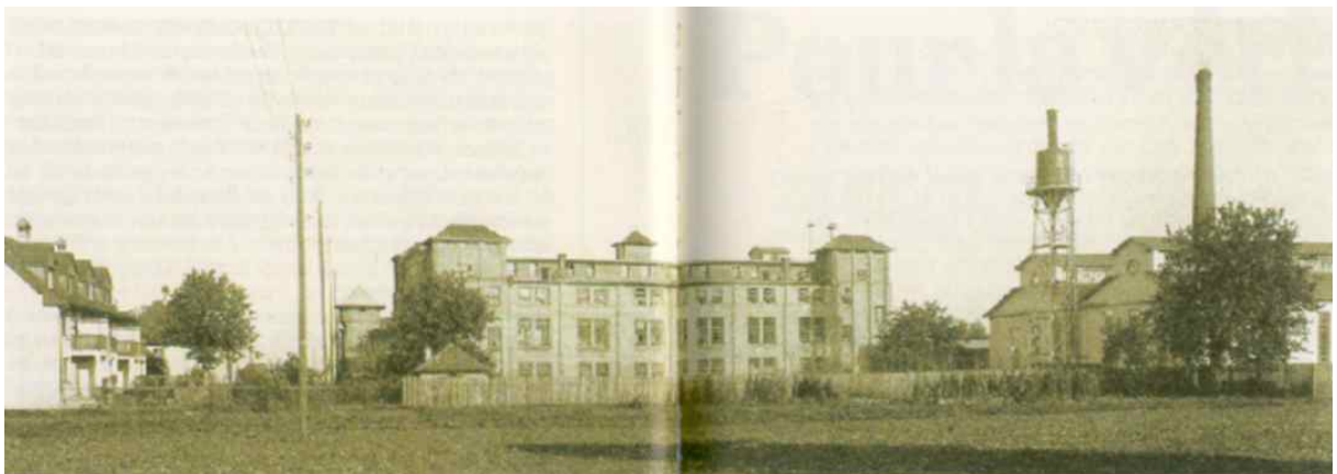
Abb. 2: HENKEL-Werk in Pratteln mit PERSIL-Fabrik und vorgelagertem Verwaltungstrakt in Bildmitte, Bau in Backsteinausführung von 1912/ 13 – Architekt: Walter Furthmann
