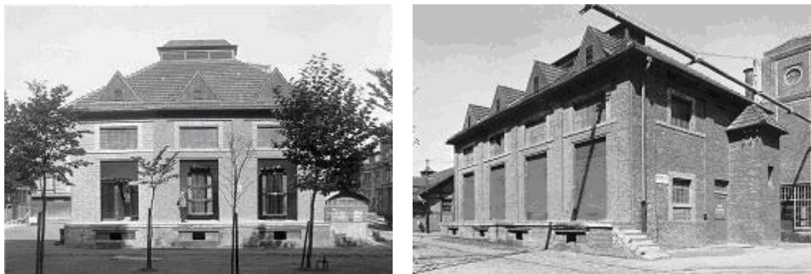
Abb. 217: Transformatorhaus nach mehrfachen Erweiterungen (linkes Bild: 1. Erweiterung; rechtes Bild: 2. Erweiterung, um 1930), Geb. D 02 – Architekt: Walter Furthmann
