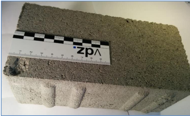
Abbildung 2: Betonpflasterstein 10x20x8 mit Fehlstelle im Vorsatzbeton an der Oberfläche.
