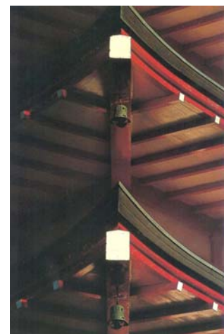
Abb. 36: Bemalte Dachkonstruktion, Japan.
