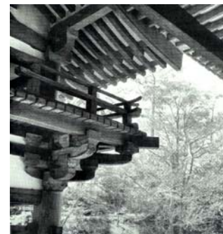
Abb. 35: Hôdô-dô (Phönix-Halle) des Byôdô-in-Tempel in Uji bei Kyôto. 10.-12. Jh. Auskragung an der Ecke des Umgangs.
