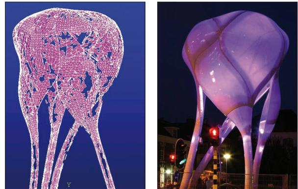
Abb. 24) D-Tower: Topologieoptimierung und umgesetzte Struktur. (Spuybroek, 1999)
