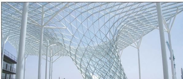
Abb. 18/19) Zwei Beispiel für Glasüberdachungen, die über Flächentriangulation erzeugt wurden. Oben: Atrium-Überdachung DG-Bank, Berlin (Gehry, 1997) sowie die Überdachung für die Mailänder Messe (Fuksas, 2004): Während sich die Glaskonstruktion des Gehry-Entwurfs selbst trägt, benötigt logo & vela eine Reihe von ‚Krücken‘ (zusätzliche Stützen).
