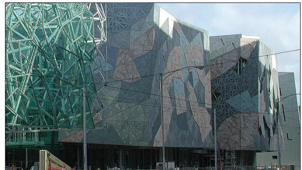
Abb. 20) Federation Square, Melbourne – eine Methode der Ebenenparkettierung als prägendes Element. (Lab Architects, 1997)
