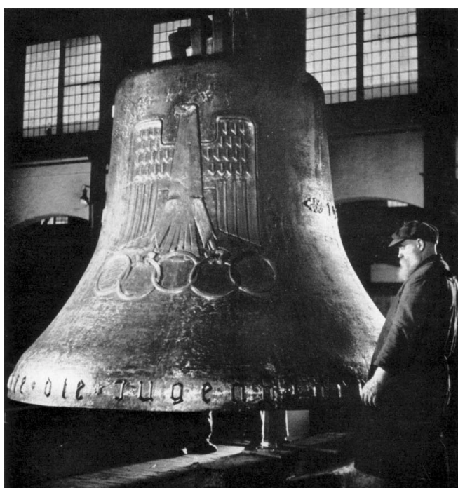
Erkalten lassen, putzen, ziselieren, abstimmen – die Olympia Glocke ist fertig 137
