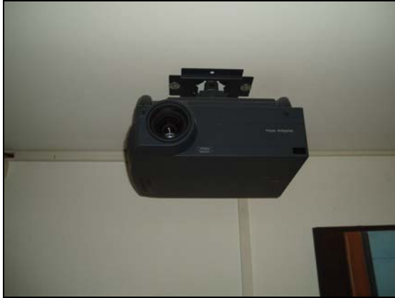
Abb. 8.24: Biemer-Projektor wurde an der Zimmerdecke installiert
