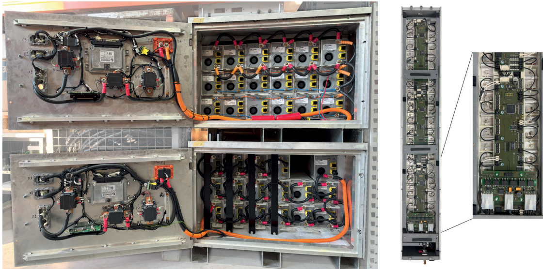
Abbildung 12.3: LTO-Batteriespeicher
