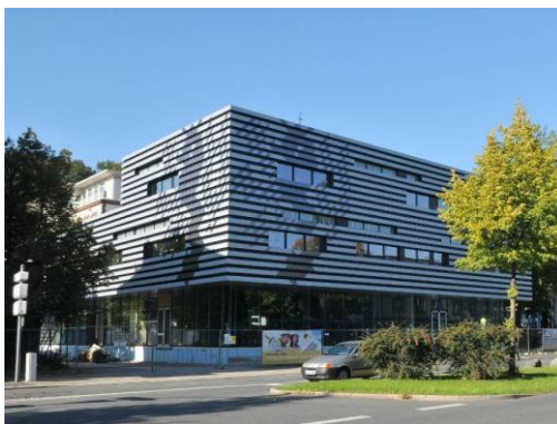
a) HC-Gebäude am Campus Haspel [212]
