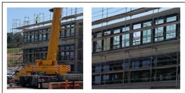
Abbildung 21: Einbau der Betonelemente Wand auf der Baustelle im Raum Stuttgart, eigene Aufnahme, Juli 2024
