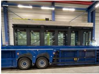
Abbildung 20: Versand von Betonwandelementen zur Baustelle, eigene Aufnahme, Hamm, Juli 2024
