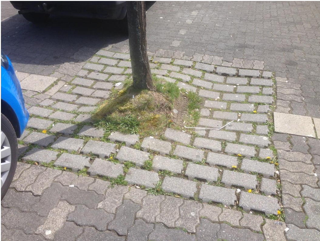
Bild 254: Befahrene und verformte Baumscheibe eines Jungbaumes
