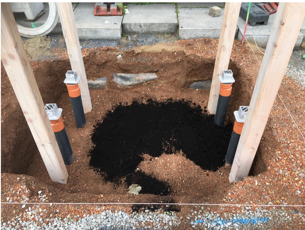
Bild 267: Einbringen eines Bodenhilfsstoffs auf der Pflanzlochsohle
