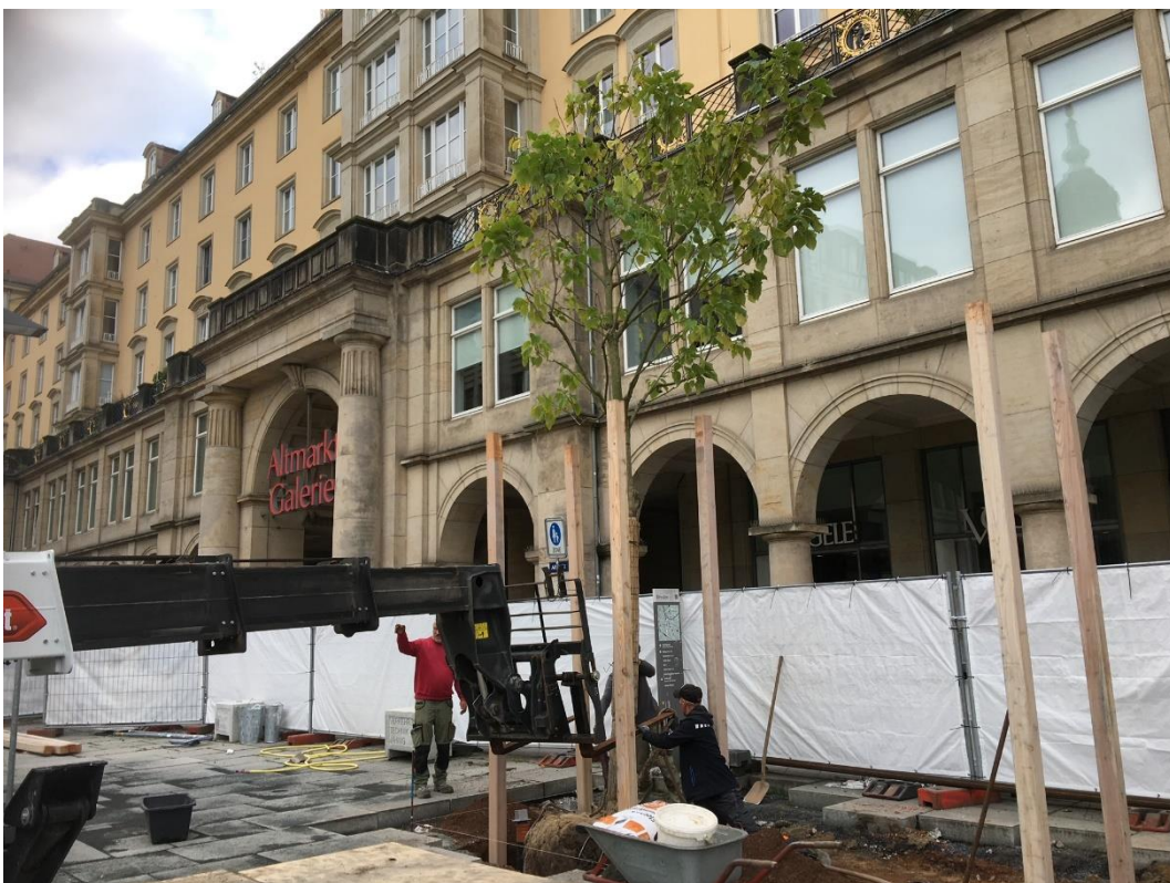
Bild 269: Mit dem Hebegerät in das Pflanzloch gesetzter Baum
