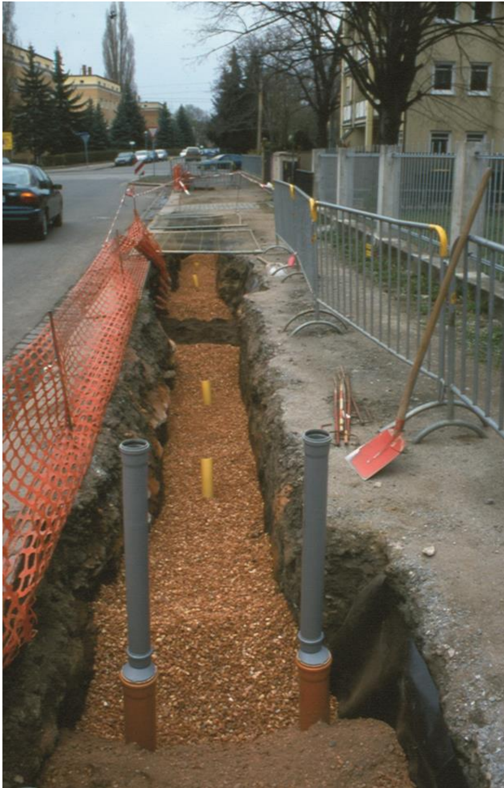
Bild 256: Dresden, Erprobung Dohnaer. Str. – Anlage des Belüftungsgrabens, 2002
