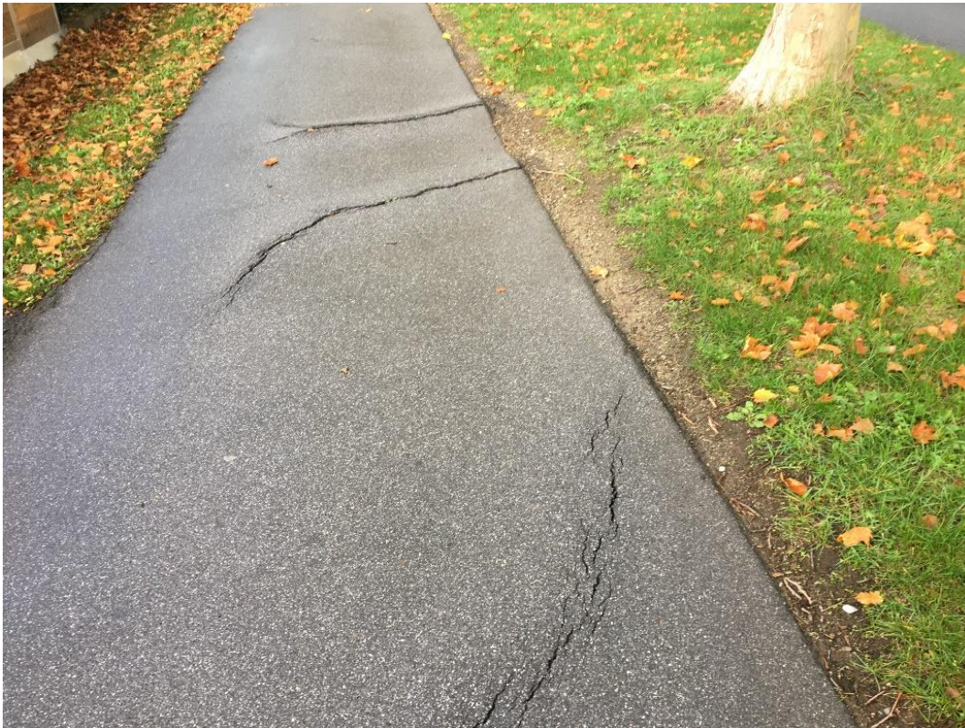
Bild 252: Wurzelwachstum innerhalb des Oberbaus eines Radweges mit Rissbildung
