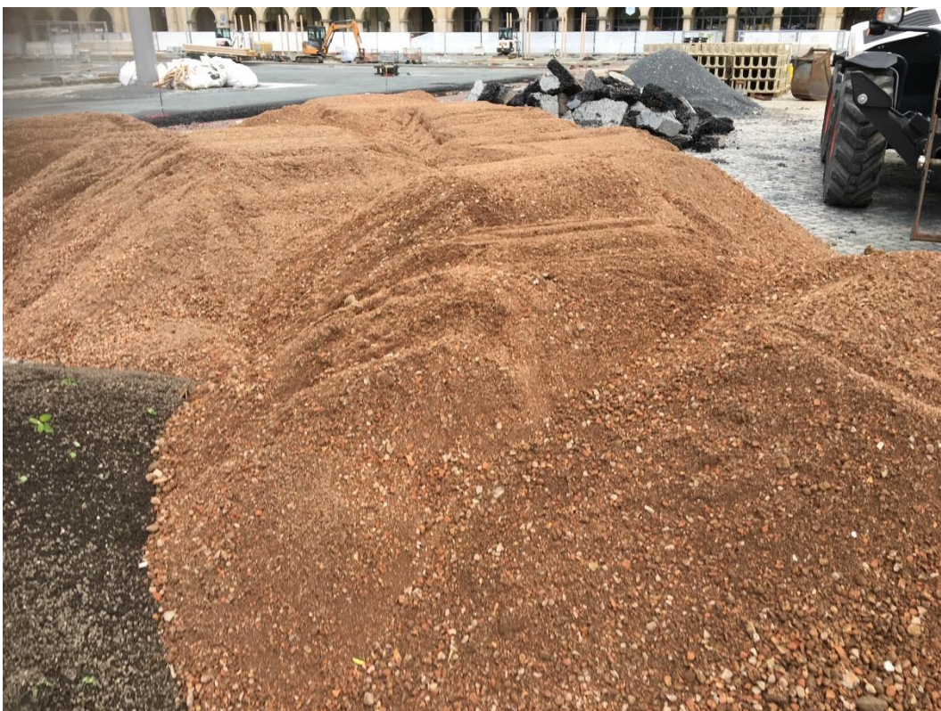
Bild 265: Entferntes Baums substrat aus der Pflanzgrube der Pflanzlöcher
