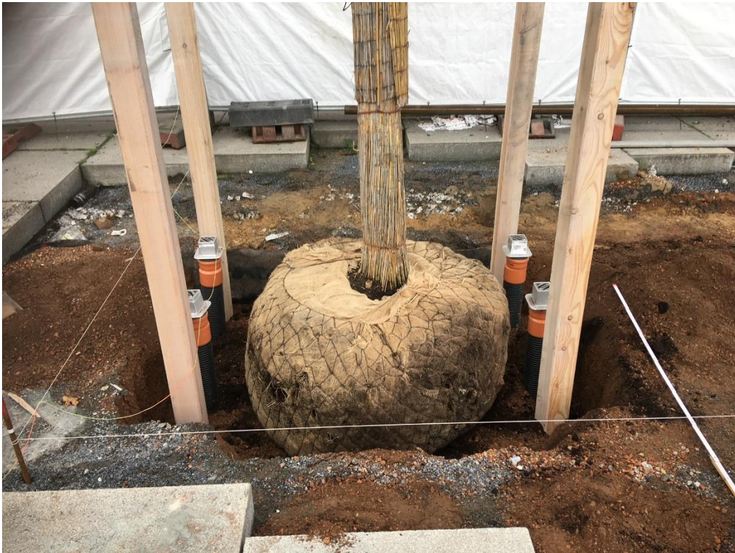
Bild 270: Baumballen im Pflanzloch in der Nähe der Belüfter und der Baumpfähle
