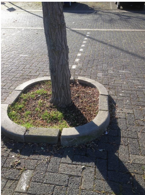
Bild 255: Aufklaffende Randeinfassung eines Baumes in einer Verkehrsfläche
