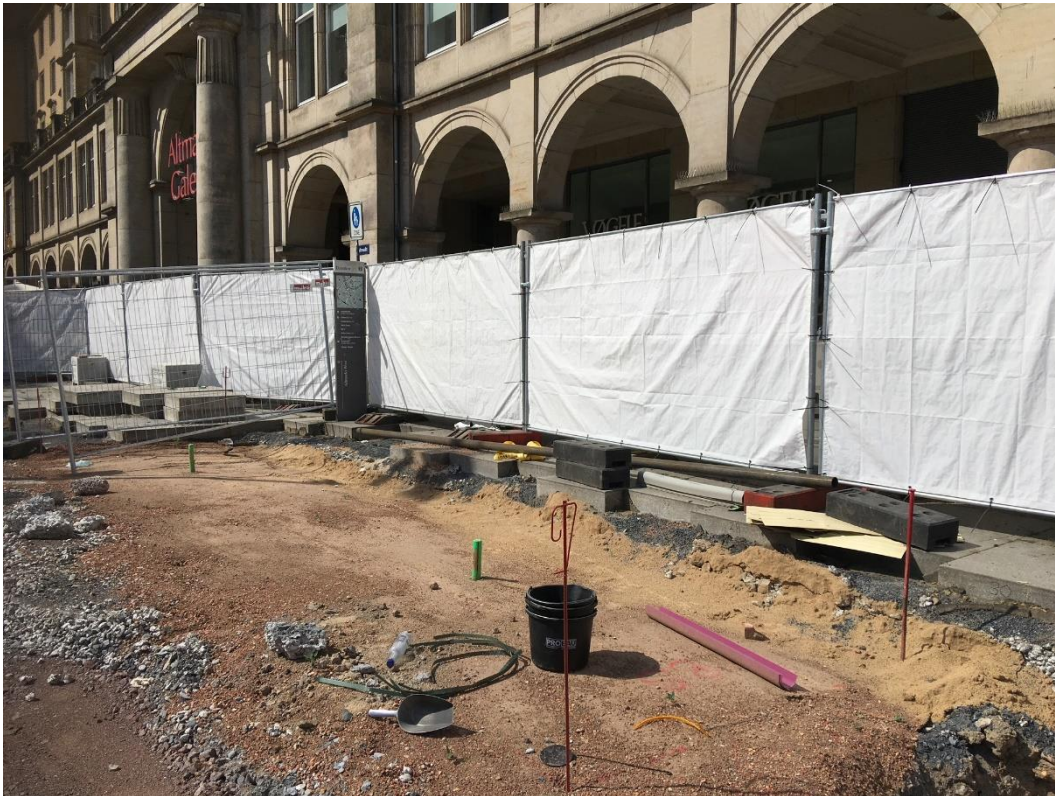
Bild 264: Verfüllte und verdichtete Baumgrube
