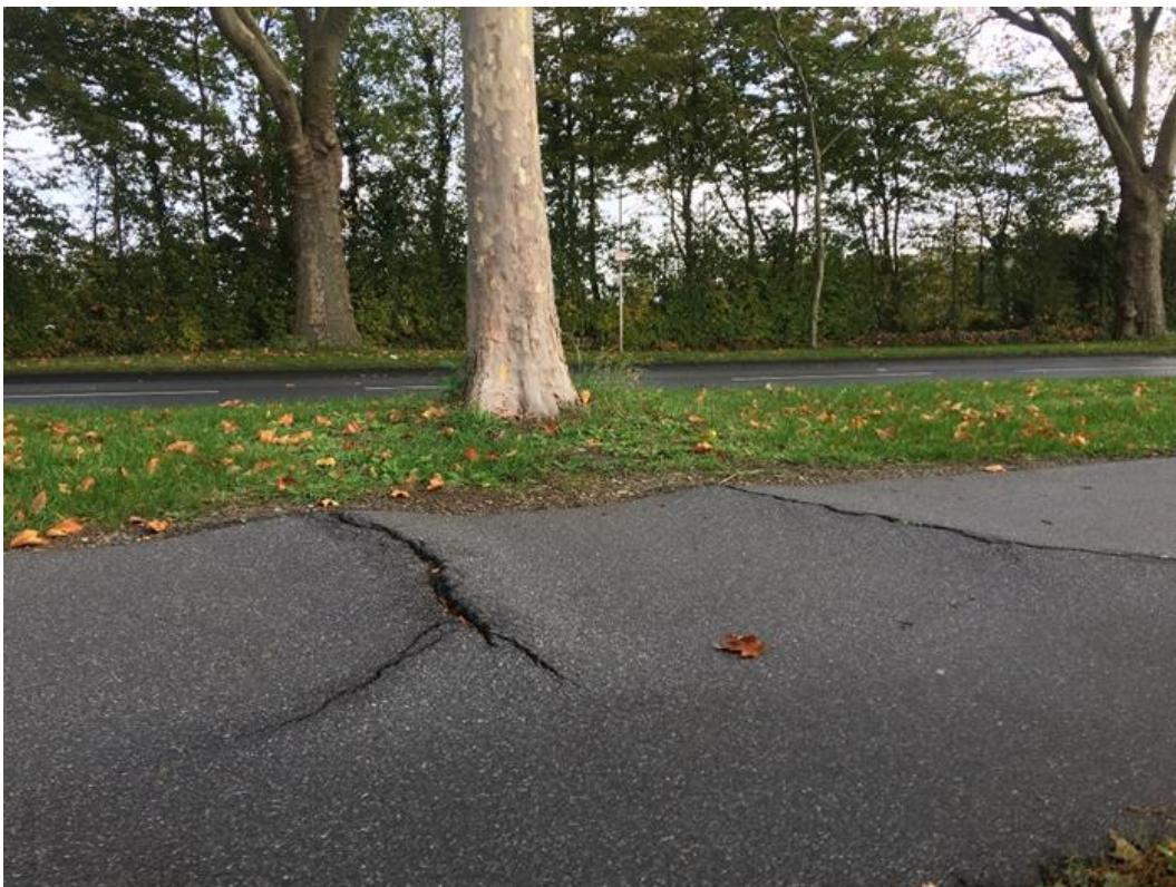
Bild 253: ‚Sprungschanzenbildung‘, Radweg in Asphaltbauweise
