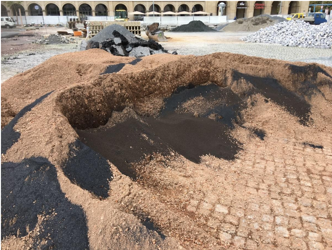
Bild 266: Einmischen von Bodenhilfsstoffen in das Pflanzsubstrat zum Verfüllen der Pflanzlöcher
