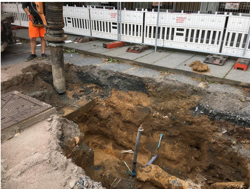
Bild 263: Schonendes Freilegen einer Baumgrube mit dem 'Saugbagger'
