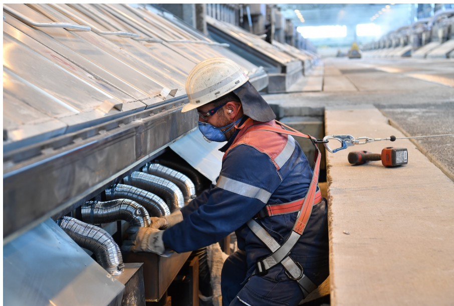
Abbildung 1.3: Arbeiten an den Wärmetauschern, die an einem Ofen installiert sind. Die Wärmetauscher sind direkt an der Ofenwand angebracht und mit davor befestigten Sammelboxen über flexible Lüftungsschläuche verbunden. Das Bild wurde von der TRIMET zur Verfügung gestellt.
