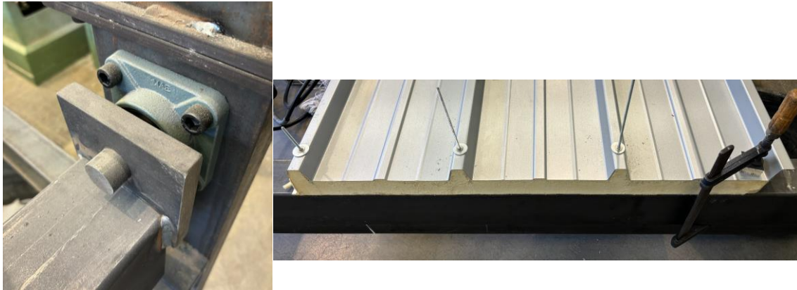
Abb. 3.1.3 Radial-Gelenklager (l.) und Zugsicherung (r.) an den Auflagerachsen
