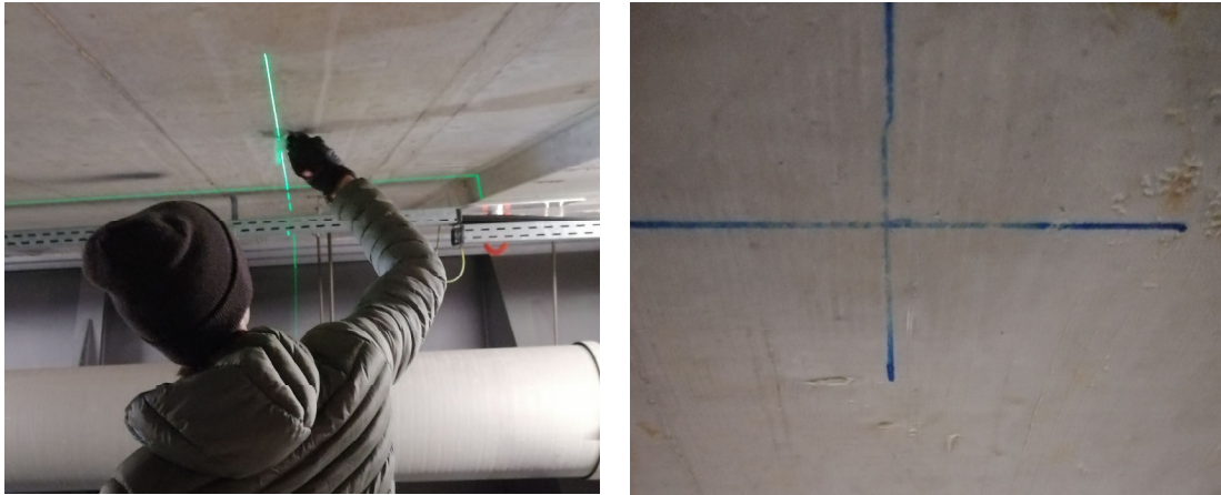
Abb. C.1: Ausrichtung mittels Laser und Oberflächenvorbereitung für anschließende Versiegelung und Applikation
