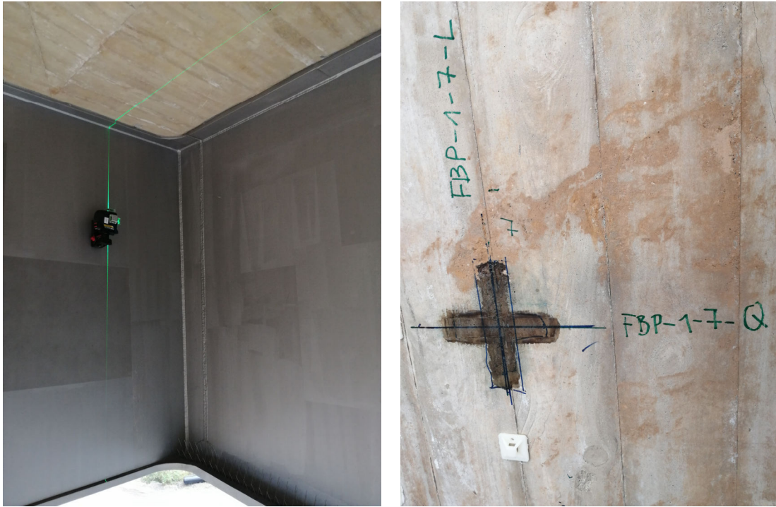
Abb. D.1: Ausrichtung mittels Laser und Oberflächenvorbereitung mit Versiegelung für anschließende Applikation
