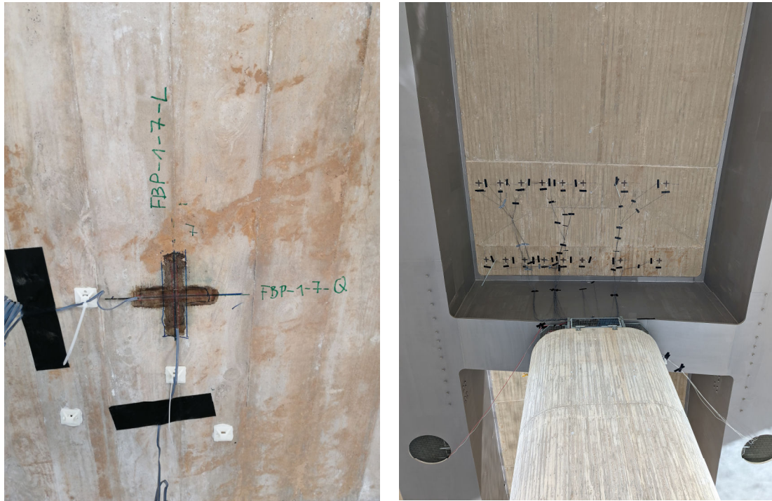
Abb. D.3: Fertiggestellter biaxialer DMS und Übersicht DMS Fahrbahnplatte
