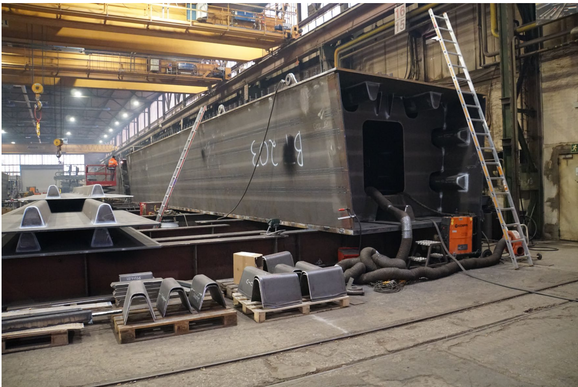
Bild 4.22 Fertigungsabfolge in der Fertigung eines Brückensegmentes Schritt 1: Aufschweißen einer Hohlsteife auf Platte (links im Bild) Schritt 2: Zusammenbau der einzelnen Platten (rechts im Bild)
