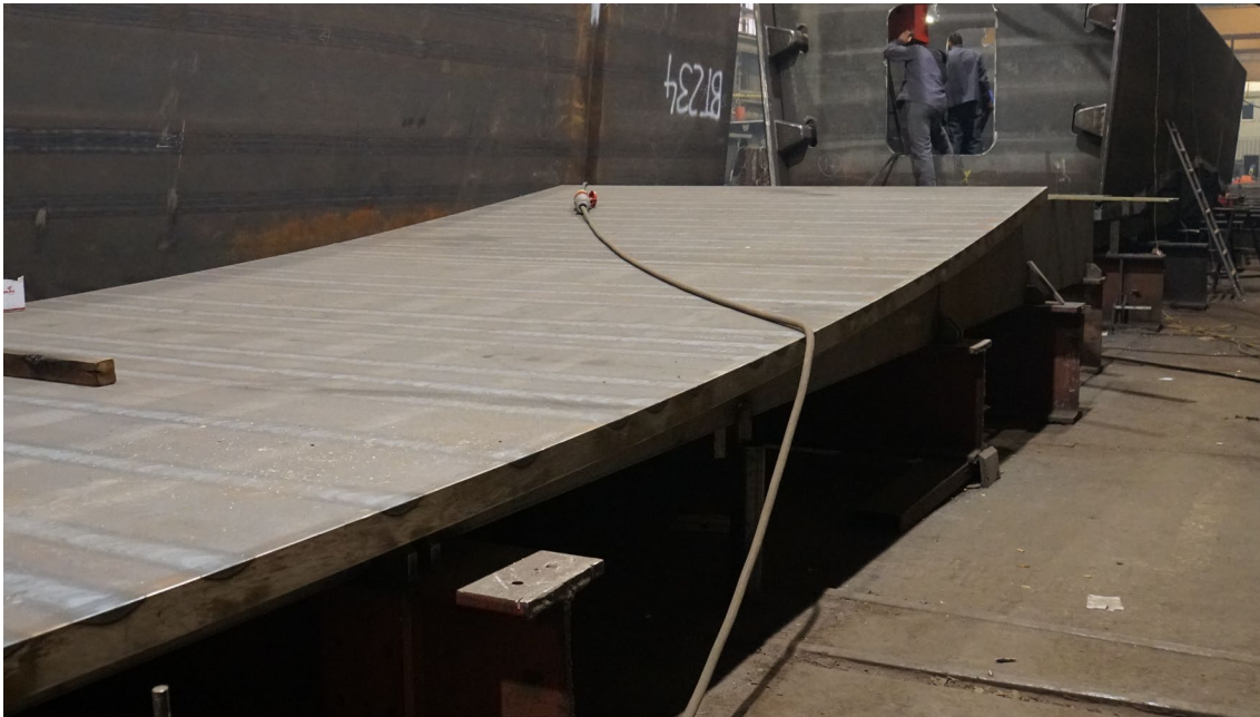
Bild 3.36 Brückengurt mittels Flammrichten in gekrümmte Form gebracht
