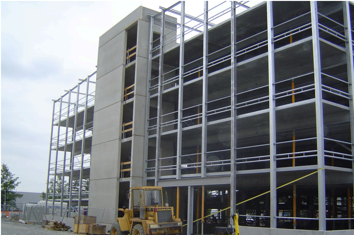
Bild 2.2 Tragwerk mit Scheiben und (Decken-)Platten [84]
