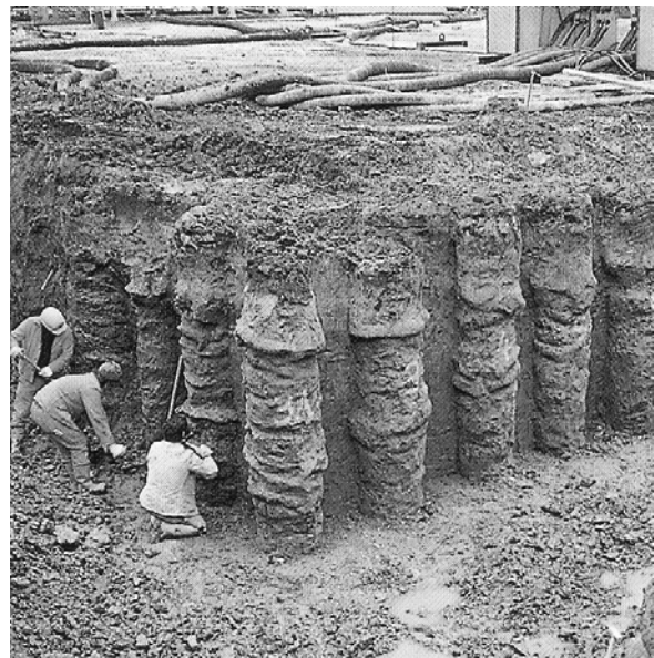
Abbildung 1.2: Freigelegte Erdbetonsäulen
