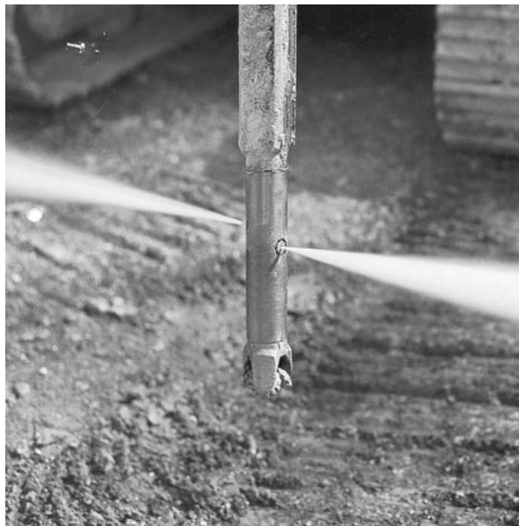
Abbildung 1.1.: Über der Bohrkronen austretender Düsenstrahl
