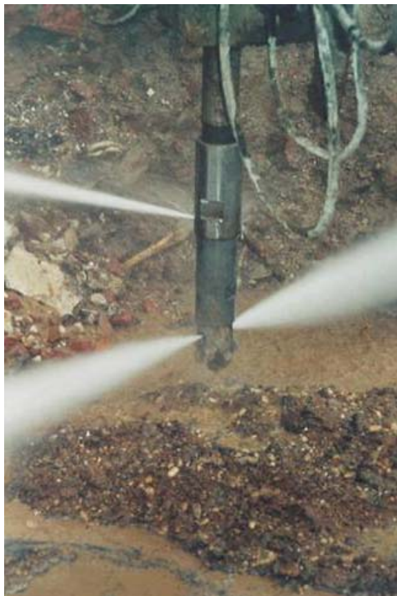
Abbildung 4.4: Bohrkronen mit hinsichtlich der Form unterschiedlich ausgebildeten Düsen
