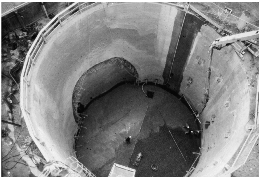
Abbildung 1-1: Spritzbetonschacht als Anfahrschacht
