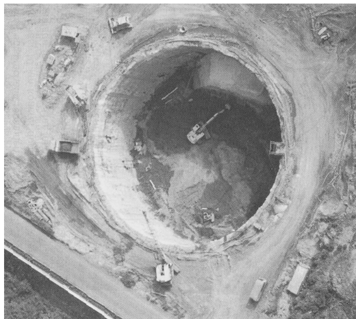
Abbildung 2-1: Schlitzwandschacht in Bottrop [63]
