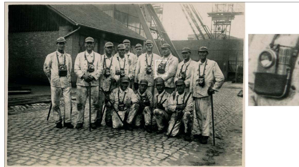
Bild 7: Aufsichtspersonen der Grube Maybach 1/2/3, Friedrichsthal, Saarrevier. Getragen werden CEAG-Lampen; drei Personen tragen eine VAL vom Typ *OKW 4a* (stehend: 1. von links und 3. von rechts; kniend: 2. von links), die übrigen herkömmliche Blitzer vom Typ *OKI*. (Foto aus Privatbesitz)
