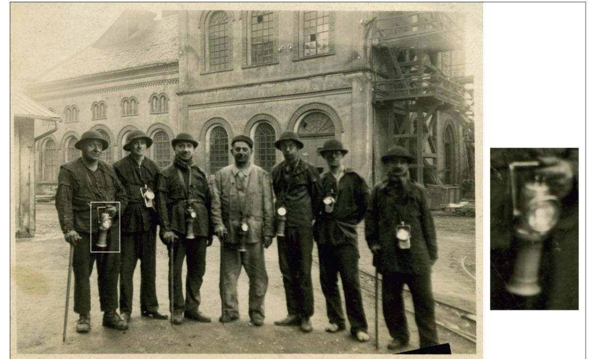
Bild 5: Stolztes Aufsichts- und Ingenieurpersonal vor einer unbekannt Schachtanlage in Belgien, Details zufolge vermutlich im Charleroi-Namur-Revier. Die 1. Person von links trägt eine VAL vom Typ *Nr. 711 (NT I oder NT II)*. (Foto aus Privatbesitz)
