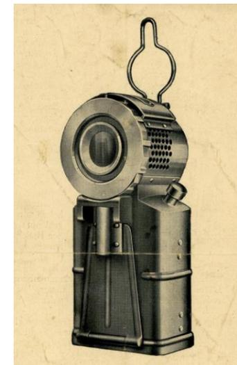
Bild 3: *Wetterlicht III*, Gesamtansicht (Prospekt der GFNI, Kiel: Schlagwetteranzeiger Wetterlicht III, um 1926, S. 1)
