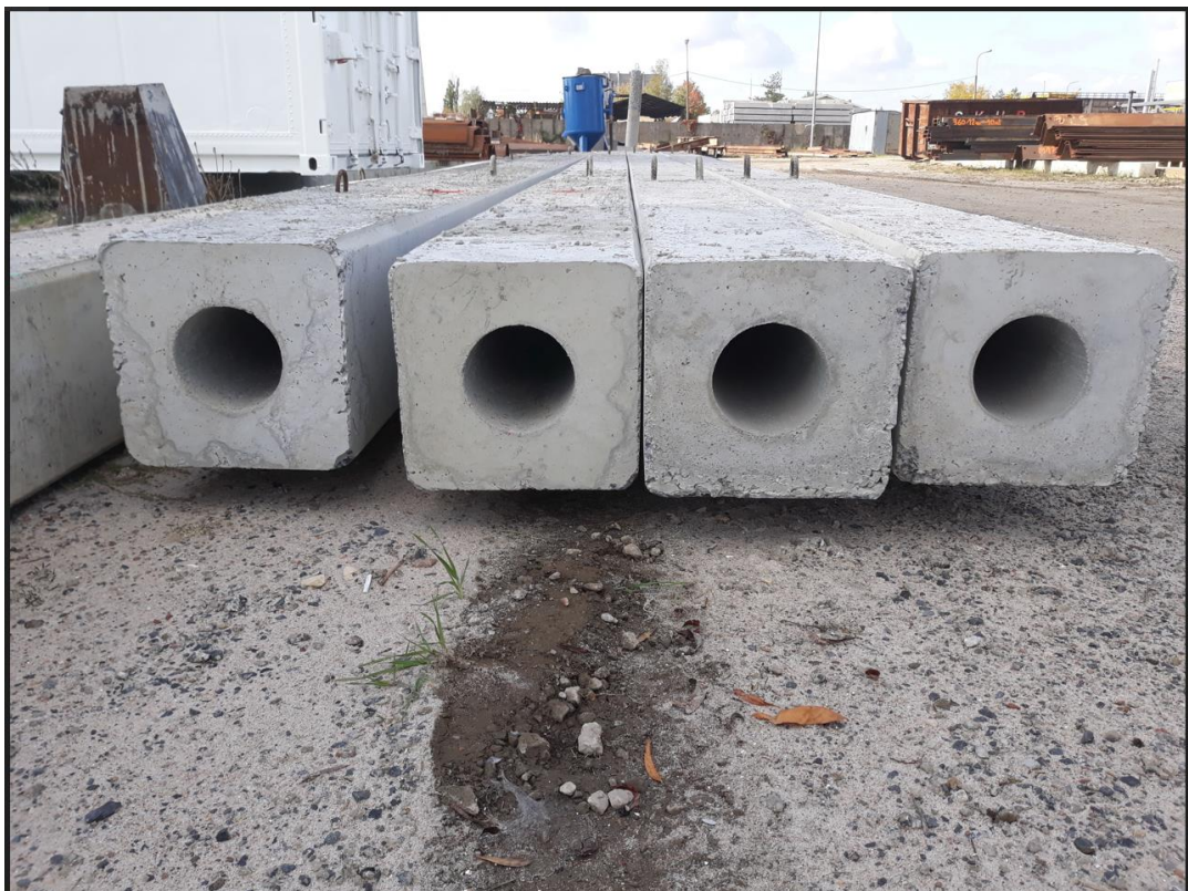
Abb. 1.1: Fertigbetonrammpfahl als Hohlquerschnitt
