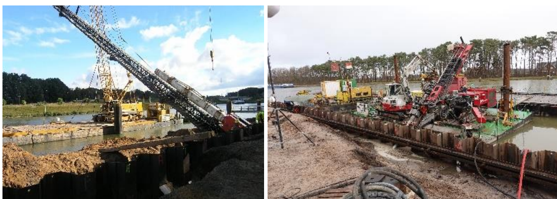
Abb. 2.4: Einbringung der Rückverankerung für die Uferwand in Gleesen (links) bzw. Venhaus (rechts).
