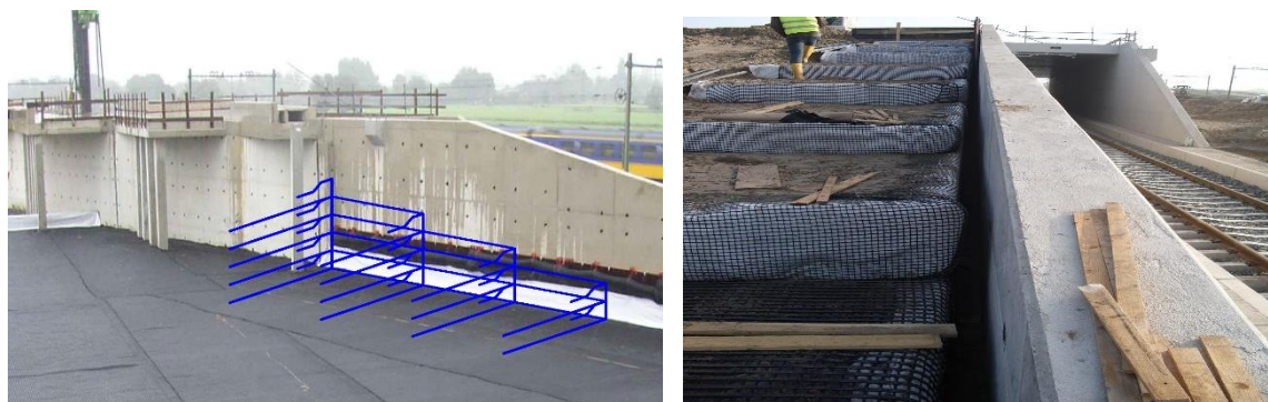
Abb. 4.1: Links: Andeutung der zukünftigen geogitterbewehrte Erdkonstruktion in der Umschlagmethode; Rechts: Geogitterbewehrte Stützwand mit freiem Spalt zur Betonstützwand.
