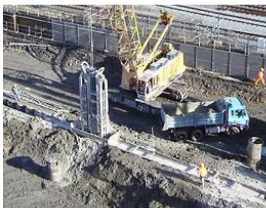
Abb. 3.1: Dichtwandbau im Greiferverfahren mit SOLIDUR
