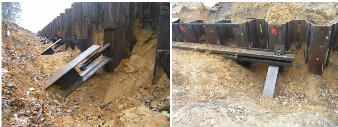
Abb. 2.3: Anschluss der Rückverankerung an die Spundwand in Gleesen
