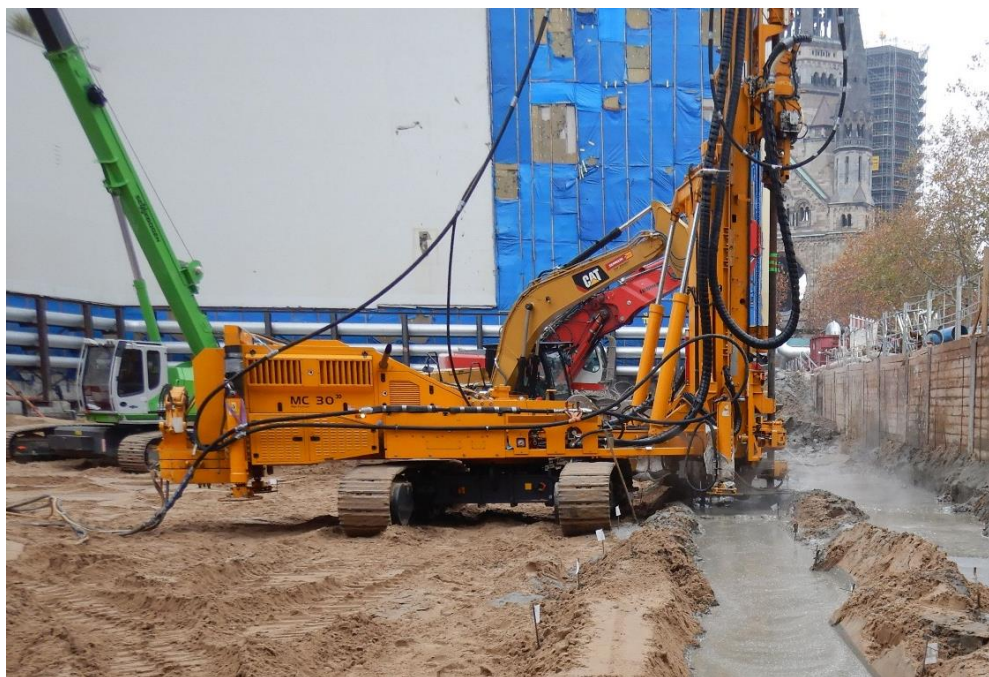
Abb. 2.2: DSV-Herstellung mit Rücklaufgraben (ZÜBLIN SPEZIALTIEFBAU 2019)
