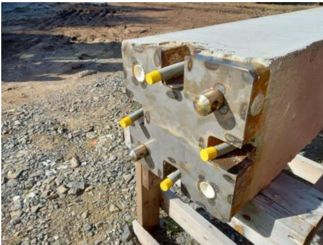
Abb. 1.2: DEP Joint mit Verlängerungsmöglichkeiten der Geothermieleitungen
