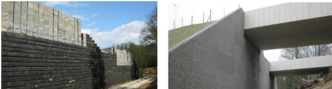
Abb. 4.3: Links: fertiggestellte Brückenwiderlager in Polsterbauweise mit Vorbelastung mittels Betonblocksteinen. Rechts: Fertiggestelltes Brückenwiderlager mit aufgelegten Fahrbahnen und angebrachter Frontverkleidung in Gabionenoptik
