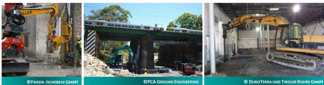
Abb. 4.1: Weniger bauen: Nachgründung mit Pfählen kleiner Durchmesser
