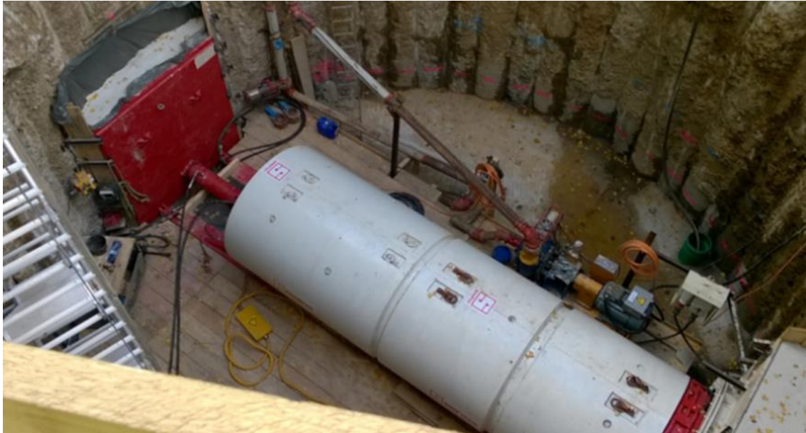
Abb. 3.1: Rohrvortrieb (hier Düker Industriestraße, Freigabe Foto durch Herrn Platten)
