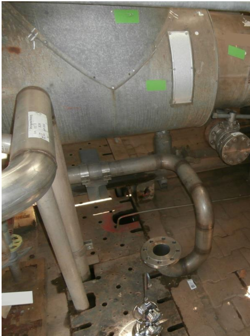
Abbildung 53: Probenahmekanister an Kontrollausgang für Ethylenoxid-fördernde Pumpe (P1)
