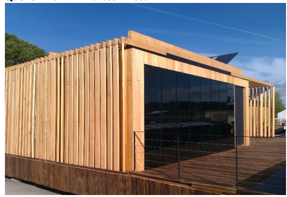
Foto 5.2.3-15: Das Haus SD EU 2012 HTW demonstrierte eine Lösung für die Integration von Solarmodulen in eine Holzfassade. Insgesamt war hier das Verhältnis von Solarkollektorfläche zu Gebäudehüllfläche 0,7. Im Gegensatz zum Haus SD EU 2010 HFT dominieren hier nicht die technischen Solarmodule das äußere Erscheinungsbild.
