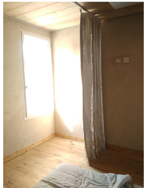
Foto 5.2.3-8: Im Haus SD EU 2019 PLF wurde, wie beim Haus SD EU 2014 DEL, ein Konzept zur Sanierung eines ortstypischen Bestandshauses präsentiert. Eine innenliegende Pufferzone durch einfache Raumabtrennung mittels eines schweren Vorhanges war hier Teil des Optimierungskonzeptes. Quelle: Prof. Dr. Karsten Voss
