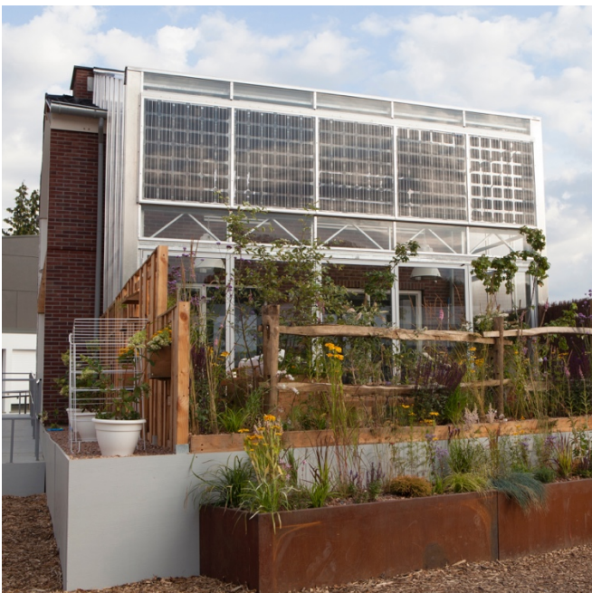
Foto 5.2.3-7: Das Foto zeigt den Wintergarten des Hauses SD EU 2014 DEL. Hier wurde als Teil des Sanierungskonzeptes eines typisch niederländischen Bestandshauses ein Wintergarten vor die Fassade gebaut. Dieser Glasanbau ist zudem im oberen Bereich mit PV-Modulen bestückt. Quelle: (Solar Decathlon Europe), Valeria Anzolin and Jason Flakes
