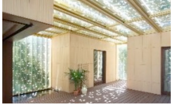
Foto 5.2.3-4: Der außenliegende Sonnenschutz des Hauses SD EU 2014 AND ist ein überdachter Patio, zu dem sich alle Wohnräume öffnen. Zur Verschattung wurden kleine Elemente fest auf dem Dach angebracht. Diese schützen vor direkter Einstrahlung und Blendung ohne abzdunkeln. Quelle: (Solar Decathlon Europe)
