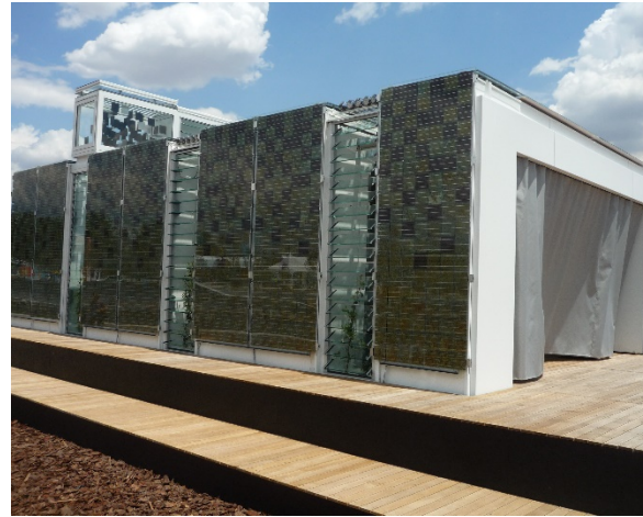
Foto 5.2.3-13: Das Foto zeigt das Haus SD EU 2010 HFT. An diesem Haus wurde das bisher extremste Verhältnis von Solarkollektorfläche zu Gebäudehüllfläche demonstriert (siehe Abbildung 5.2.3-7). Nahezu alle opaken Fassadenflächen wurden mit farbigen, gebäudeintegrierten PV-Modulen (BIPV) verkleidet. Diese farbigen Module wurden neben Solarthermiekollektoren auch auf den Dachflächen verbaut.
