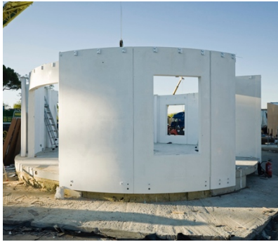
Foto 5.2.2.-1: Beispiel für vorgefertigte Elemente. Das Foto zeigt die einzelnen Wandelemente des Hauses des Teams SD EU 2012 UNI während der Aufbauphase. Quelle: (Solar Decathlon Europe)
