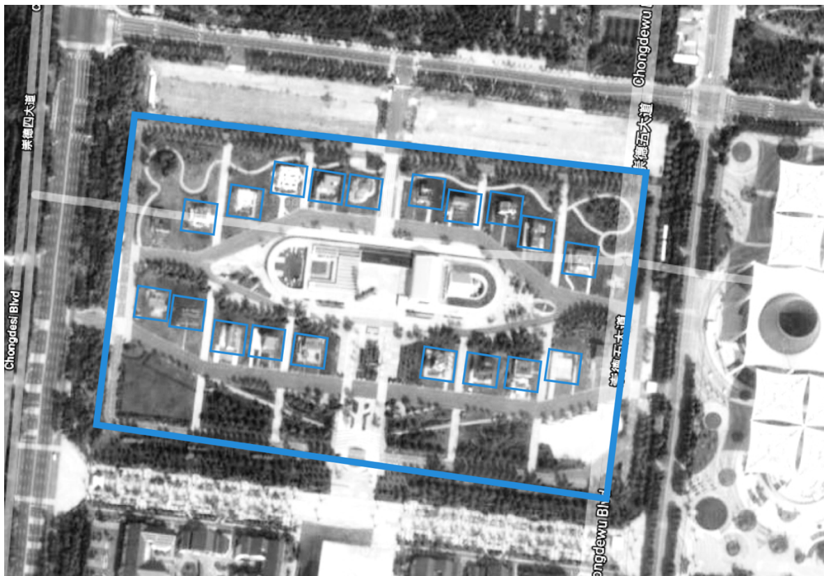
Abbildung 2.2.1-2: Google Earth Aufnahme von August 2021 des SD CN 2018 Eventgelände. Die SD CN 2018 Häuser stehen auch 2021 noch auf dem Gelände in Dezhou, China (37°25'00.8"N 116°25'26.0"E). Die Häuser sind hier blau markiert.
