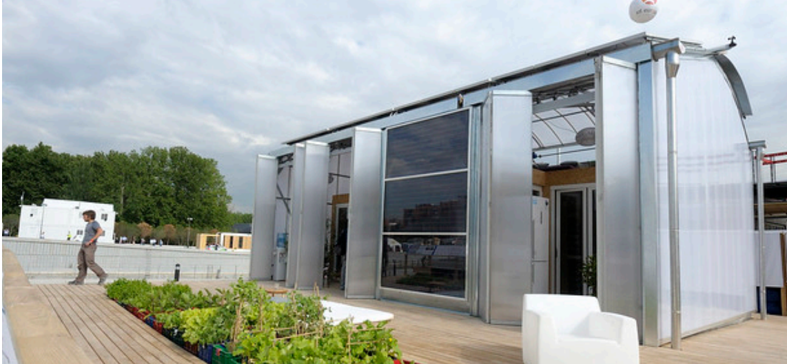
Foto 5.2.3-9: Das Pufferzonenprinzip Box-in-Box wurde vom Team UPC beim SD EU 2010 demonstriert. In diesem Konzept für einen Neubau sind die konditionierten Raumboxen in eine größere, umfassende und nicht konditionierte Halle gestellt. Umwelteinflüsse, wie solare Einstrahlung und Temperaturschwankungen, werden so vollständig von den Wohnräumen abgepuffert. Quelle: (Solar Decathlon Europe)
