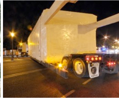
Foto 5.2.2.-3: Beispiel für vorgefertigte große Module. Das Foto zeigt ein Modul in der Größe des gesamten Hauses des Teams SD EU 2010 VGT während der Aufbauphase. Quelle: (Solar Decathlon Europe) Fotograf: Javier Alonso Huerta
