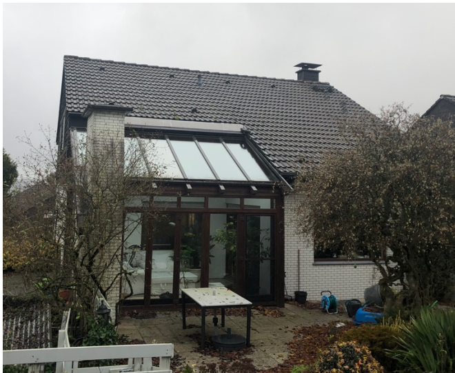
Foto 5.2.3-10: Beispiel eines Wintergartens in der Baupraxis. Dargestellt ist ein Wintergarten aus den 1980er Jahren. Die Bauweisen sind bis heute weiterhin typisch. Quelle: Susanne Hendel
