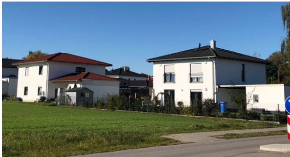
Foto 5.2.3-5: Praxisbeispiel von Rollläden an einem Haus Baujahr 2019. Rollläden sind bestimmendes Sonnenschutzelement an Wohnhäusern in der Praxis. Quelle: Susanne Hendel
