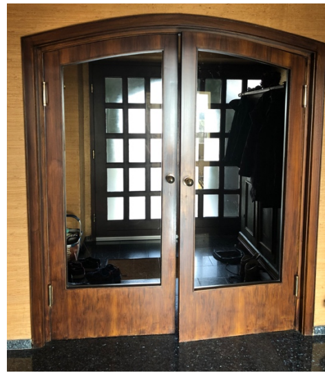
Foto 5.2.3-11: Beispiel eines Windfangs aus der Baupraxis. Hier dargestellt ist ein Beispiel aus ca. den 1960er Jahren. Quelle: Susanne Hendel
