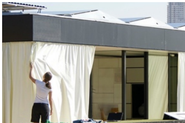
Foto 5.2.3-2: Das Haus SD EU 2012 RWT hat einen textilen Vorhang als außenliegenden Sonnenschutz. Der Vorhang schützt vor direkter Sonneneinstrahlung und somit vor Blendung, ohne die dahinterliegenden Räume vollständig abzudunkeln. Im geschlossenen Zustand ist zwischen der Fassade und dem Vorhang ein Luftraum, der zusammen mit dem Dachüberstand die Innenräume vor Überhitzung schützt.
