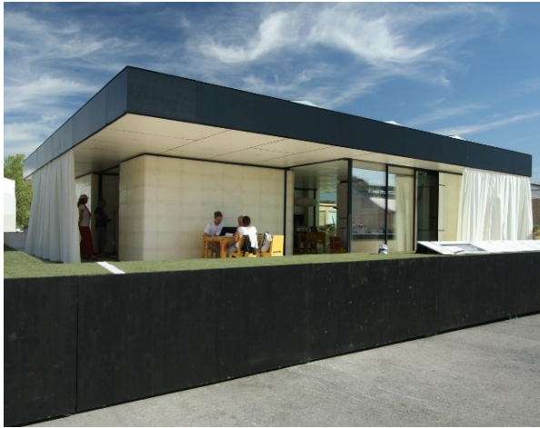
Foto 5.2.3-12: Dargestellt ist das Haus SD EU 2012 RWT. Hier wurden 30 % der Hüllfläche zur Solarenergiegewinnung genutzt. Die Module konnten vollständig auf dem Dach untergebracht werden und sind dank einer hochgezogenen Attika für die Besucher nicht sichtbar.
