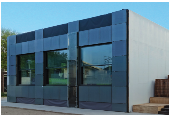
Foto 5.2.3-14: Das Haus SD EU 2019 DEF stellt einen Ausschnitt eines Hochhauses dar. Neben der Dachfläche, die hier nur einen geringen Anteil an der Hüllfläche hat, wird hauptsächlich die Fassade zur Energiegewinnung genutzt. Die Fassade wurde mit gebäudeintegrierten und farbigen PV-Kollektoren verkleidet.
