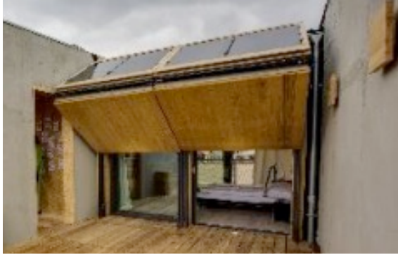
Foto 5.2.3-3: Das Team SD EU 2014 ROF hat ebenfalls auf einen faltbaren außenliegenden Sonnenschutz gesetzt. Dieser kann wie beim Team SD EU 2010 ROS vollständig geöffnet und geschlossen werden. Im Unterschied zum Rosenheimer Modell besteht dieser nur aus zwei Teilen, die geschlossen die gesamte Fassade verdecken. Zudem sind auf dem oberen Teil des Sonnenschutzes PV-Module angebracht. Quelle: (Solar Decathlon Europe)
