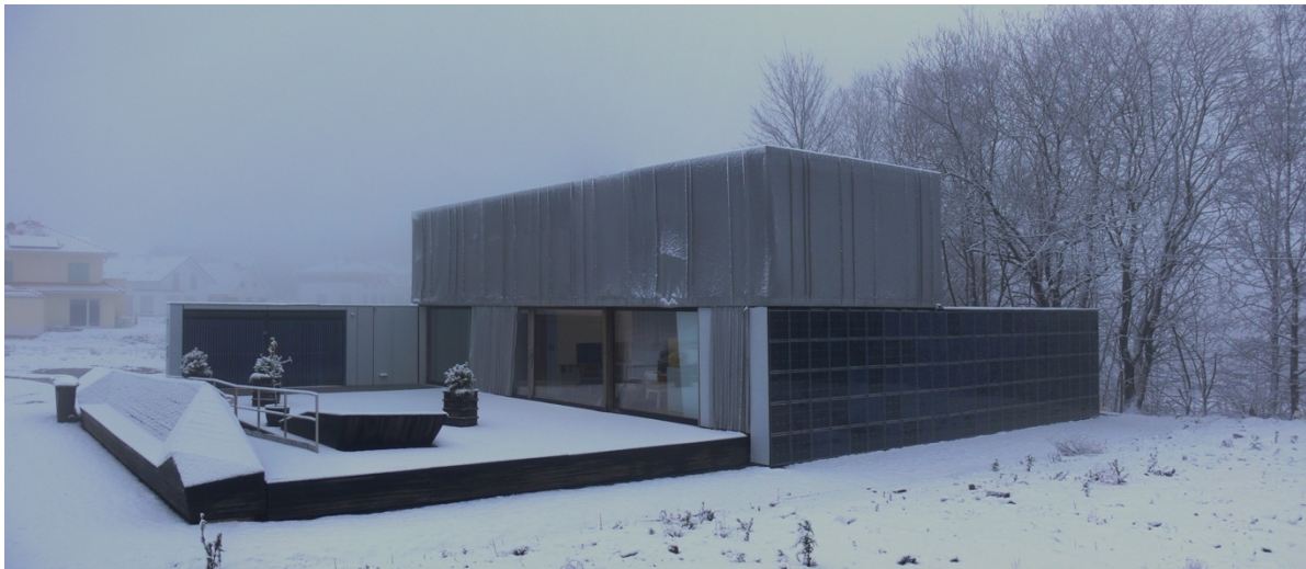
Foto 6.3.3-1: Das Haus SD EU 2010 BUW während der Nachnutzung am Standort Wuppertal. Quelle Uni Wuppertal, Lehrstuhl b+Tga, Julius Otto
