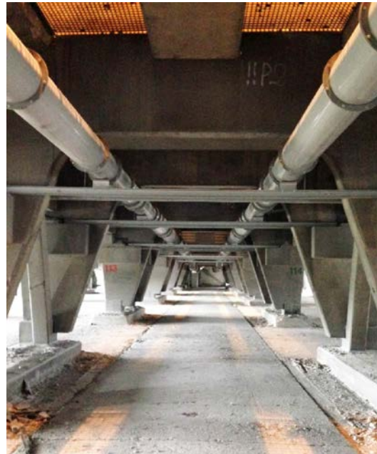
Abbildung 2.29: Installation der Wärmetauscher am Ofen und Wärmetransportsystem unter der Zelllinie [93]
