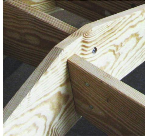
des Hebelstabwerks muss die Kopfseite zusätzlich im richtigen Winkel angeschrägt und der Stab auf die richtige Länge gebracht werden. Der Bildausschnitt oben zeigt eine entsprechende Verbindungsstelle am CRR-Pavillon 2015 (BUW/FB Architektur/TWL).
