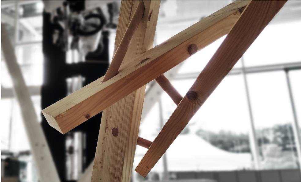
**Abb. 13\_ Knotenkonstruktion mit Holzdübeln**
