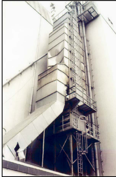
Bild A.2: Außenansicht vom Brand betroffener Trockner [NACHTW,2005]
