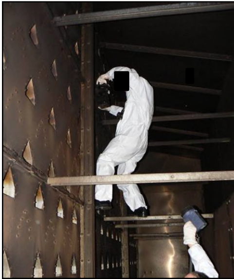
Bild 3.15: Ungesicherter Aufstieg Bild 3.16: Aufstiegsmöglichkeit abluftseitig
