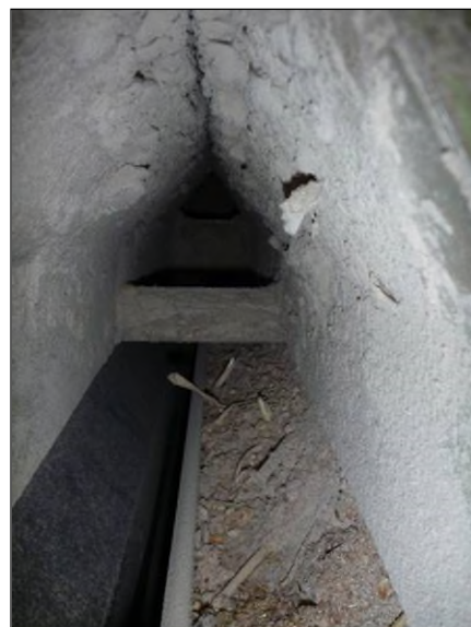
Bilder 3.4 und 3.5: Ablagerungen in „leerer“ Trocknungsanlage
