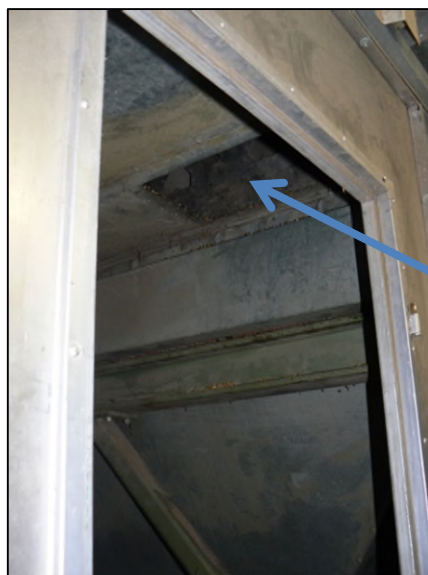
Bild 4.3: Zutrittsöffnung in Zuluftschacht (ca. 40 cm x 70 cm)
