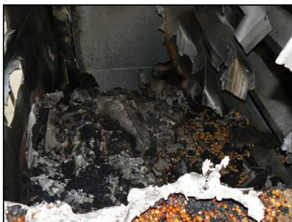
Bild A.13: Blick in ausgebrannte Kaskaden I
