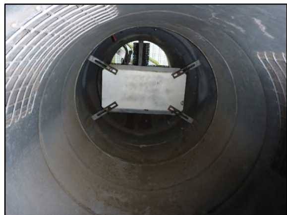
Bild 3.12: Teilabdeckung eines Kreuzbrenners mittels Prallblech
