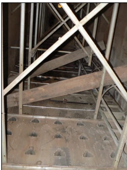
Bild 4.2: „Arbeitsbühnen“ im Trocknerabluftschacht
