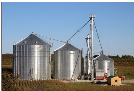
Bild 4.5: Silos mit Trocknungsanlage
