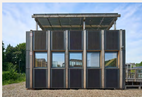
Abb.11 und 12: Fassade Haus Biberach Vollholzbretter aus Fichte, oben im Jahr 2022, unten 2025.
