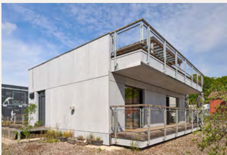
Abb.3 und 4: Fassade Prag aus Faserzement-Paneelen, oben im Jahr 2022, unten 2025.
