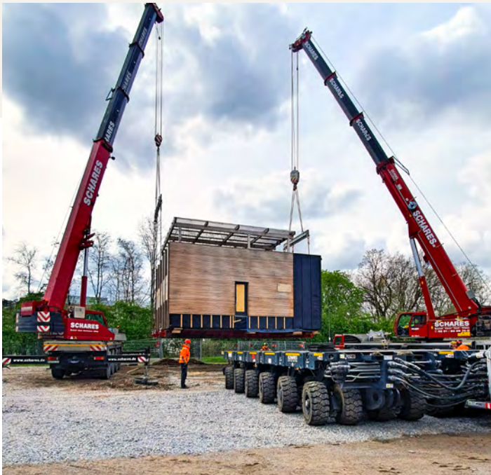
Versetzen des Hauses X4S aus Biberach um ca. 300 Meter an den neuen Standort im Living Lab NRW.
