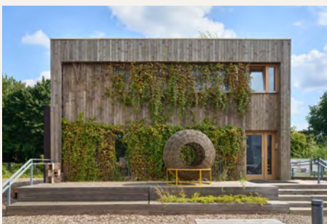
Abb.9 und 10: Fassade Haus Pécs aus vertikal verbauter geriffelter Lärche, oben im Jahr 2022, unten 2025.
