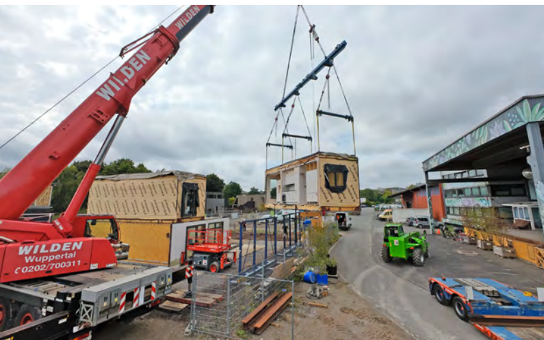
Abbildung 1: Rückbau und Abtransport der Module des Hauses SUM, Delft © Living Lab NRW
