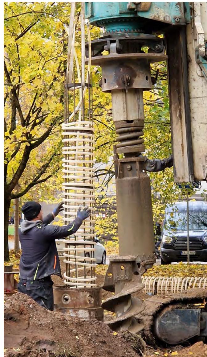
Abbildung 8: Einbringen eines Erdkorbs am Standort des RoofKIT © Team RoofKIT
