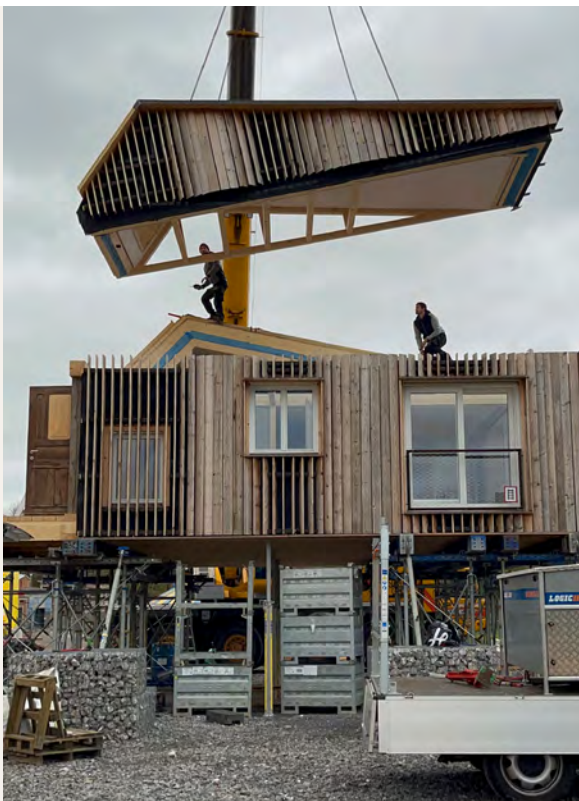
Abbildung 2: Abbau des Holzmodulbaus © Professur Nachhaltiges Bauen
