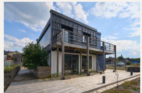
Abb.7 und 8: Fassade Delft aus Platten hergestellt aus landwirtschaftlichen Reststoffen, oben im Jahr 2022, unten 2025 bereits demontierter Zustand.
