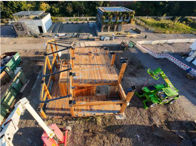
Abbildung 6: Rückbau und Erhalt der Primärkonstruktion aus Holz © Living Lab NRW
