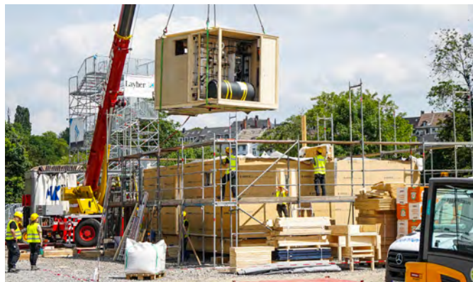
Aufbauphase der 16 Demonstrationsgebäude auf dem Solar Campus © SDE 21/22
