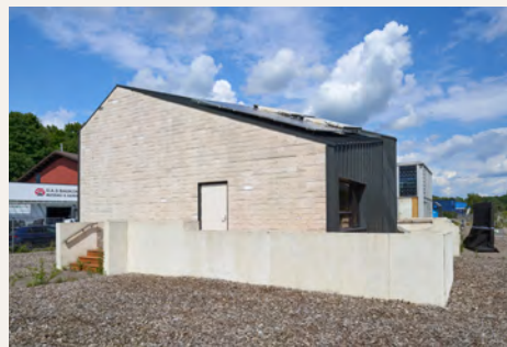
Abb.5 und 6: Fassade Taiwan aus Kacheln hergestellt aus recyceltem Kunststoff, oben im Jahr 2022, unten 2025.
